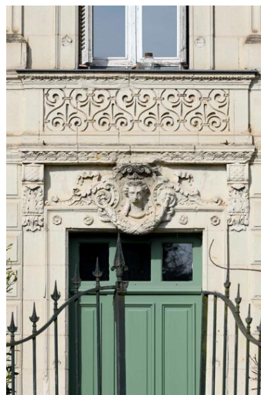
Détail du décor de l'entrée principale. Phot. Armelle Maugin IVR52_20254900203NUCA
