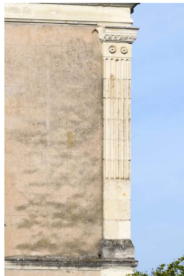
Détail d'un pilastre d'angle.
