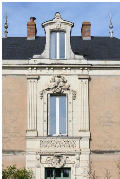
Détail de la travée centrale et de la lucarne. Phot. Armelle Maugin IVR52_20254900202NUCA
