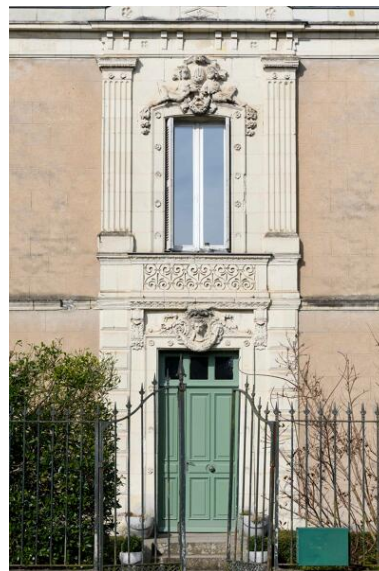
Détail de la travée centrale. Phot. Armelle Maugin IVR52_20254900201NUCA
