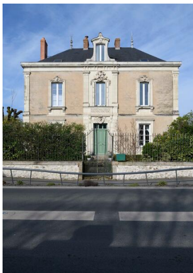
Vue de la façade principale. Phot. Armelle Maugin IVR52_20254900200NUCA
