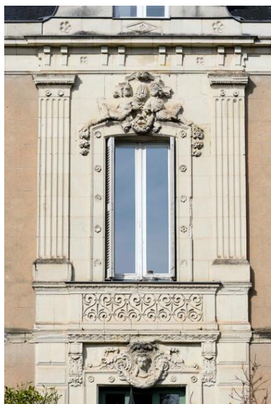
Détail du décor de la travée centrale de l'étage carré. Phot. Armelle Maugin IVR52_20254900204NUCA
