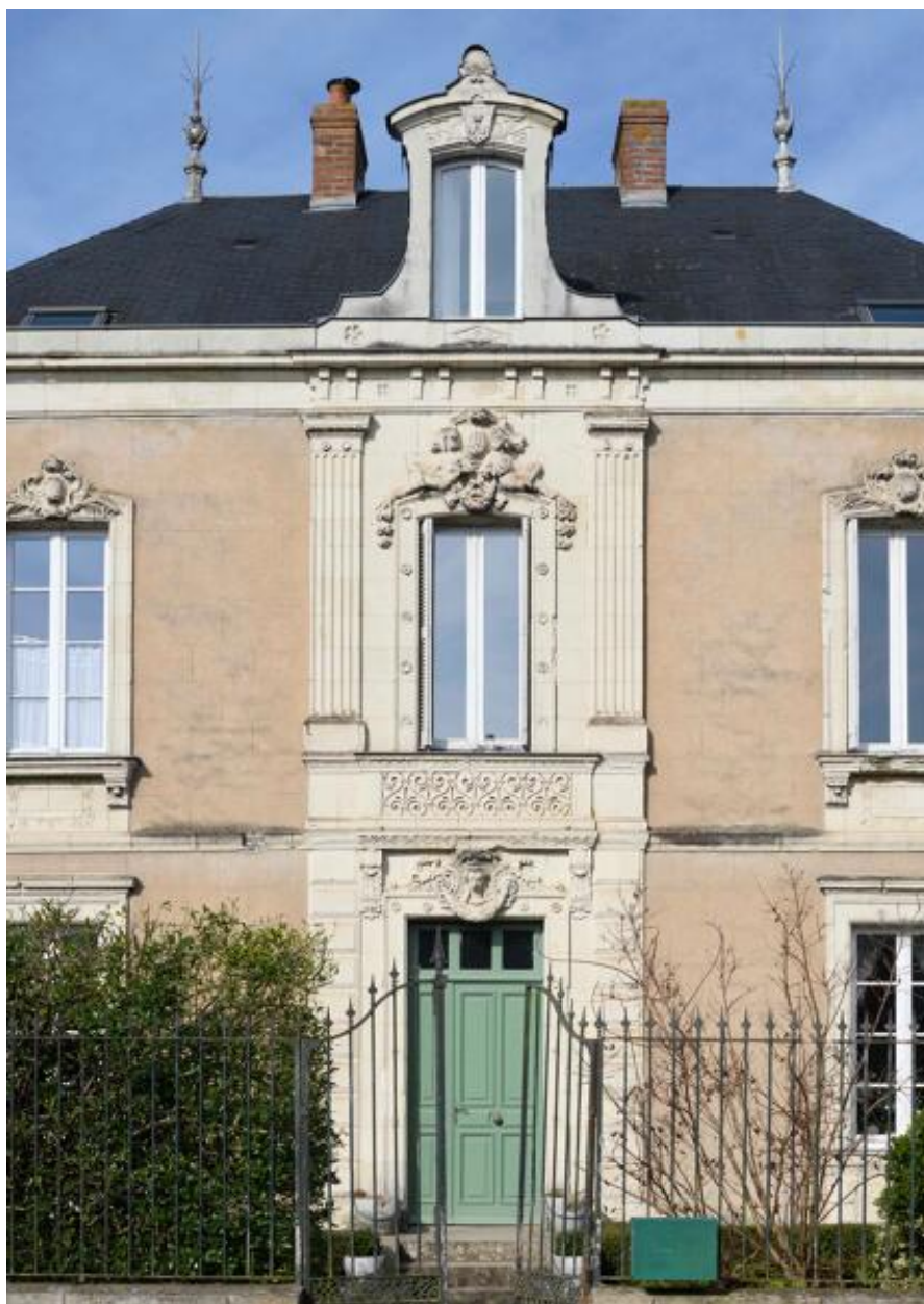
Détail de la façade principale.
