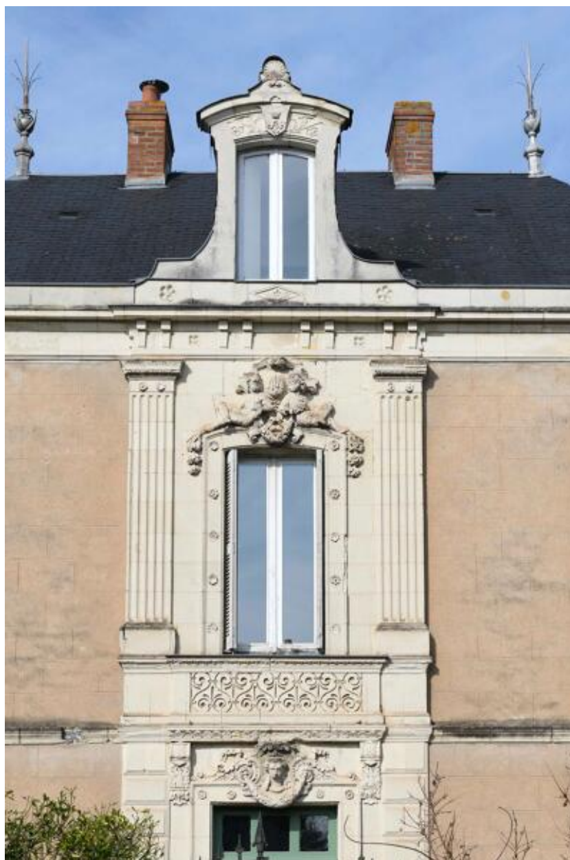
Détail de la travée centrale et de la lucarne.
