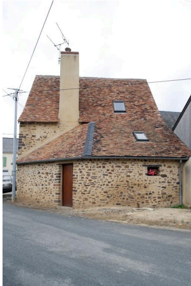
Vue depuis l'angle formé par la rue du Bas-Château et le chemin du laurier. Phot. François Lasa IVR52_20055302107NUCA
