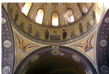
Le tambour, détail de la partie sud. Phot. Denis Pillet IVR52_20034401545NUCA
