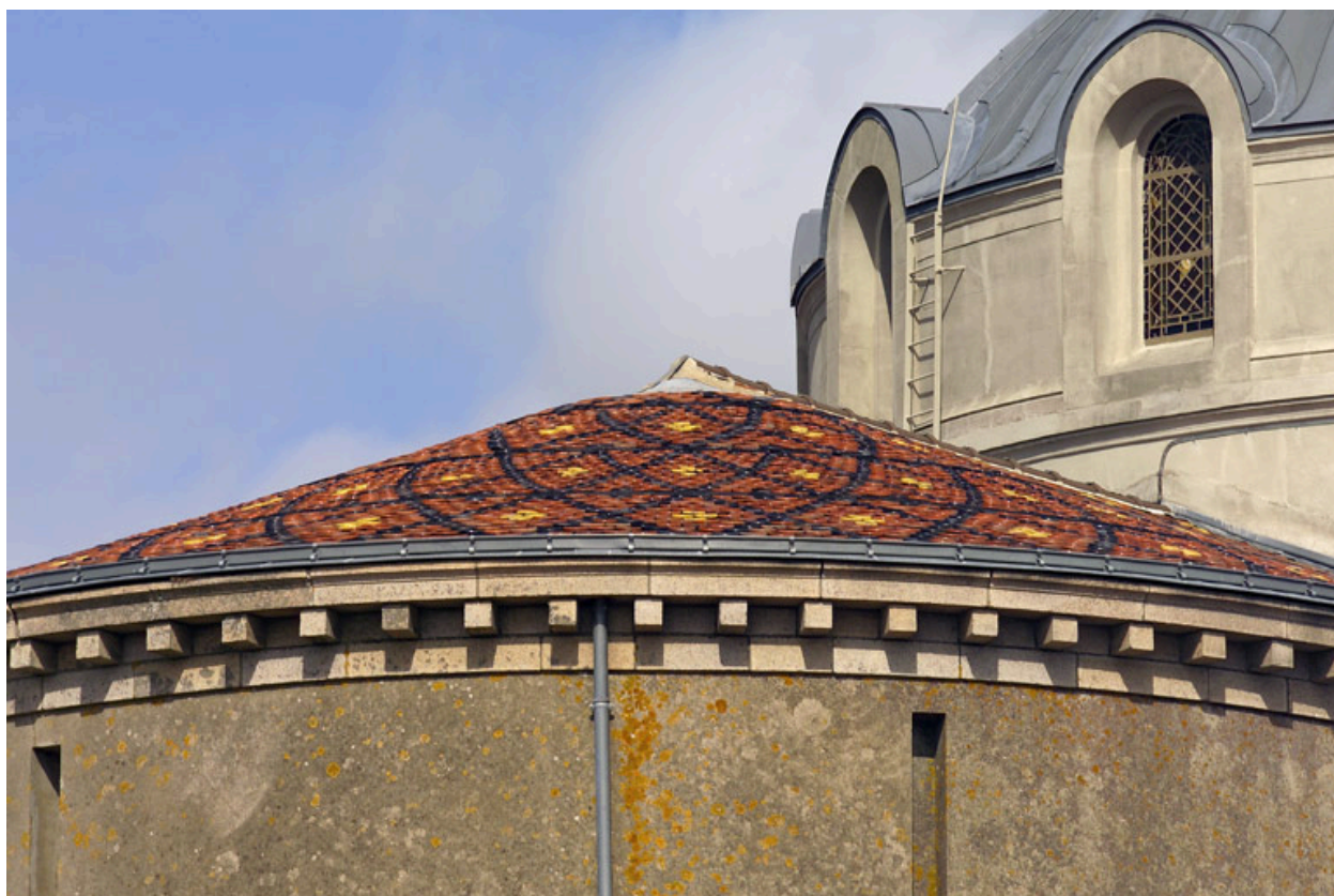
La couverture de l'abside, détail.
