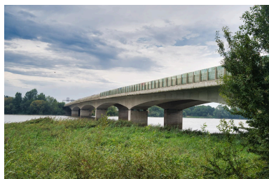
Vue générale du pont. Phot. Patrick Jean IVR52_20214400502NUCA
