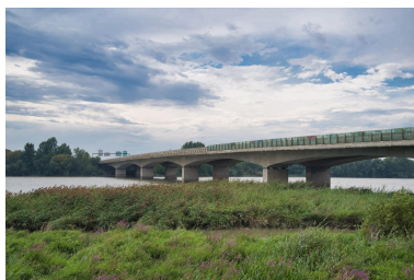
Vue générale du pont de Bellevue et de la Loire. Phot. Patrick Jean IVR52_20214400501NUCA
