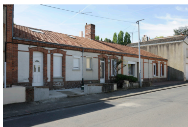
Maisons ouvrières de la Société Anonyme de Chaussures : rue de Bretagne. Phot. Bruno Rousseau, Phot. Youenn Communeau IVR52_20114901117NUCA
