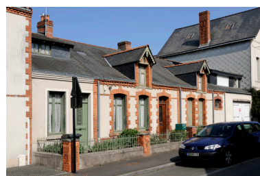
Maisons ouvrières de la Société Anonyme de Chaussures : rue Jeanne d'Arc. Phot. Bruno Rousseau, Phot. Youenn Communeau IVR52_20114901323NUCA
