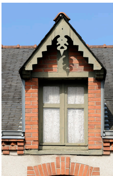
Maisons ouvrières de la Société Anonyme de Chaussures, rue Jeanne d'Arc : détail d'une lucarne. Phot. Bruno Rousseau, Phot. Youenn Communeau IVR52_20114901324NUCA
