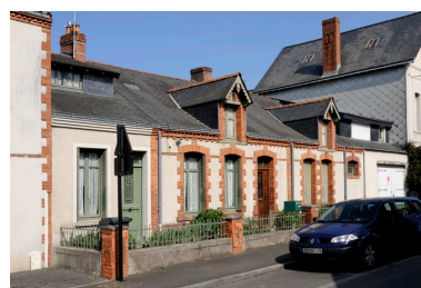
Maisons ouvrières de la Société Anonyme de Chaussures : rue Jeanne d'Arc. Phot. Bruno Rousseau, Phot. Youenn Communeau IVR52_20114901323NUCA
