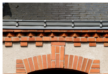
Maisons ouvrières de la Société Anonyme de Chaussures, rue Jeanne d'Arc : détail de la corniche et de l'encadrement d'une baie. Phot. Bruno Rousseau, Phot. Youenn Communeau IVR52_20114901325NUCA
