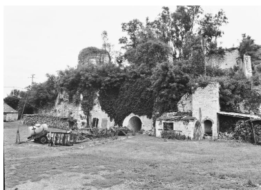
Vue d'ensemble du massif des fours, façade sud, Foussais-Payré (Vendée). Phot. Bernard Renoux IVR52_19908500287X
