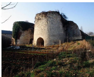
Elévations des deux fours sud-est, Chantonay (Vendée). Phot. Bernard Renoux IVR52_19908500303XA
