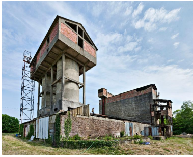
Usine de chaux, Téloché (Sarthe). Phot. Yves Guillotin IVR52_20157201833NUCA
