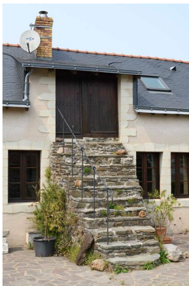
Escalier d'accès au comble. Phot. Armelle Maugin IVR52_20254900689NUCA
