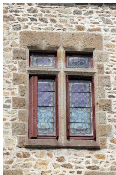
Détail de l'élévation est de la maison : fenêtre nord de la chambre principale. Phot. François Lasa IVR52_20065300704NUCA
