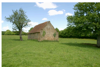
L'étable vue depuis le nord. Phot. François Lasa IVR52_20035301753NUCA
