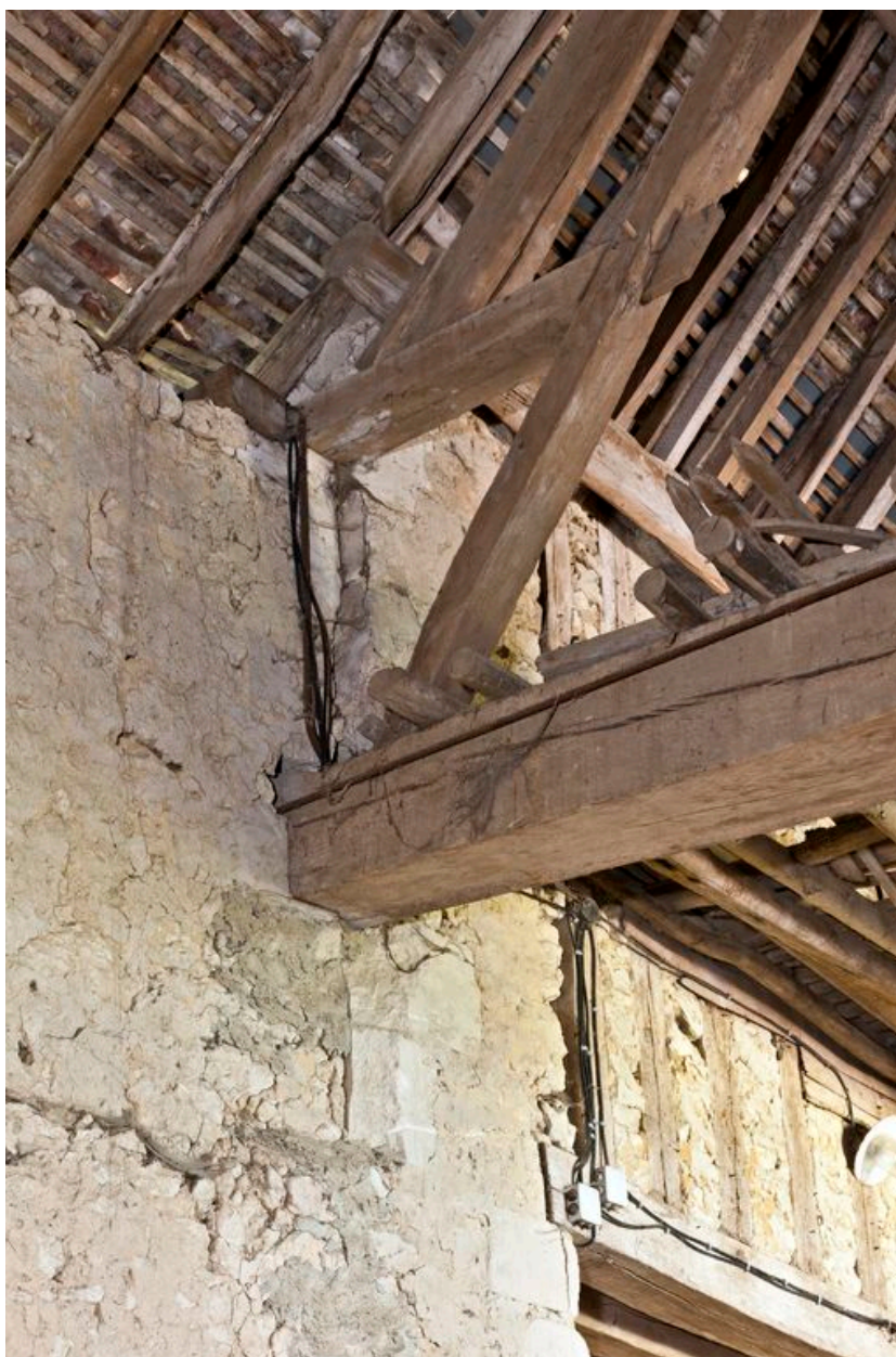
Détail de l'élévation intérieure : chaîne d'angle postérieure gauche du colombier et surélévation de l'élévation antérieure de la grange-étable-fenil
