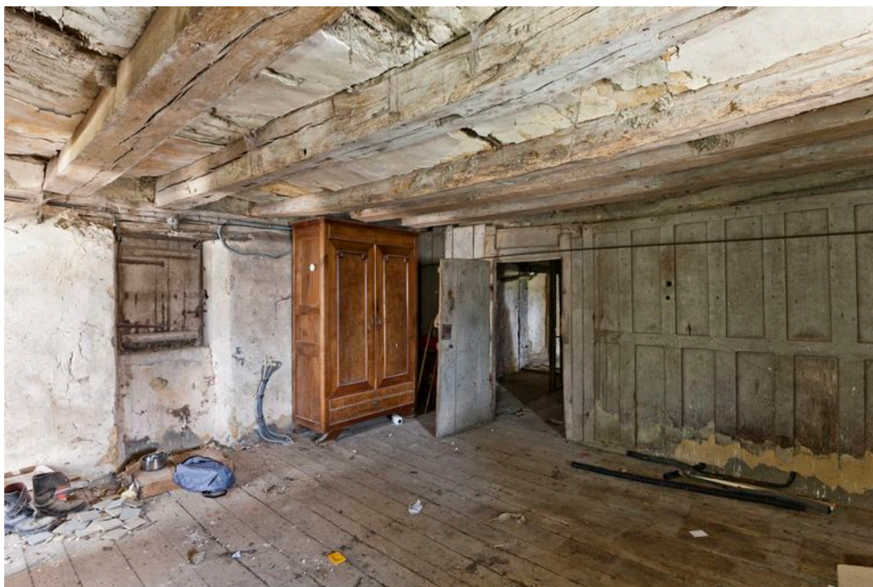
Vue intérieure de la pièce 1 : fenêtre passante dans l'élévation postérieure et porte vers la pièce 2
