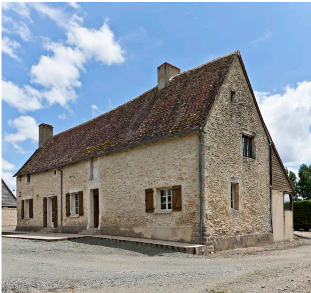
Le logis vu du nord-ouest
