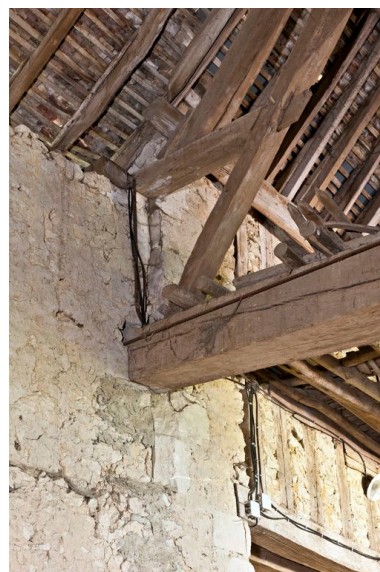
Détail de l'élévation intérieure : chaîne d'angle postérieure gauche du colombier et surélévation de l'élévation antérieure de la grange-étable-fenil Phot. Yves Guillotin IVR52_20137200516NUCA
