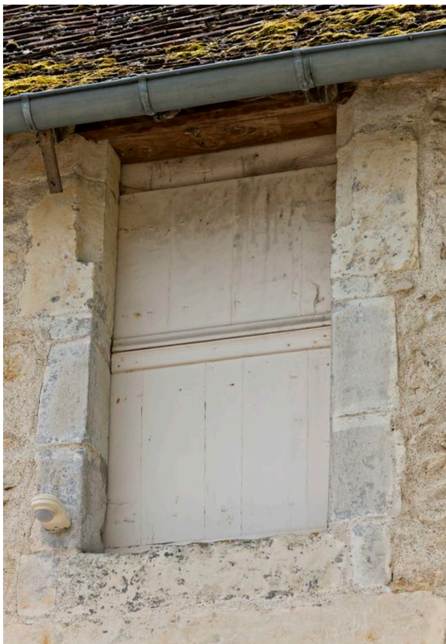
Ancienne fenêtre passante droite de l'étage du logis, abaissée en porte haute.
