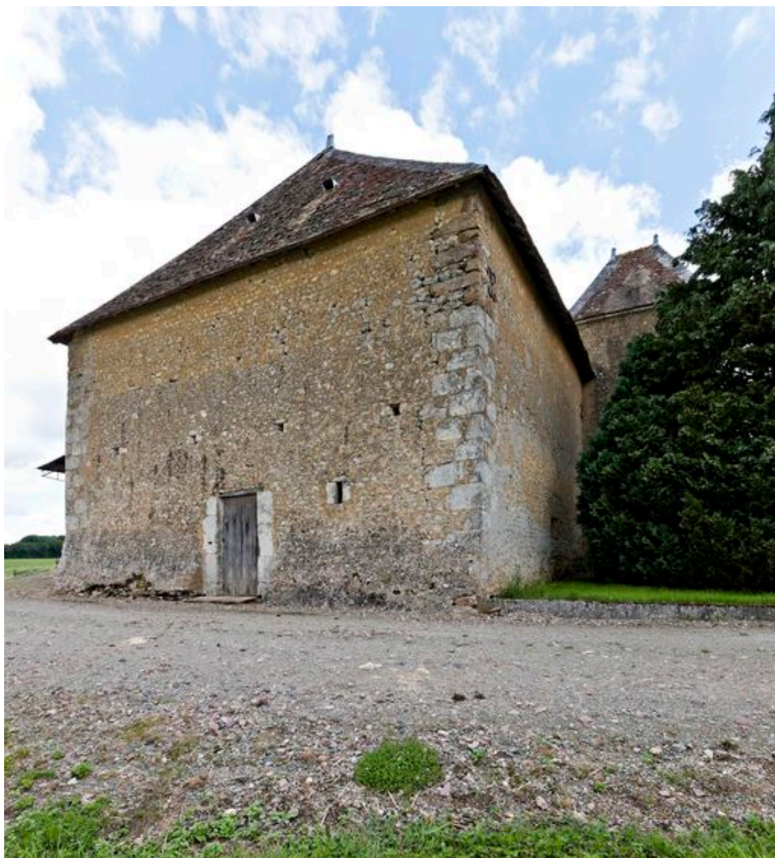
mur-pignon gauche de la grange-étable-fenil
