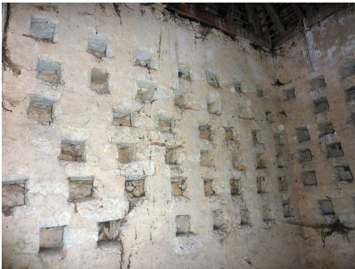
Vue intérieure du pigeonnier : état en 2010
