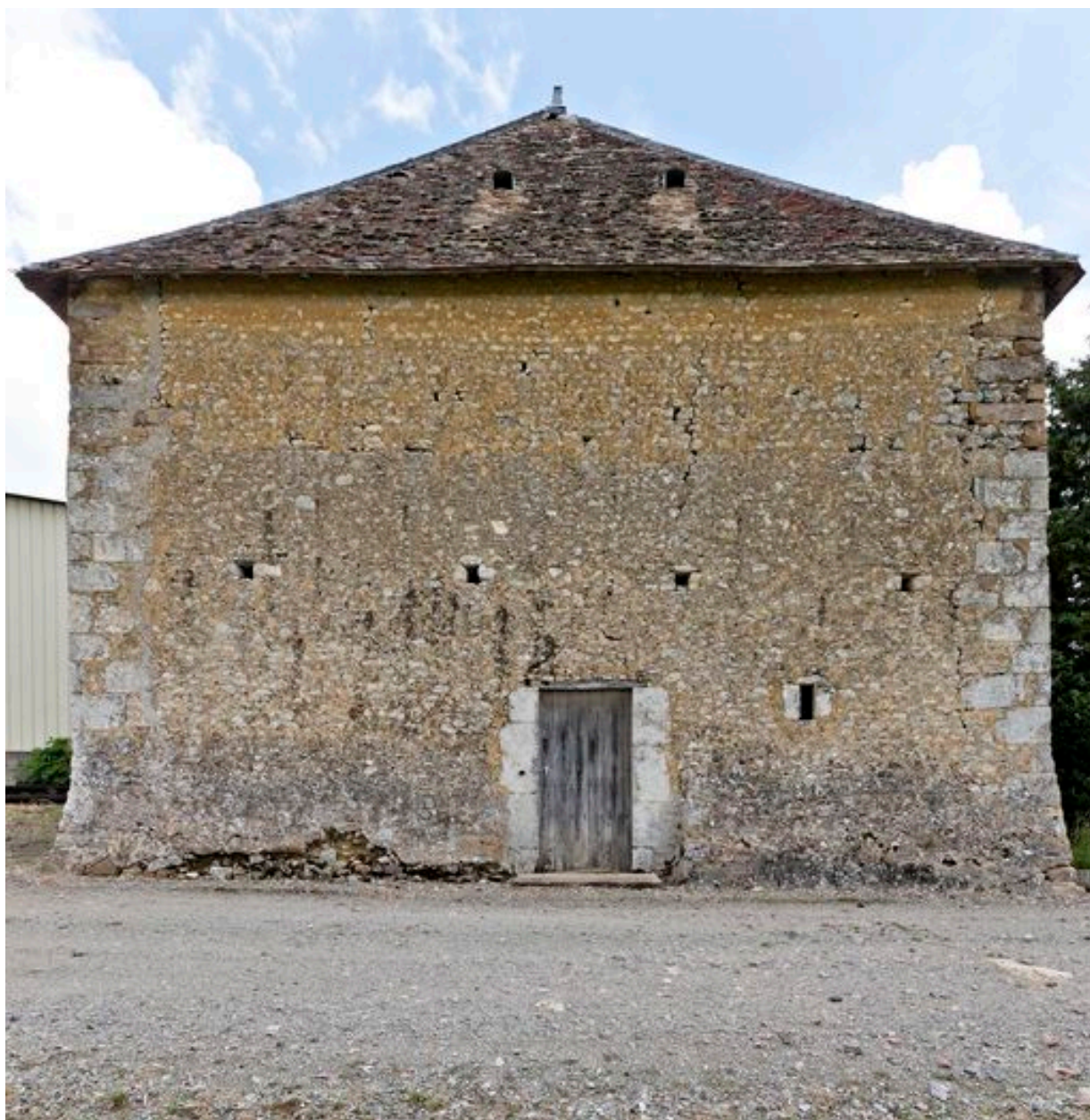
Mur-pignon gauche de la grange-étable-fenil
