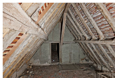
Vue de la charpente de comble du logis Phot. Yves Guillotin IVR52_20137200541NUCA
