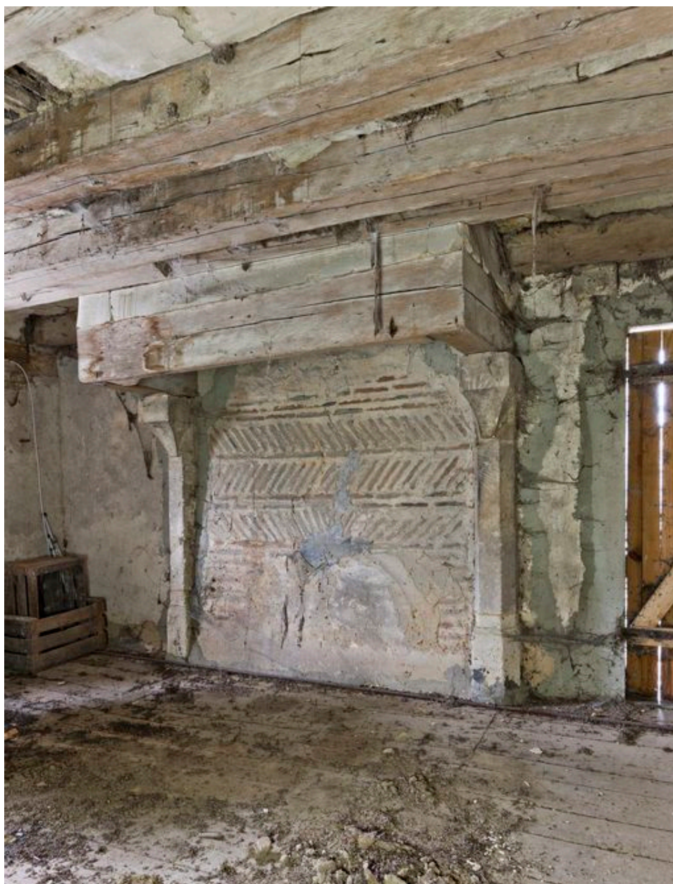
Cheminée de la pièce 1
