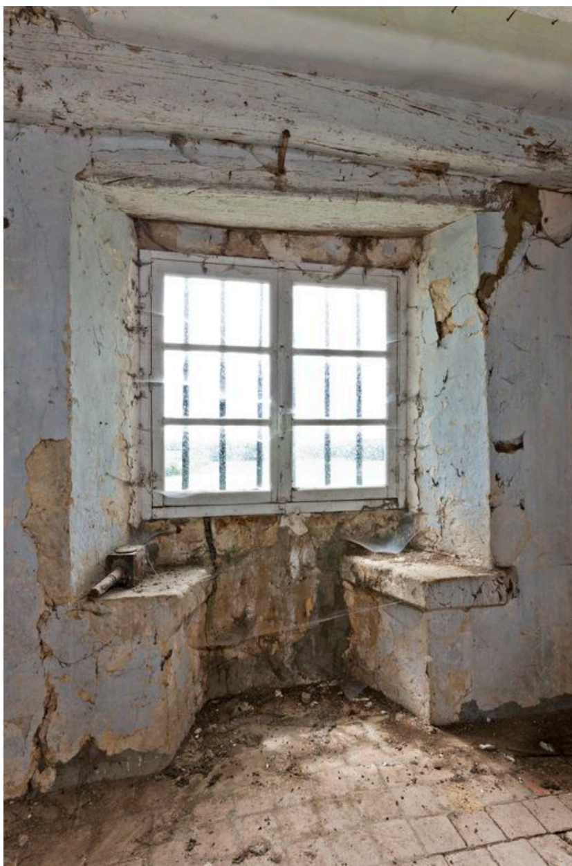
Fenêtre à coussièges de la pièce 4, percée dans le mur pignon droit
