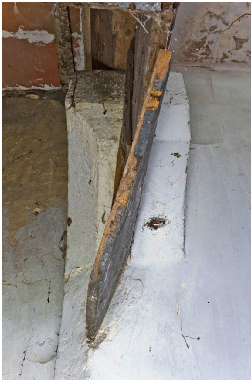
Console droite de la cheminée de la pièce 4, recoupée par la joue en bois de l'abat-fumée
