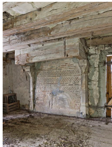
Cheminée de la pièce 1 Phot. Yves Guillotin IVR52_20137200526NUCA
