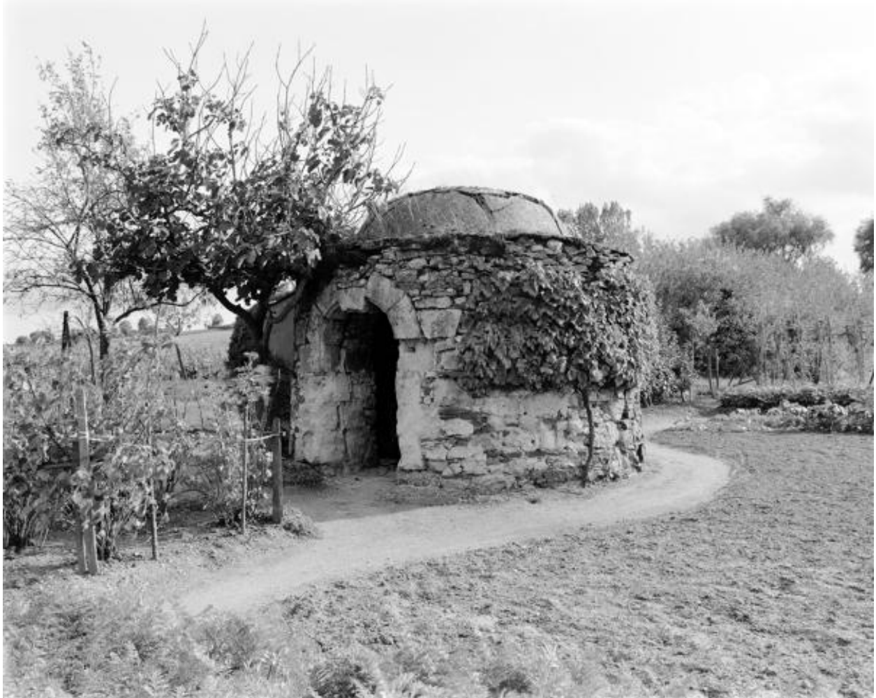
La poudrière vue depuis le nord-ouest, Le Petit Lapin, Montjean-sur-Loire.
