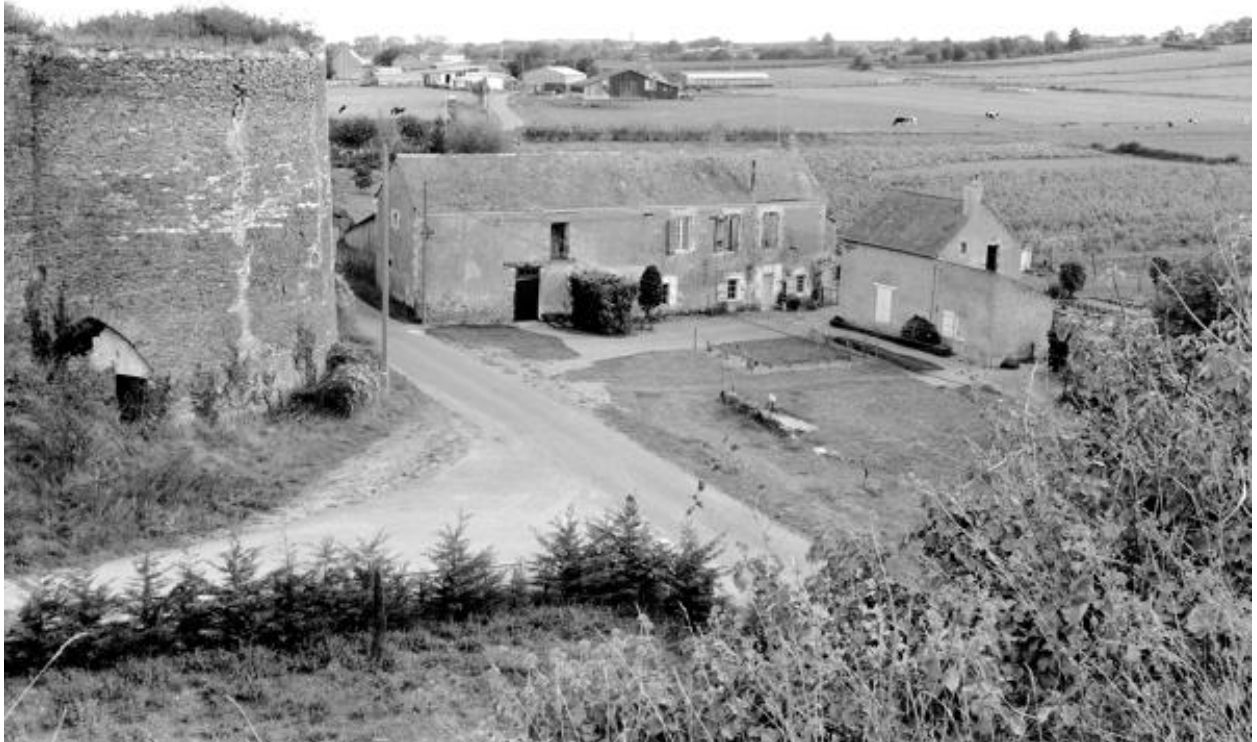
Four du Lapin et bâtiments sud-est, vue depuis le nord-ouest, Montjean-sur-Loire.
