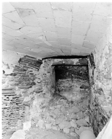
Intérieur de l'ébrasoir nord-ouest du four du Lapin, voûte segmentaire en tuffeau rapportée, et porte de déchargement, Le Petit Lapin, Montjean-sur-Loire. Phot. Bruno Rousseau IVR52_19854901734X
