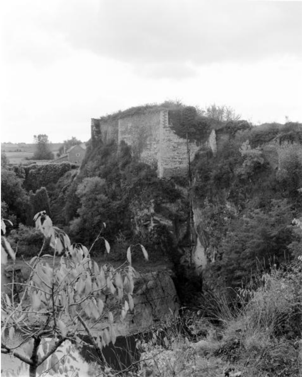
Vue depuis le nord-est, au premier plan, la carrière, au second plan, le four du Lapin avec sa plateforme postérieure, sa rampe et des vestiges de l'élévateur, Le Petit Lapin, Montjean-sur-Loire.
