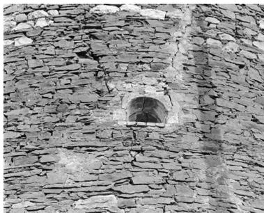
Bouche d'aération sud-ouest du four du Lapin destinée à activer la combustion au niveau du "ventre" du four, détail du parement en moellons schisto-gréseux, Montjean-sur-Loire.
