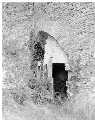
Ouverture de l'ébraisoir nord-ouest du four du Lapin, voûte en canonnière primitive en moellon et voûte segmentaire en tuffeau rapportée, Le Petit Lapin, Montjean-sur-Loire. Phot. Bruno Rousseau IVR52_19854901735X
