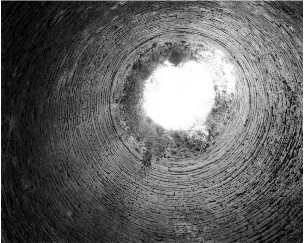
Chambre de combustion du four de l'Alouette, vue verticale du bas vers le haut, Le Petit Lapin, Montjean-sur-Loire.
