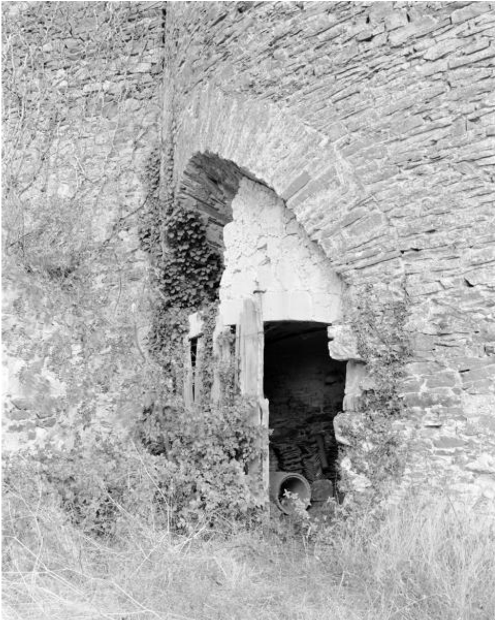
Ouverture de l'ébrasoir nord-ouest du four du Lapin, voûte en canonnière primitive en moellon et voûte segmentaire en tuffeau rapportée, Le Petit Lapin, Montjean-sur-Loire.
