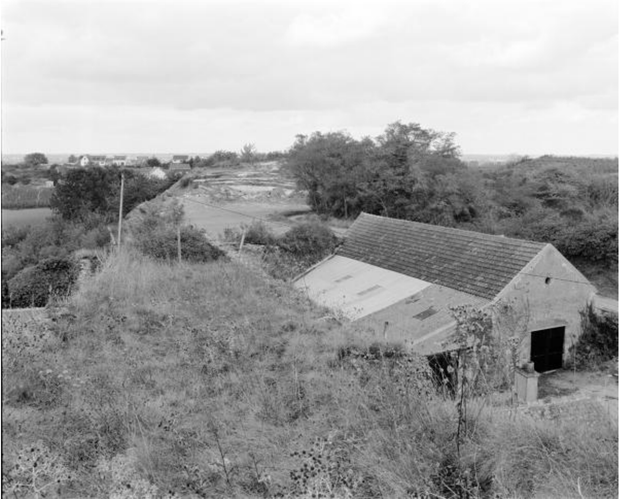
Au premier plan, rampe postérieure et entrepôts (parcelles 4 et 5) du four de l'Alouette, au second plan, monticules de cendres et de chaux incuite, vue du sud vers le nord, Le Petit Lapin, Montjean-sur-Loire.
