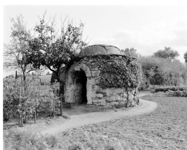
La poudrière vue depuis le nord-ouest, Le Petit Lapin, Montjean-sur-Loire. Phot. Bruno Rousseau IVR52_19854901743X
