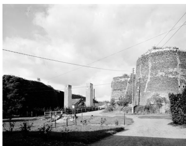
Vue d'ensemble du site "Le Petit Lapin" depuis le sud-est, à gauche, le four de l'Alouette, à droite, le four du Lapin. Au centre, les deux piles qui soutenaient la passerelle reliant les deux fours, Montjean-sur-Loire. Phot. Bruno Rousseau IVR52_19854901764V
