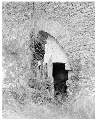
Ouverture de l'ébraisoir nord-ouest du four du Lapin, voûte en canonnière primitive en moellon et voûte segmentaire en tuffeau rapportée, Le Petit Lapin, Montjean-sur-Loire.
