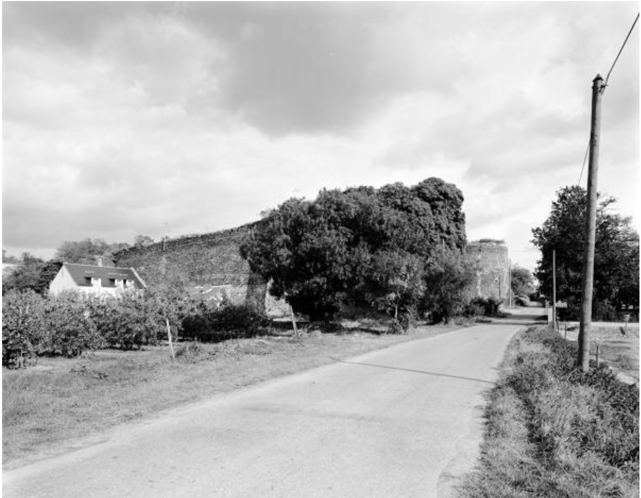
Vue d'ensemble du site depuis l'ouest, au premier plan le four de l'Alouette, au second plan, le four du lapin, Le Petit Lapin, Montjean-sur-Loire.
