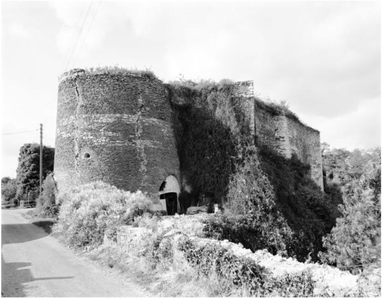
Le four du Lapin et sa plateforme postérieure vue depuis l'est, Le Petit Lapin, Montjean-sur-Loire.
