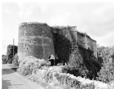
Le four du Lapin et sa plateforme postérieure vue depuis l'est, Le Petit Lapin, Montjean-sur-Loire. Phot. Bruno Rousseau IVR52_19854901765V
