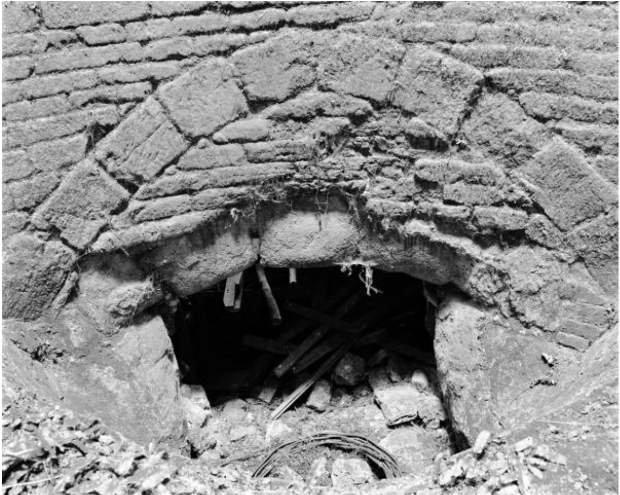
Intérieur de la chambre de combustion du four de l'Alouette, cuvette est de la sole et porte de déchargement, Le Petit Lapin, Montjean-sur-Loire.
