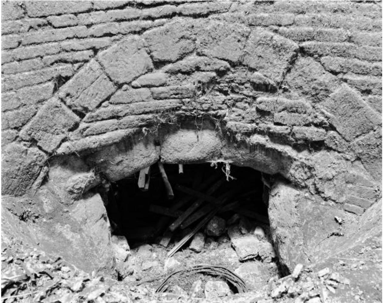
Intérieur de la chambre de combustion du four de l'Alouette, cuvette est de la sole et porte de déchargement, Le Petit Lapin, Montjean-sur-Loire.
