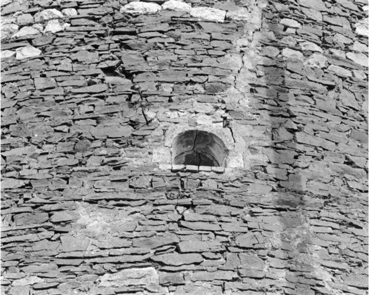
Bouche d'aération sud-ouest du four du Lapin destinée à activer la combustion au niveau du "ventre" du four, détail du parement en moellons schisto-gréseux, Montjean-sur-Loire.
