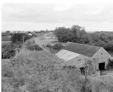
Au premier plan, rampe postérieure et entrepôts (parcelles 4 et 5) du four de l'Alouette, au second plan, monticules de cendres et de chaux incuite, vue du sud vers le nord, Le Petit Lapin, Montjean-sur-Loire. Phot. Bruno Rousseau IVR52_19854901739X
