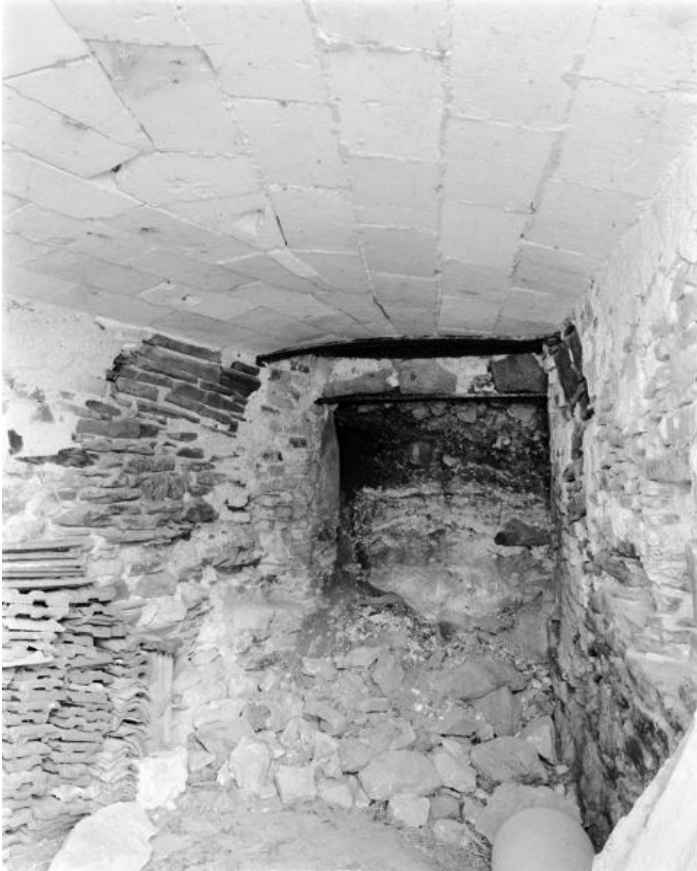
Intérieur de l'ébraisoir nord-ouest du four du Lapin, voûte segmentaire en tuffeau rapportée, et porte de déchargement, Le Petit Lapin, Montjean-sur-Loire.
