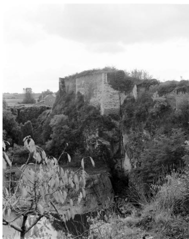
Vue depuis le nord-est, au premier plan, la carrière, au second plan, le four du Lapin avec sa plateforme postérieure, sa rampe et des vestiges de l'élévateur, Le Petit Lapin, Montjean-sur-Loire. Phot. Bruno Rousseau IVR52_19854901737X
