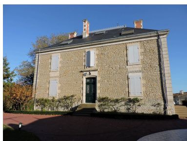
La façade ouest de la demeure. Phot. Yannis Suire IVR52_20218500671NUCA
