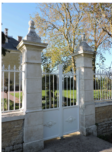
La porte piétonne et ses piliers maçonnés. Phot. Yannis Suire IVR52_20218500669NUCA
