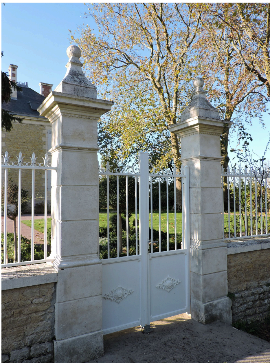
La porte piétonne et ses piliers maçonnés.
