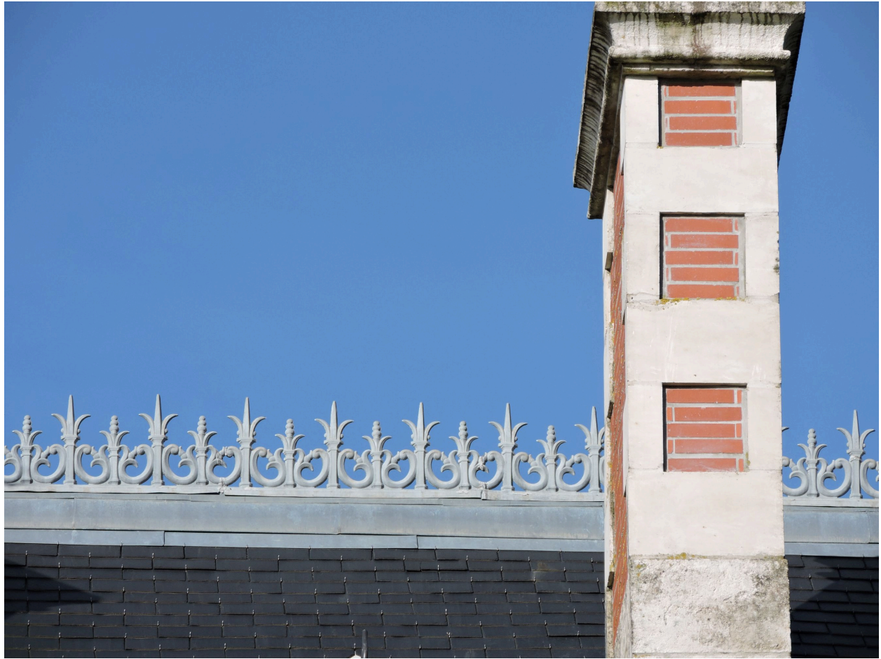
Souche de cheminée et crête de faîtage.
