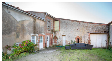
Chai, vue générale. Phot. Pierre-Bernard Fourny IVR52_20224400410NUCA
