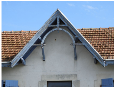
La ferme de charpente apparente sur la partie de façade en pignon. Phot. Yannis Suire IVR52_20188501271NUCA
