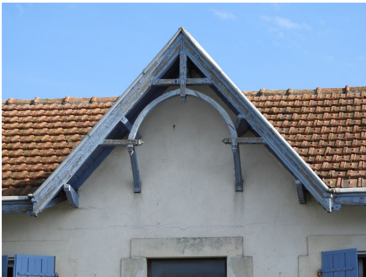
La ferme de charpente apparente sur la partie de façade en pignon.
