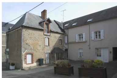
La façade sur cour (à gauche). Phot. François Lasa IVR52_20045303110NUCA
