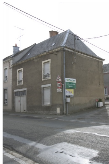
La façade sur rue. Phot. François Lasa IVR52_20045303109NUCA
