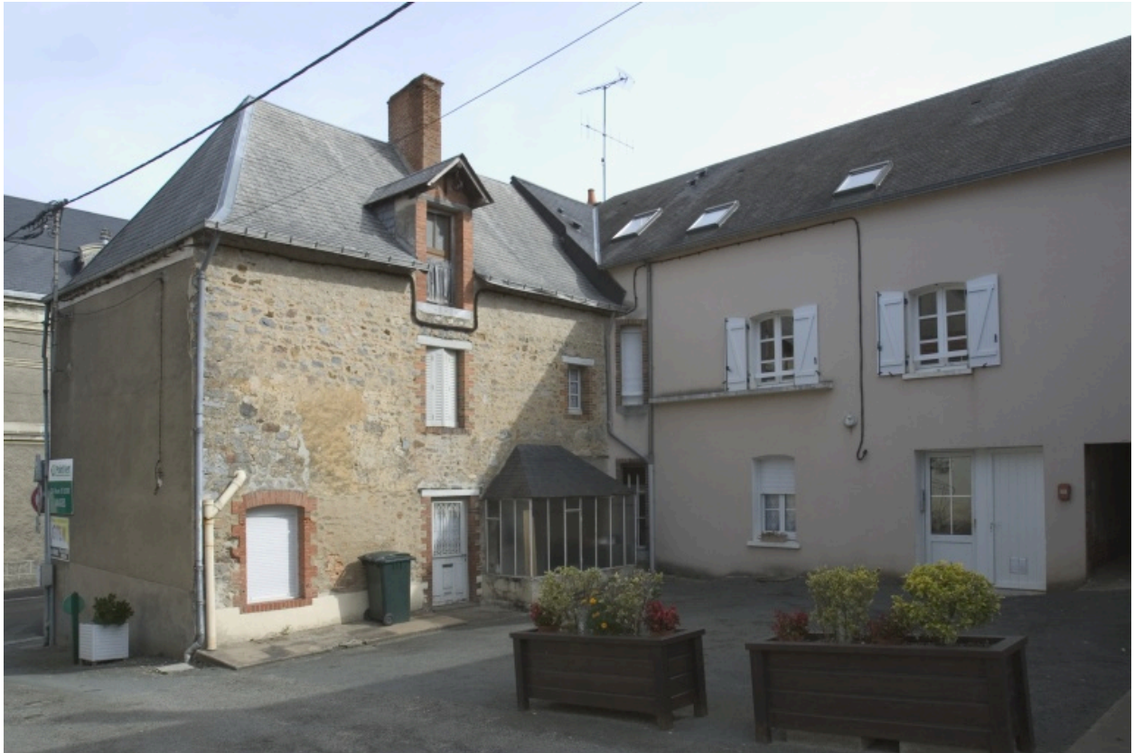
La façade sur cour (à gauche).
