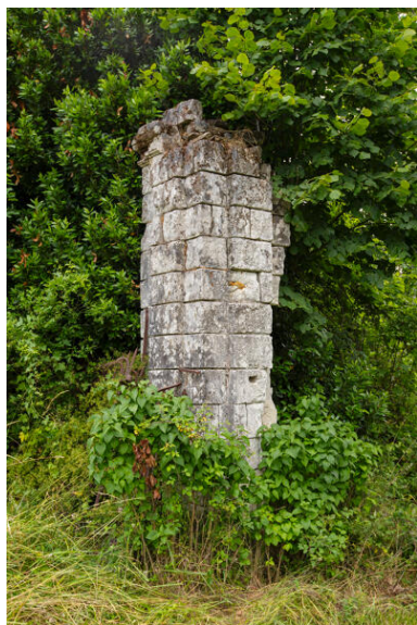
Un pilier de l'ancien portail. Phot. Pierre-Bernard Fourny IVR52_20235300946NUCA
