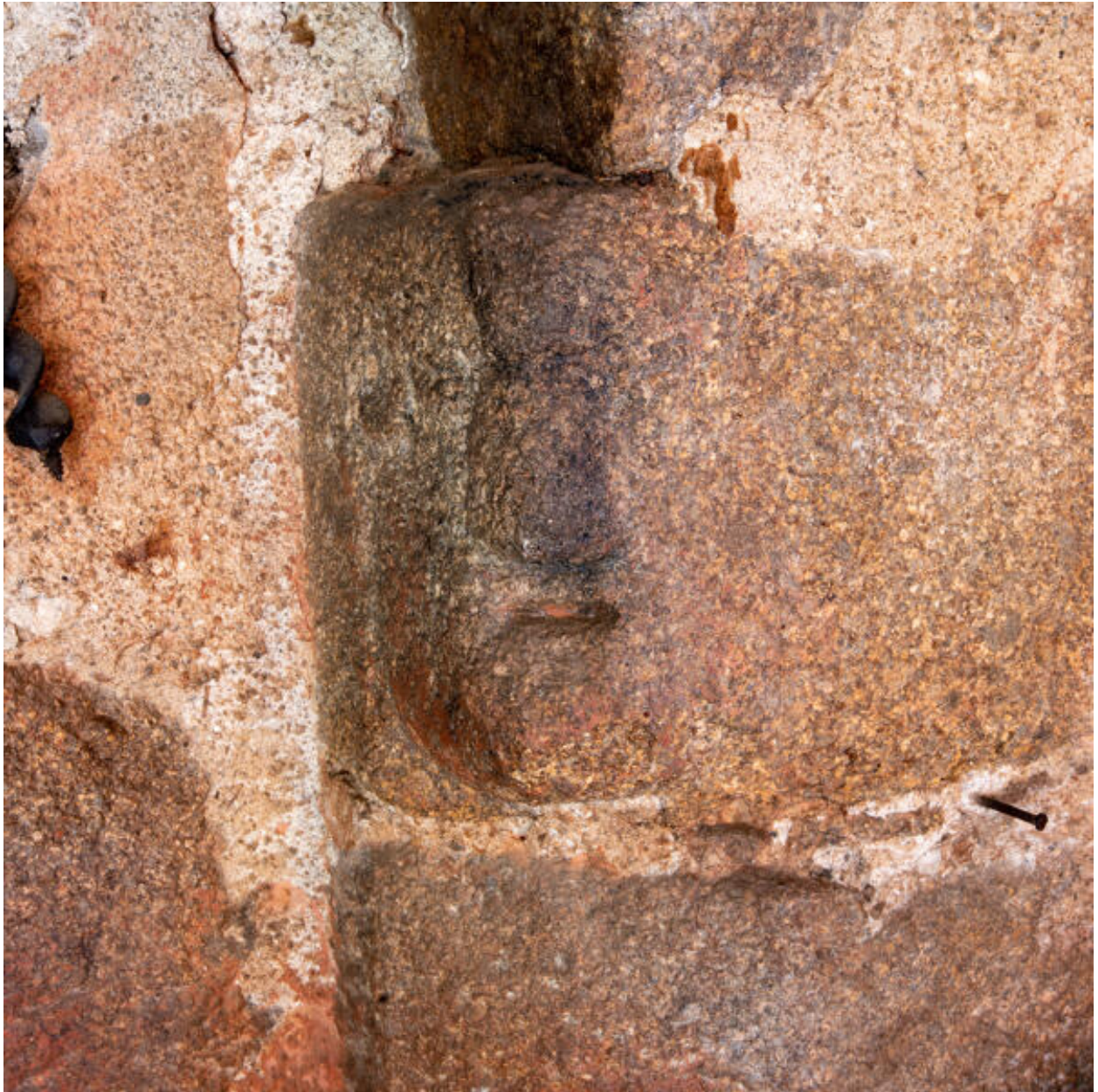
Maison, 3 impasse du Vieux-Lavoir (2023 166 B 1281), cheminée, congés orné d'un visage.
