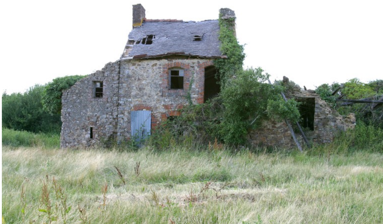
L'ancien logis vu du sud.
