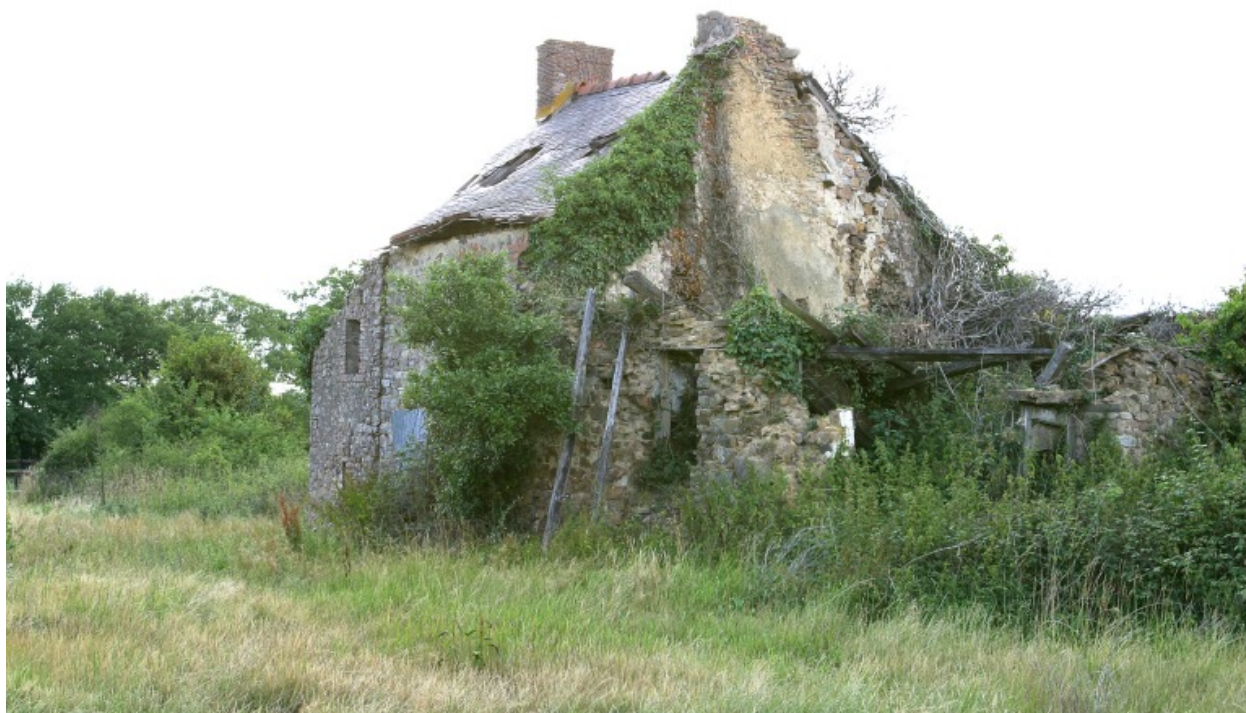
L'ancien logis vu du sud-est.
