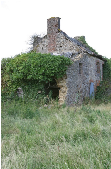
L'ancien logis vu depuis le sud-ouest. Phot. François Lasa IVR52_20035302258NUCA
