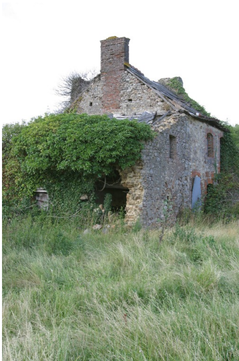
L'ancien logis vu depuis le sud-ouest.
