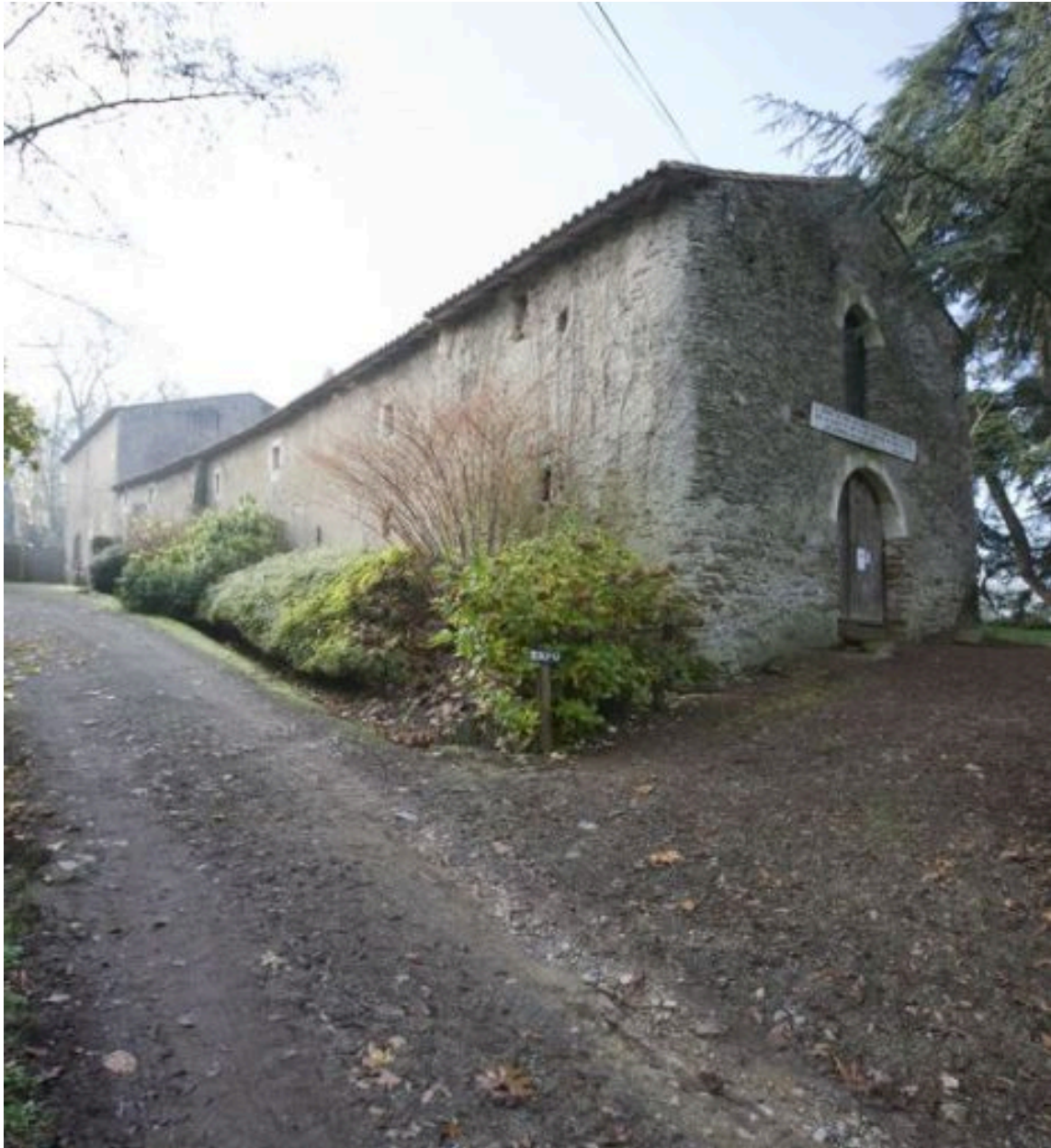
La cave : l'élévation est et l'extension 19e siècle.
