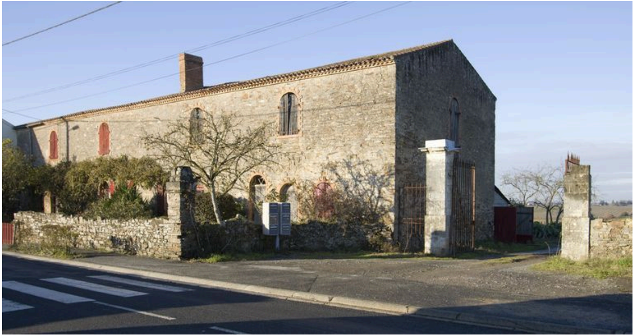
Portail d'entrée, rue Beauregard. A gauche, la borderie de la Barrière.
