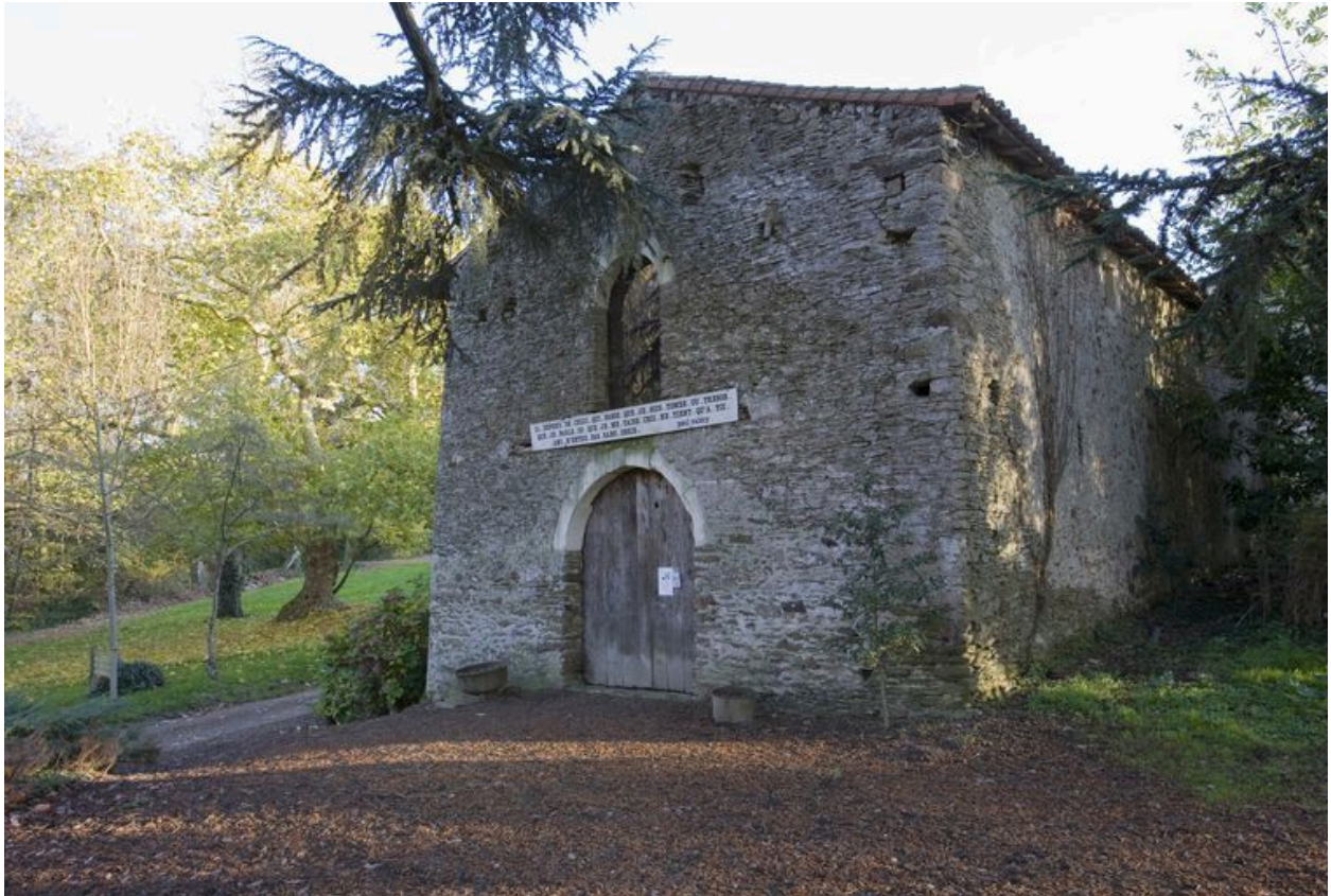
La cave : façade nord ouvrant vers la Sèvre.
