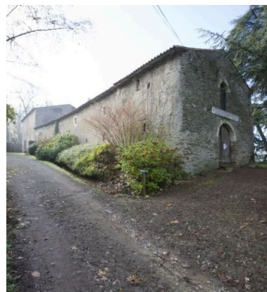
La cave : l'élévation est et l'extension 19e siècle. Phot. Yves Guillotin IVR52_20104403004NUCA
