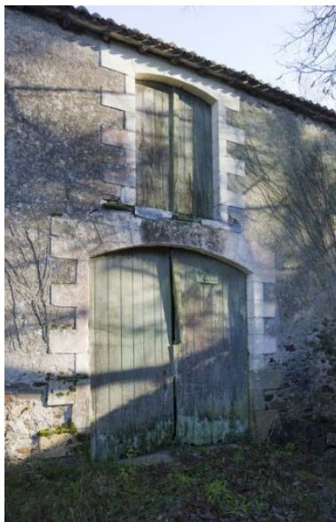
L'ancienne écurie : portail ouest ouvrant sur la cour des communs. Phot. Yves Guillotin IVR52_20104403057NUCA
