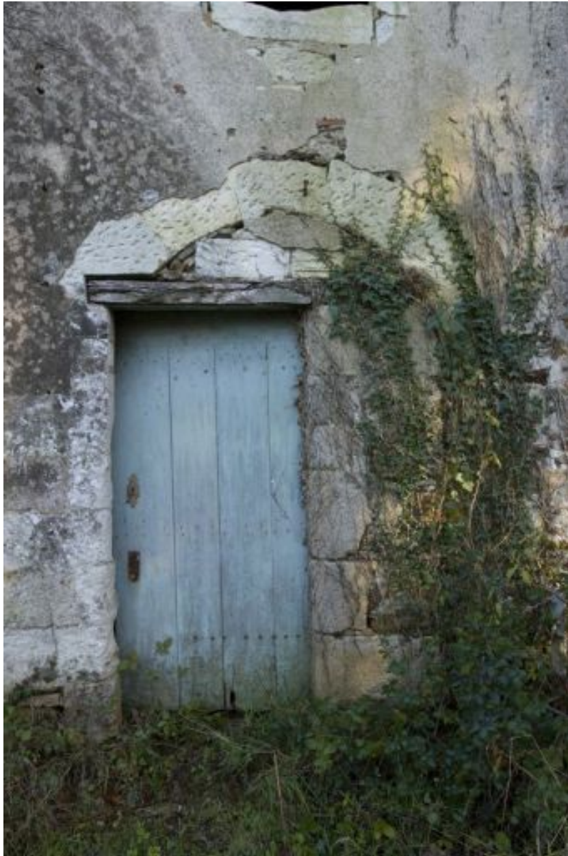
La cour des communs : la porte de l'étable remaniée à partir d'un portail à entourage de calcaire, 17e siècle.
