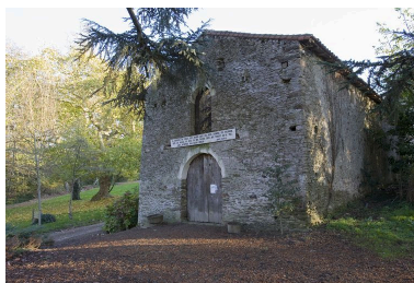
La cave : façade nord ouvrant vers la Sèvre. Phot. Yves Guillotin IVR52_20104403025NUCA
