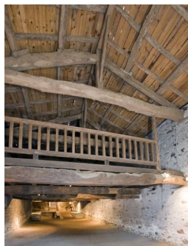
La cave : vue d'ensemble de la partie ancienne, autrefois magasin du port sur la Sèvre. Phot. Yves Guillotin
