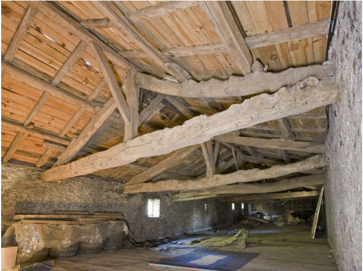
La cave : la charpente de la partie ancienne.
