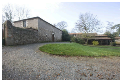
L'ancienne écurie, façade nord : le portail cintré date du remaniement de 1990. Phot. Yves Guillotin IVR52_20104403012NUCA
