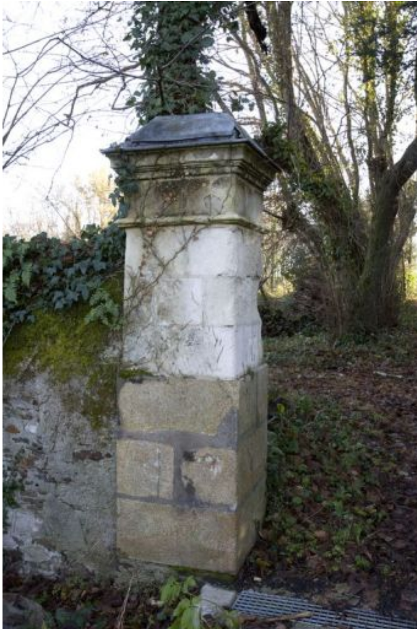
Entrée de la cour des communs : un pilier.
