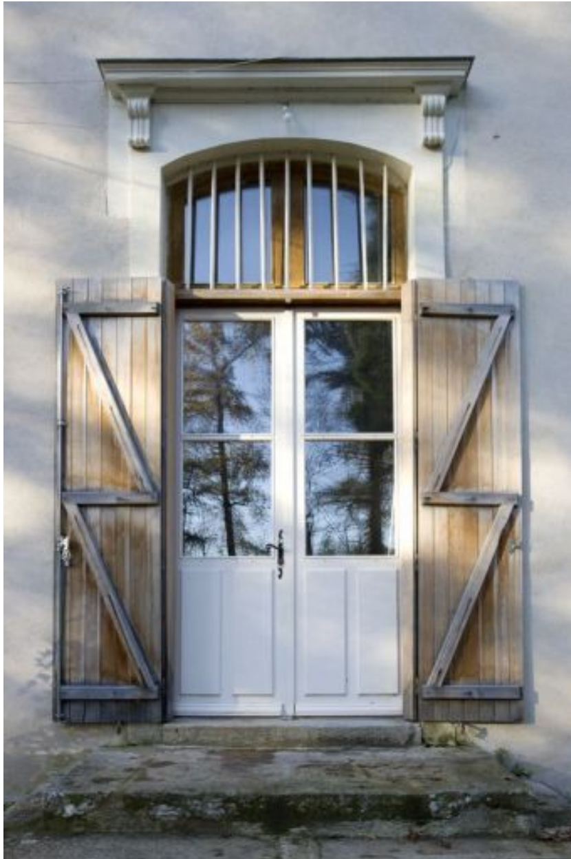
La demeure : façade sud, la porte d'entrée.
