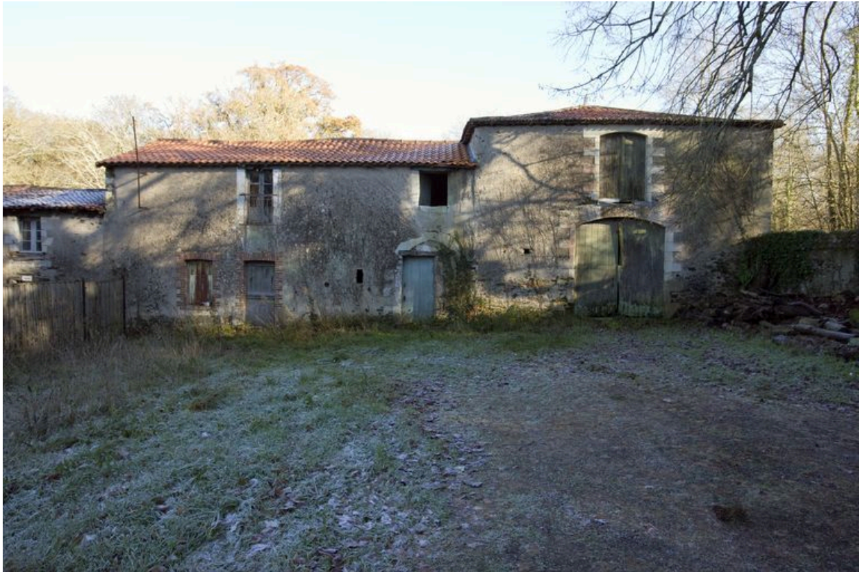
La cour des communs : le logement de fermiers aménagé en 1874, l'étable et le pignon ouest de l'ancienne écurie.
