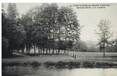
Le port de la Cantrie, vers 1920. Phot. Yves Guillotin IVR52_20104401559NUCAB
