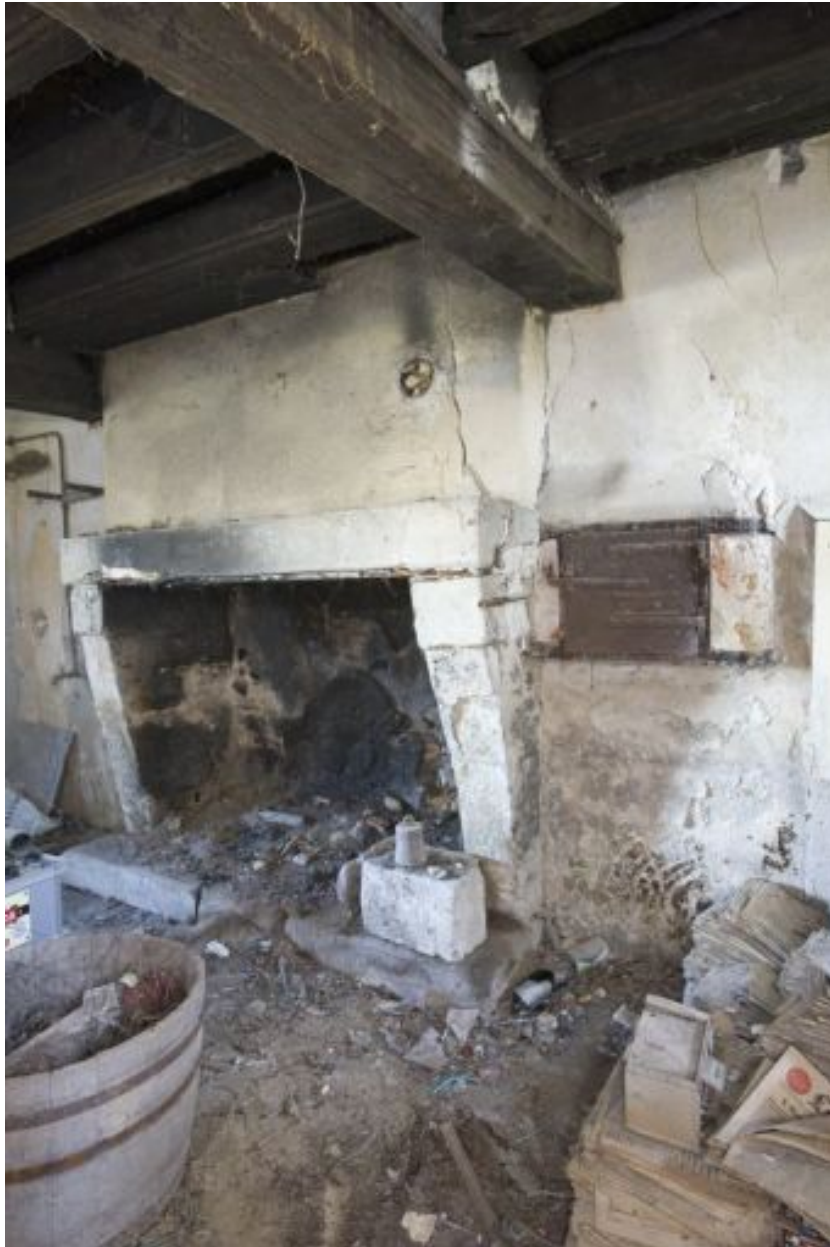
L'ancienne cuisine : la cheminée et le four.
