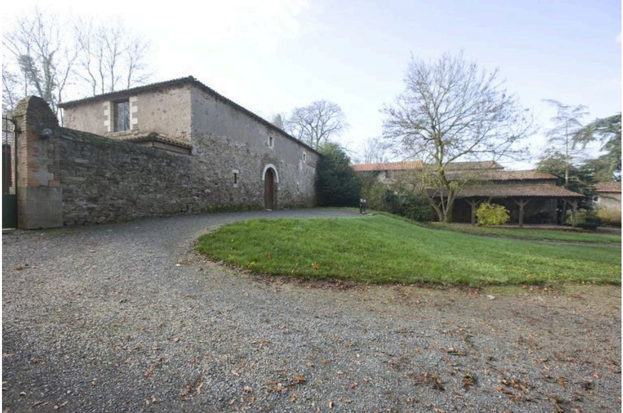
L'ancienne écurie, façade nord : le portail cintré date du remaniement de 1990.
