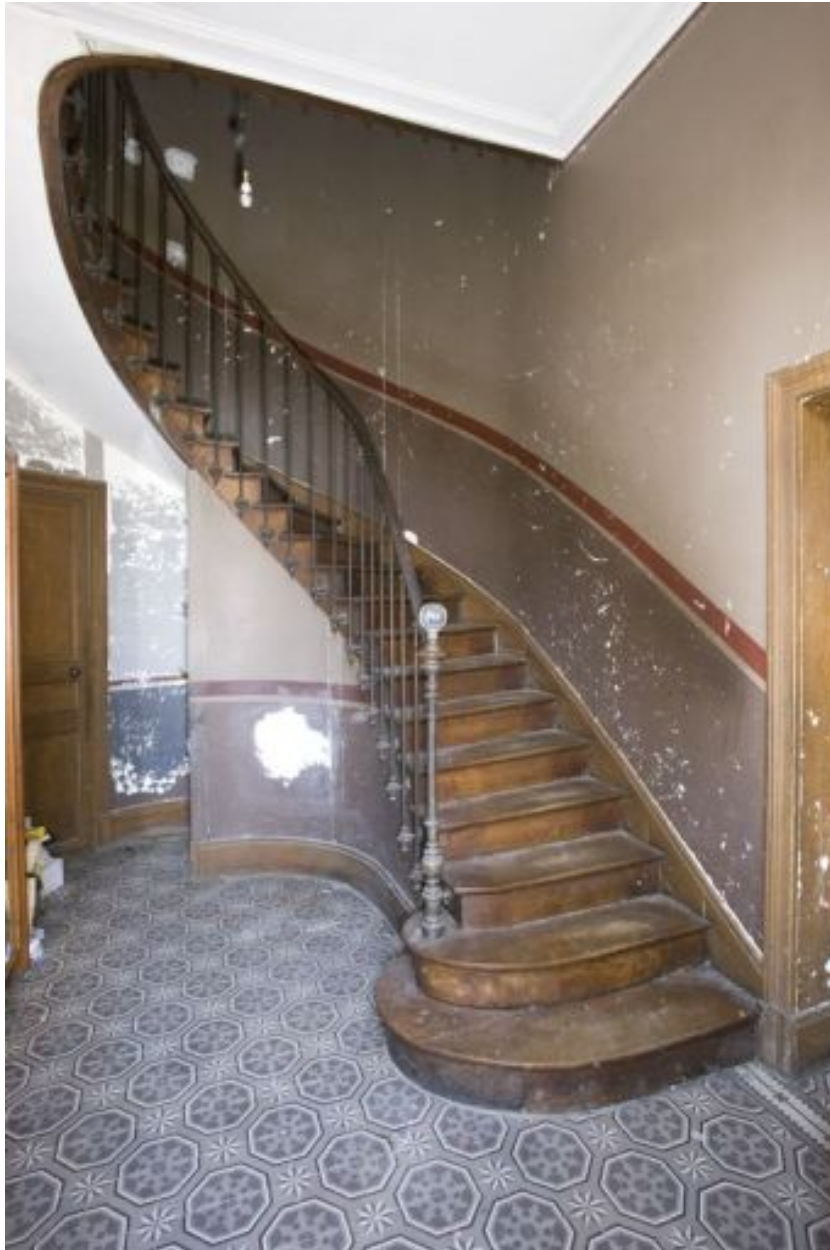
L'entrée : le départ d'escalier et le sol en carreaux de ciment.
