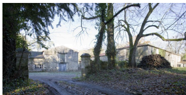
La cour des communs : au fond, la cave et à droite, l'ancienne écurie. Phot. Yves Guillotin IVR52_20104403055NUCA
