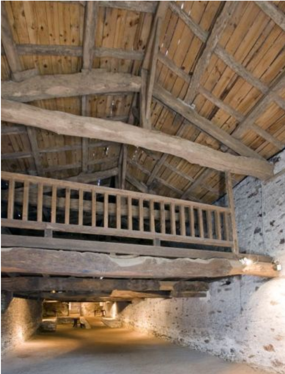
La cave : vue d'ensemble de la partie ancienne, autrefois magasin du port sur la Sèvre.
