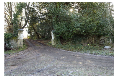
Entrée de la cour des communs. Phot. Yves Guillotin IVR52_20104403052NUCA
