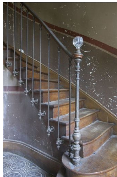
L'escalier : détail. Phot. Yves Guillotin IVR52_20104403065NUCA
