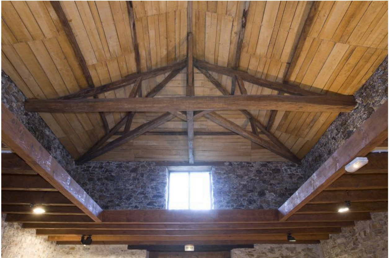
L'ancienne écurie : détail de la charpente.
