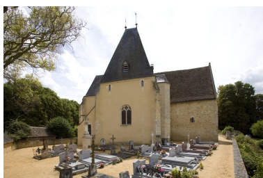
Vue générale. Phot. François Lasa IVR52_20087201365NUCA
