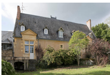
Façade arrière. Phot. Armelle Maugin IVR52_20204900478NUCA
