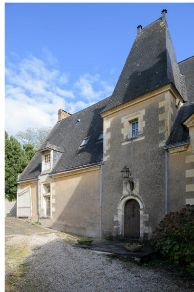
Détail de la travée centrale. Phot. Armelle Maugin IVR52_20204900476NUCA
