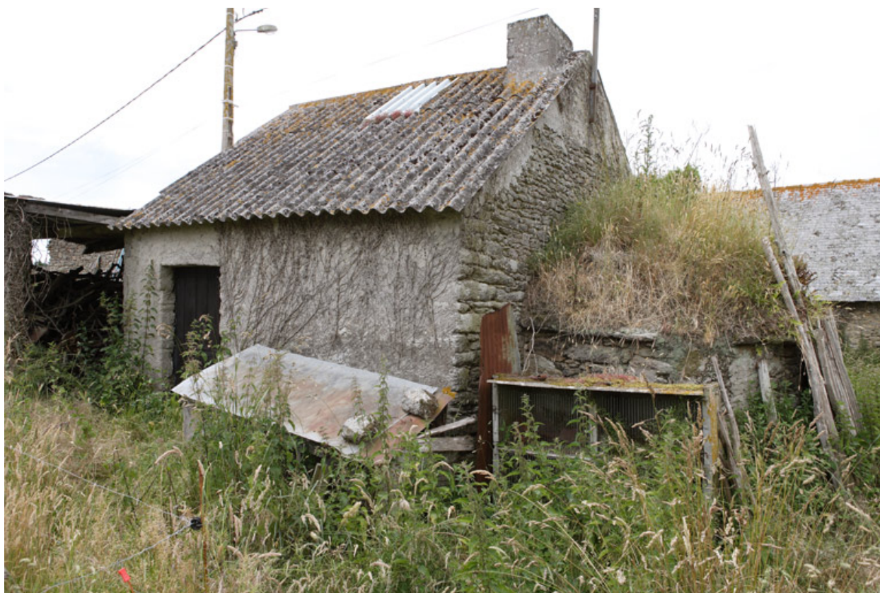
Fournil. Vue depuis le nord-est.
