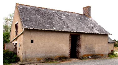
La petite maison : issue sur la cour ouverte au XIXe siècle. Phot. Jean-Baptiste Darrasse IVR52_20107201509NUCA
