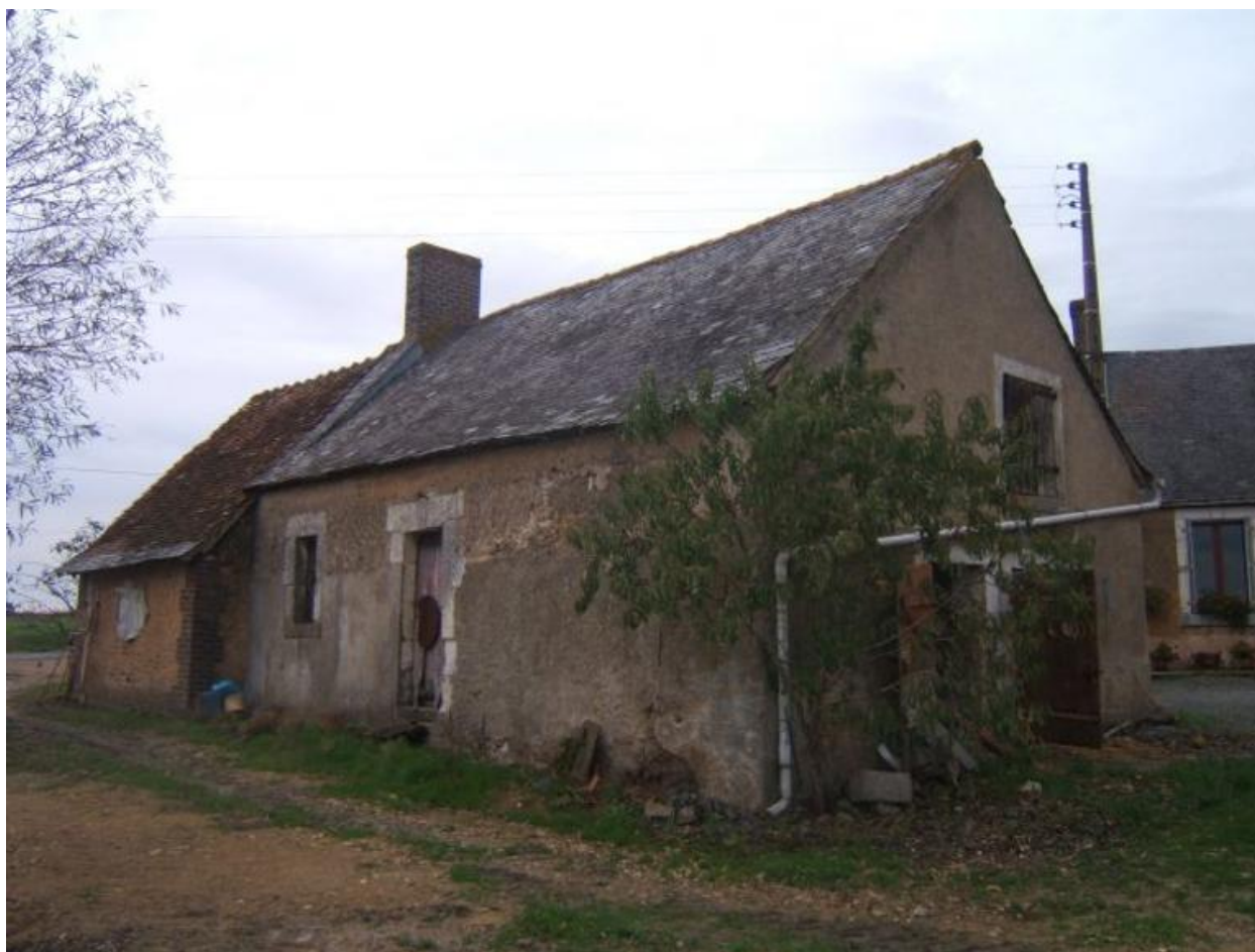
Vue de volume de la petite maison qui tourne le dos à la première.
