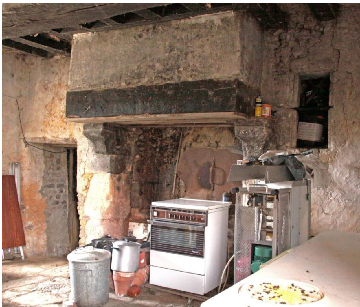
La petite maison : cheminée à hotte droite supportée par un linteau de bois sans piédroit. Noter la niche avec étagère dans le mur.
