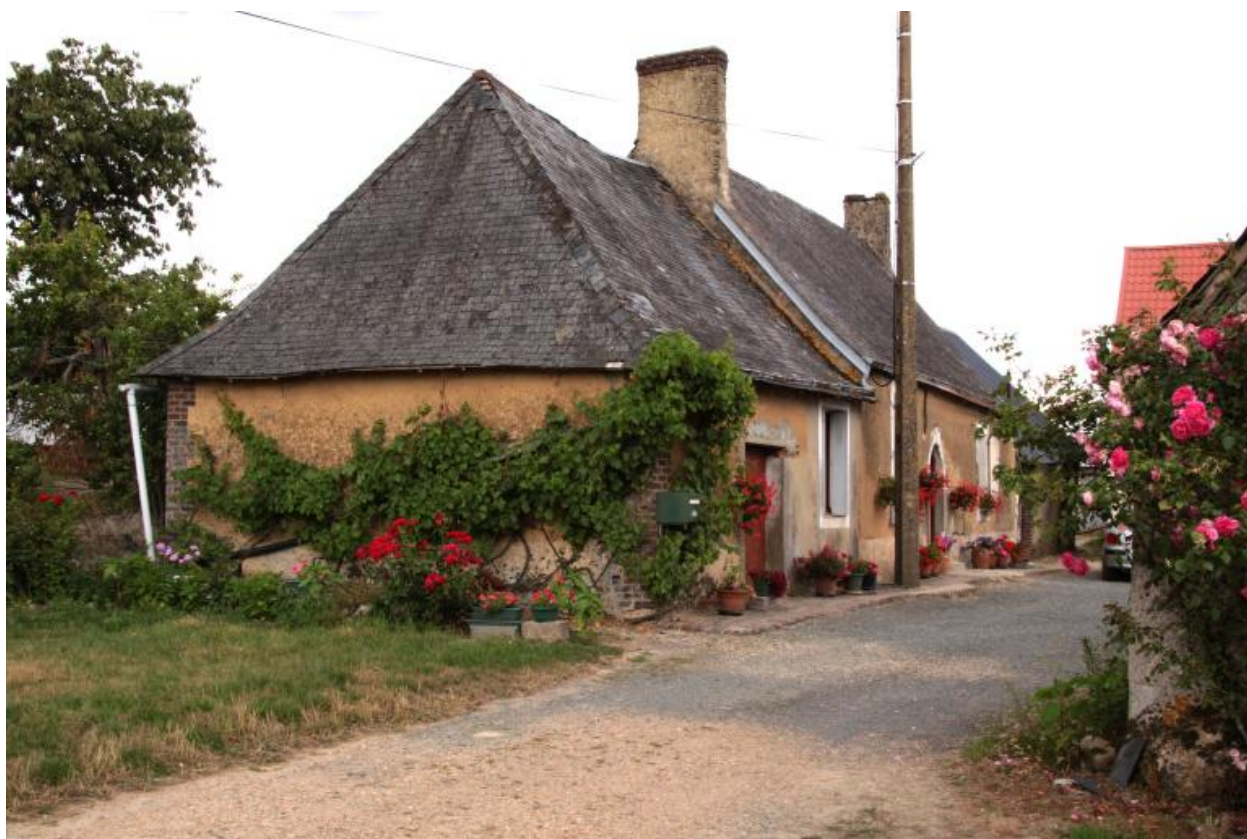
Vue de volume de la grande maison.
