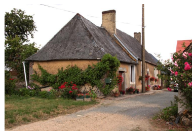
Vue de volume de la grande maison. Phot. Jean-Baptiste Darrasse IVR52_20107201505NUCA
