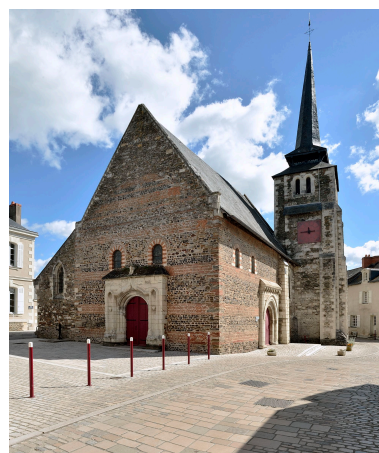
Vue de l'église paroissiale Saint-Pierre et Saint-Romain. Phot. Bruno Rousseau IVR52_20164900415NUCA
