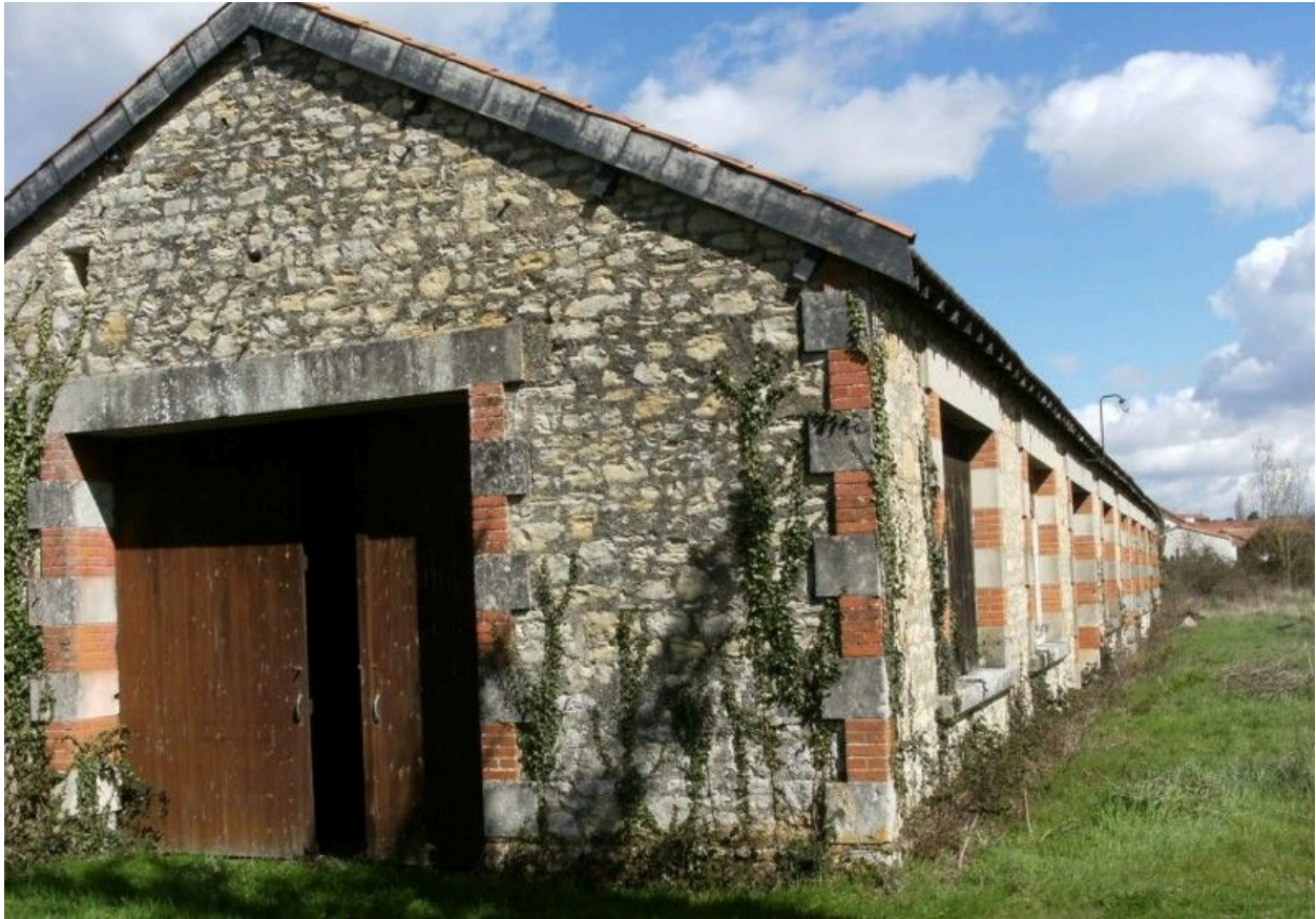
L'ancien atelier vu depuis le sud avant restauration, vers 2000.
