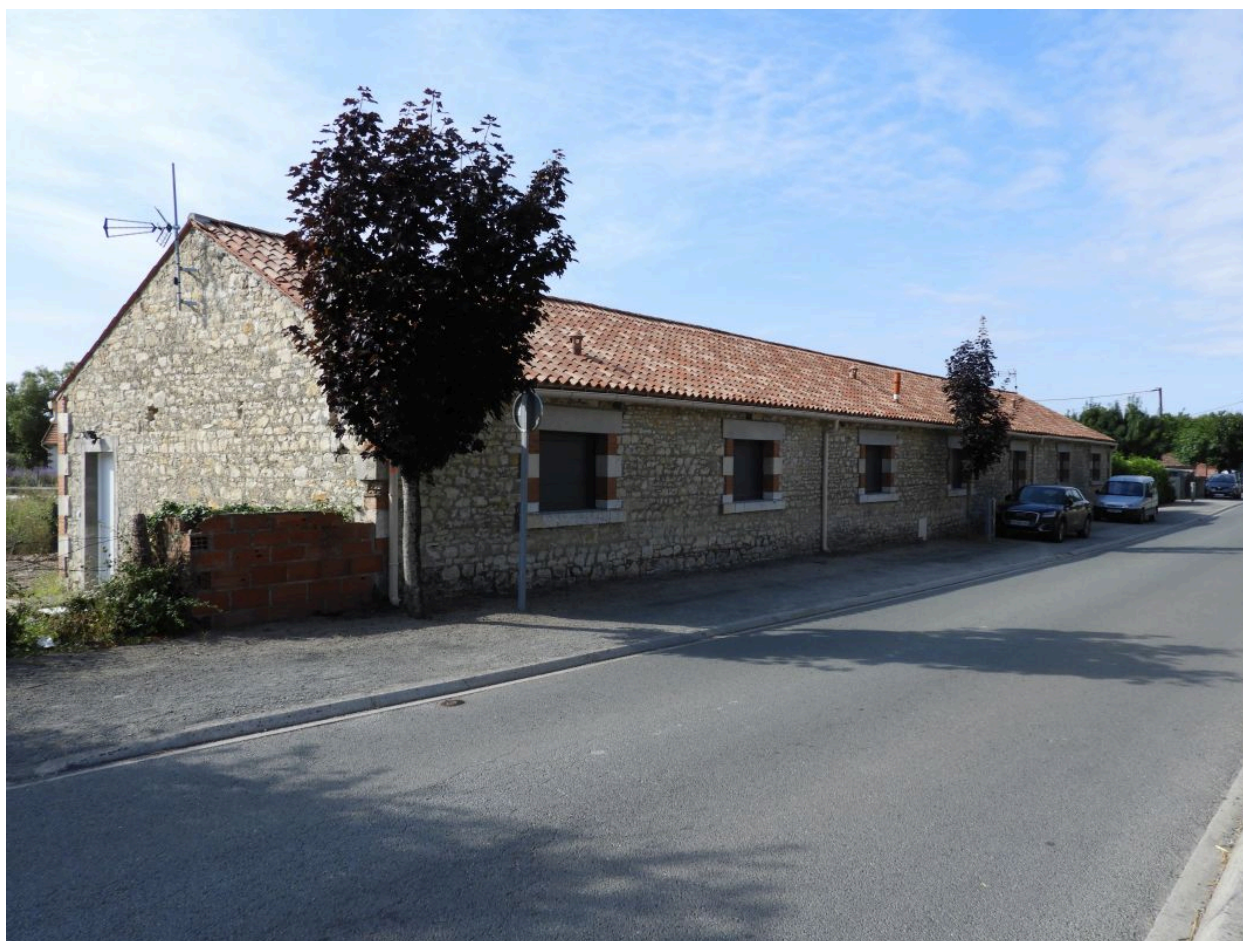
L'ancien atelier de vannerie, avenue de la Gare, vu depuis le nord.
