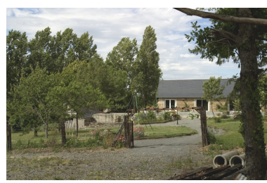
L'ancien logis-étable vu depuis le sud. Phot. François Lasa IVR52_20045302217NUCA
