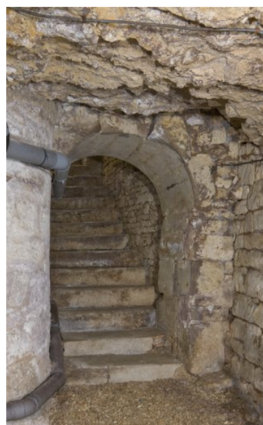
Vue prise du sous-sol, montrant l'escalier de descente. Phot. Patrice Giraud IVR52_20098500279NUCA
