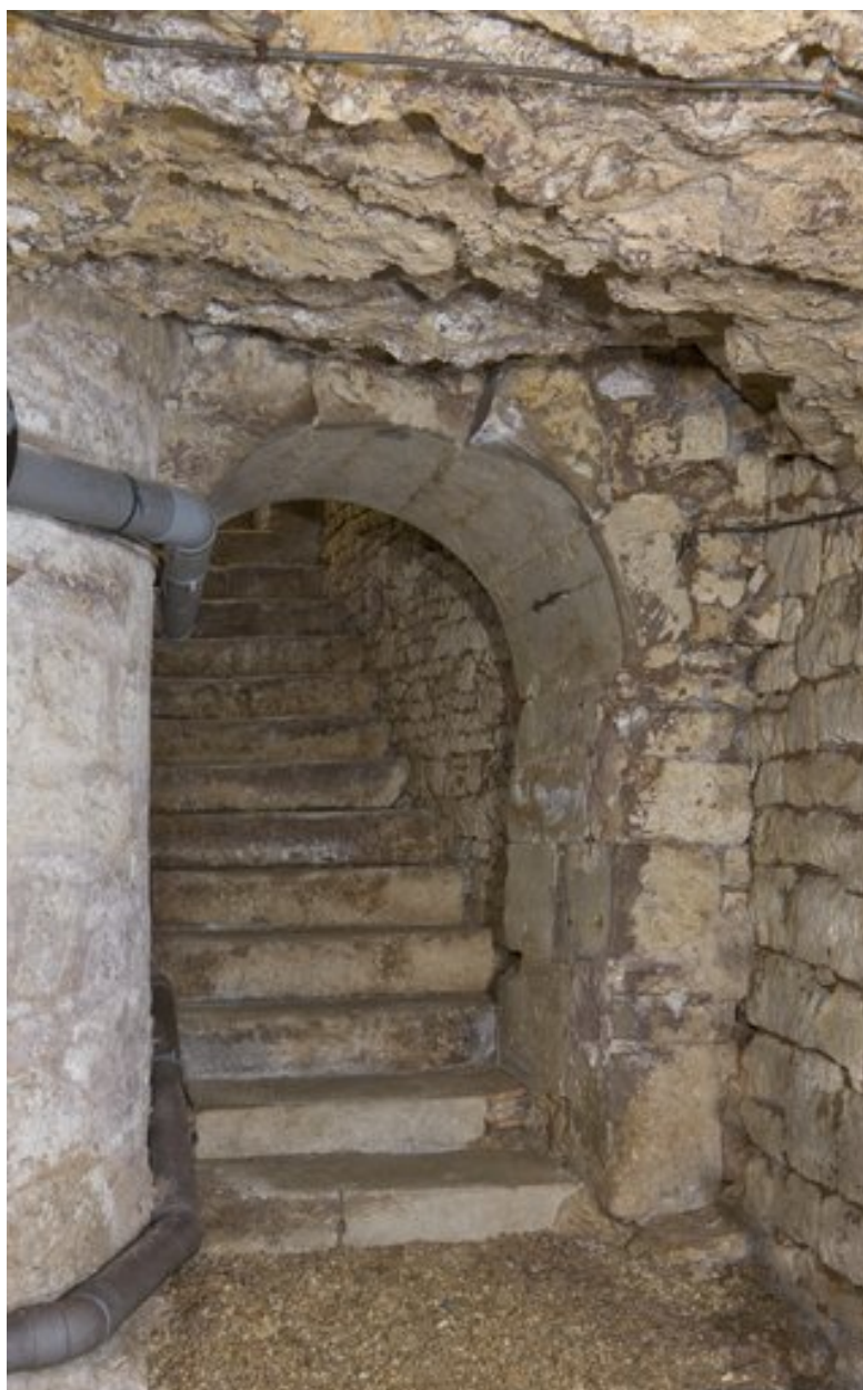
Vue prise du sous-sol, montrant l'escalier de descente.
