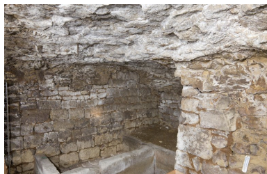
Vue du sous-sol. Phot. Patrice Giraud IVR52_20098500278NUCA
