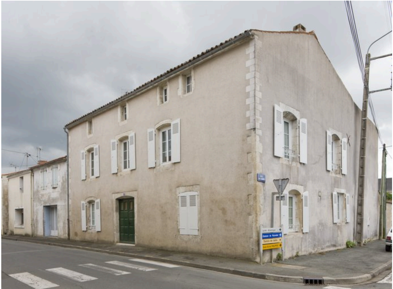
Vue de la maison, prise du nord-ouest.
