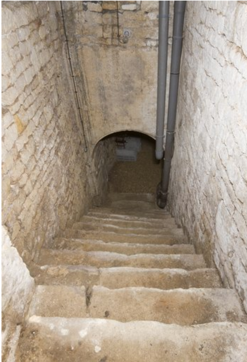
Vue prise du rez-de-chaussée du corps de bâtiment ouest, montrant la descente vers le sous-sol.
