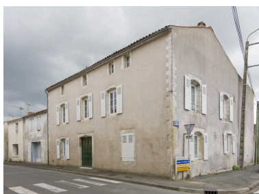
Vue de la maison, prise du nord-ouest. Phot. Patrice Giraud
