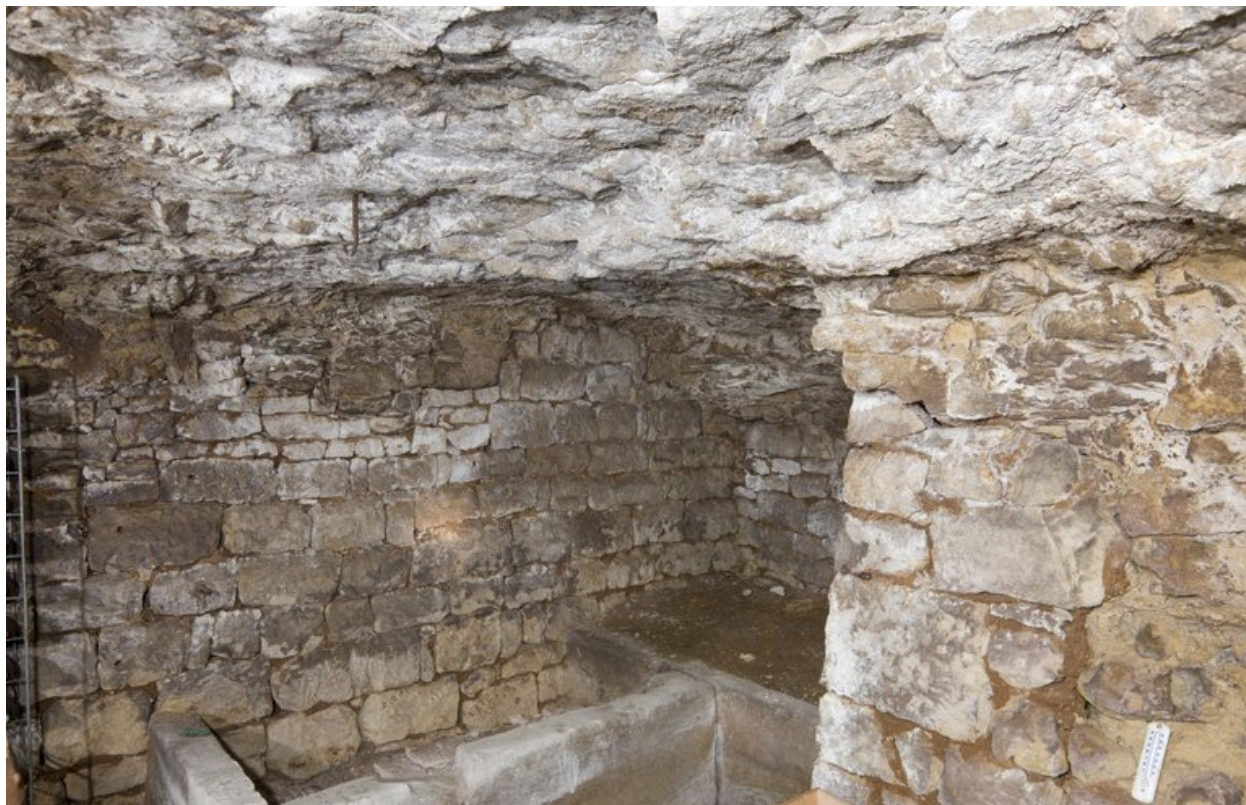
Vue du sous-sol.
