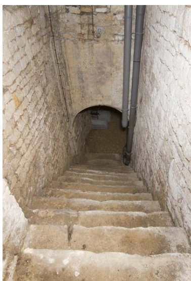
Vue prise du rez-de-chaussée du corps de bâtiment ouest, montrant la descente vers le sous-sol. Phot. Patrice Giraud IVR52_20098500280NUCA
