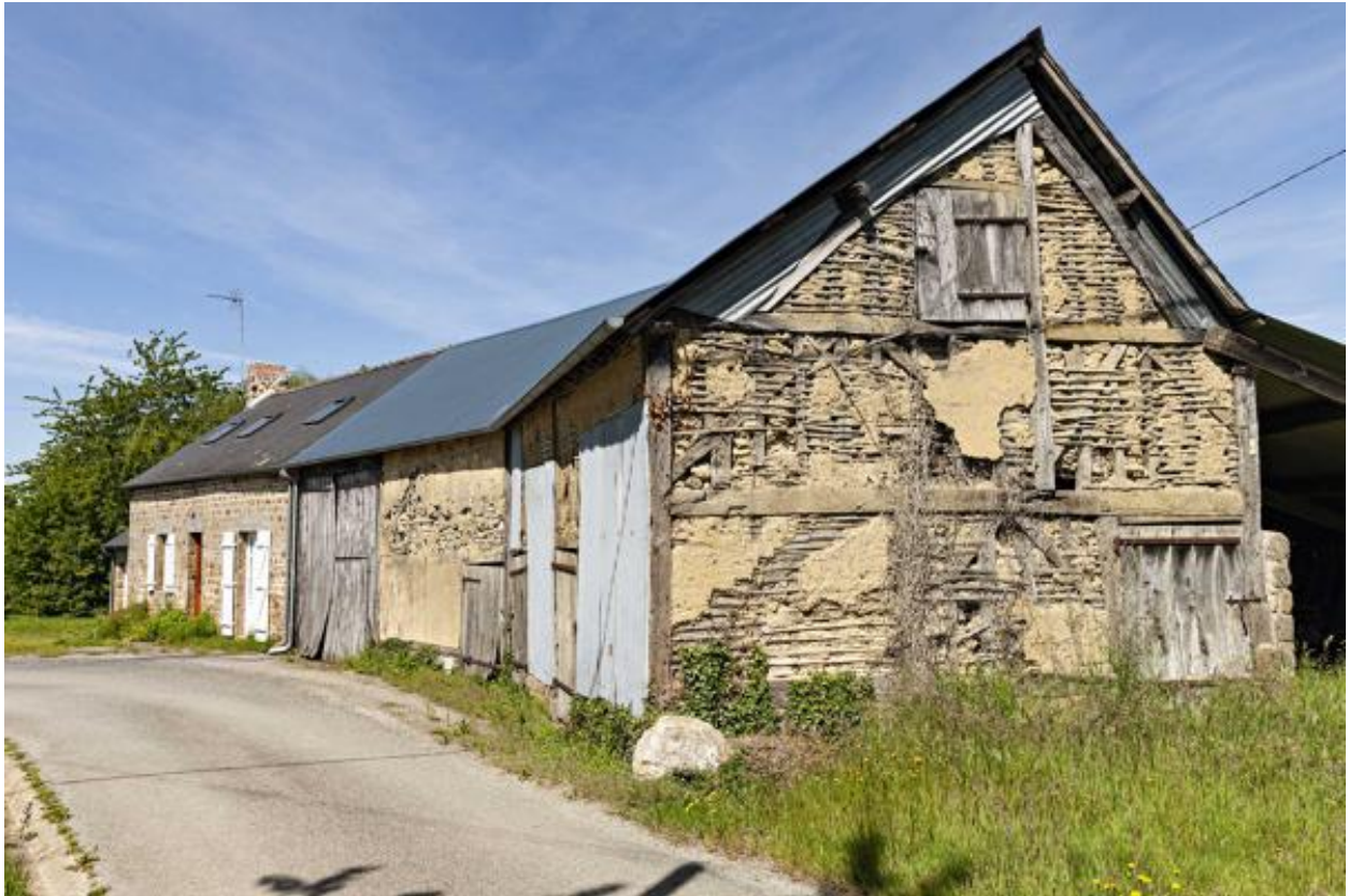
Alignement sud du hameau du Boulay, mur-pignon oriental.
