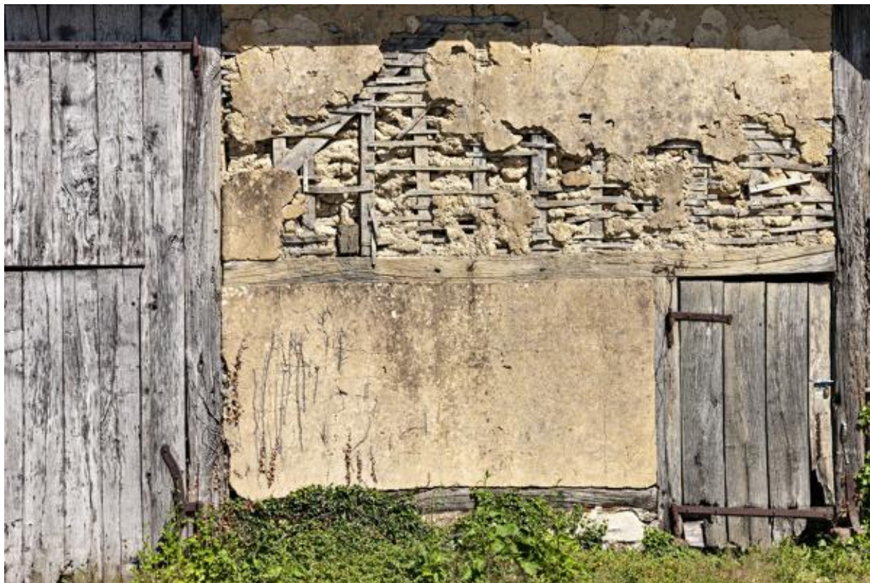
Alignement sud du hameau du Boulay, détail de la grange-étable centrale.
