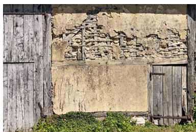
Alignement sud du hameau du Boulay, détail de la grange-étable centrale. Phot. Yves Guillotin IVR52_20215300675NUCA
