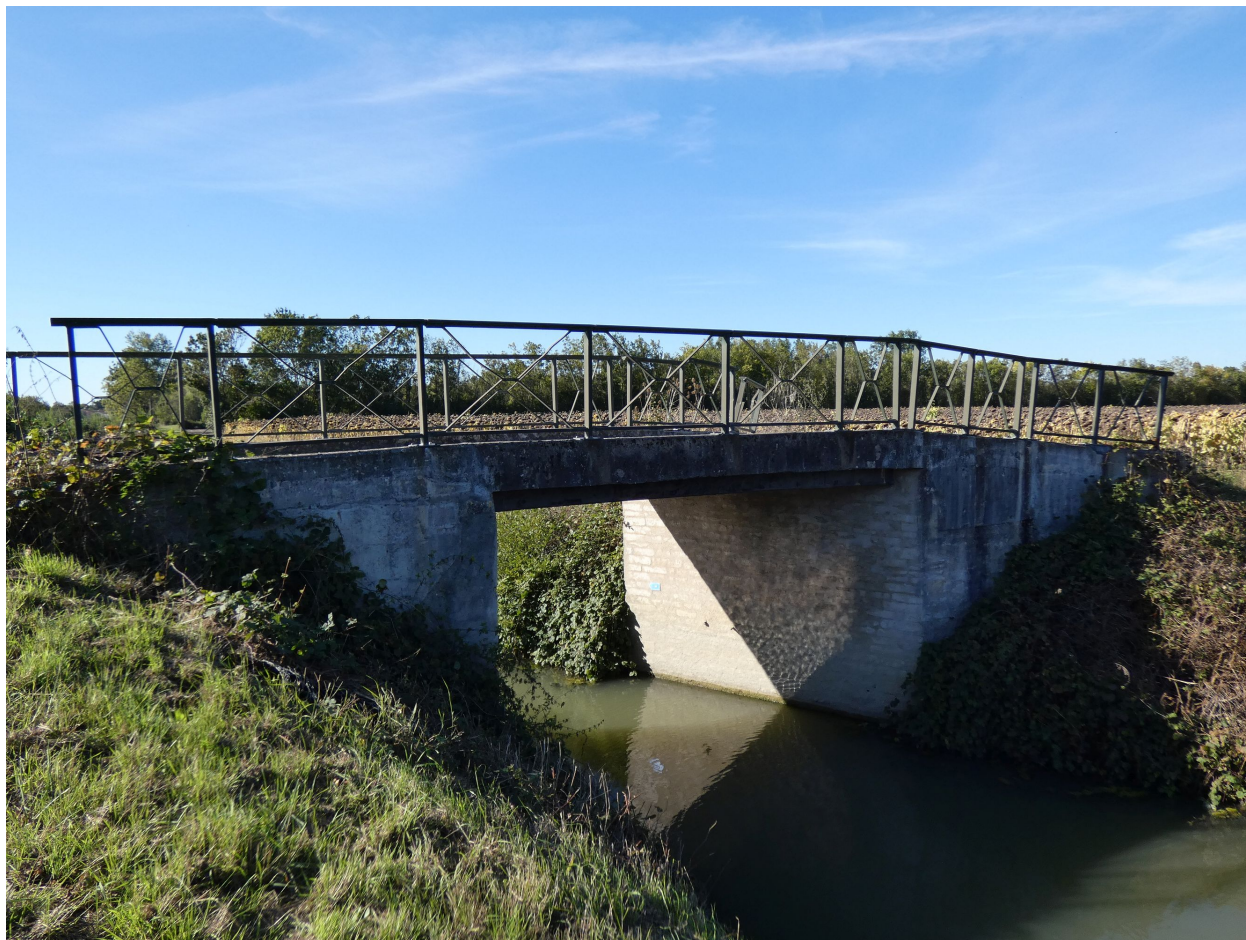
La passerelle de halage à la tête amont du canal.
