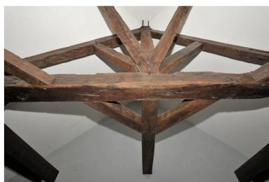
Charpente du boulodrome : détail d'éléments conservés de l'ancienne charpente des halles.
