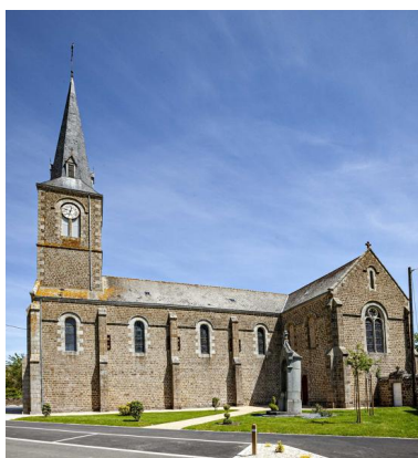
Flanc sud de l'église. Phot. Yves Guillotin IVR52_20215300685NUCA
