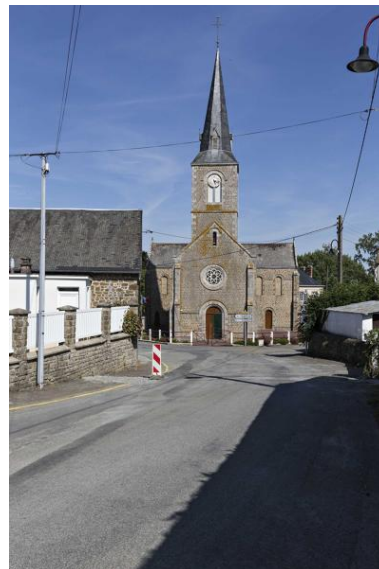
Façade occidentale de l'église de Sainte-Marie-du-Bois. Phot. Yves Guillotin IVR52_20195301140NUCA
