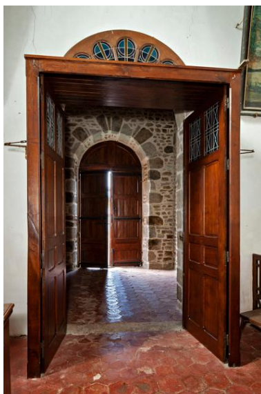
Vue de l'intérieur de la tour-clocher depuis la nef. Phot. Yves Guillotin IVR52_20195300534NUCA
