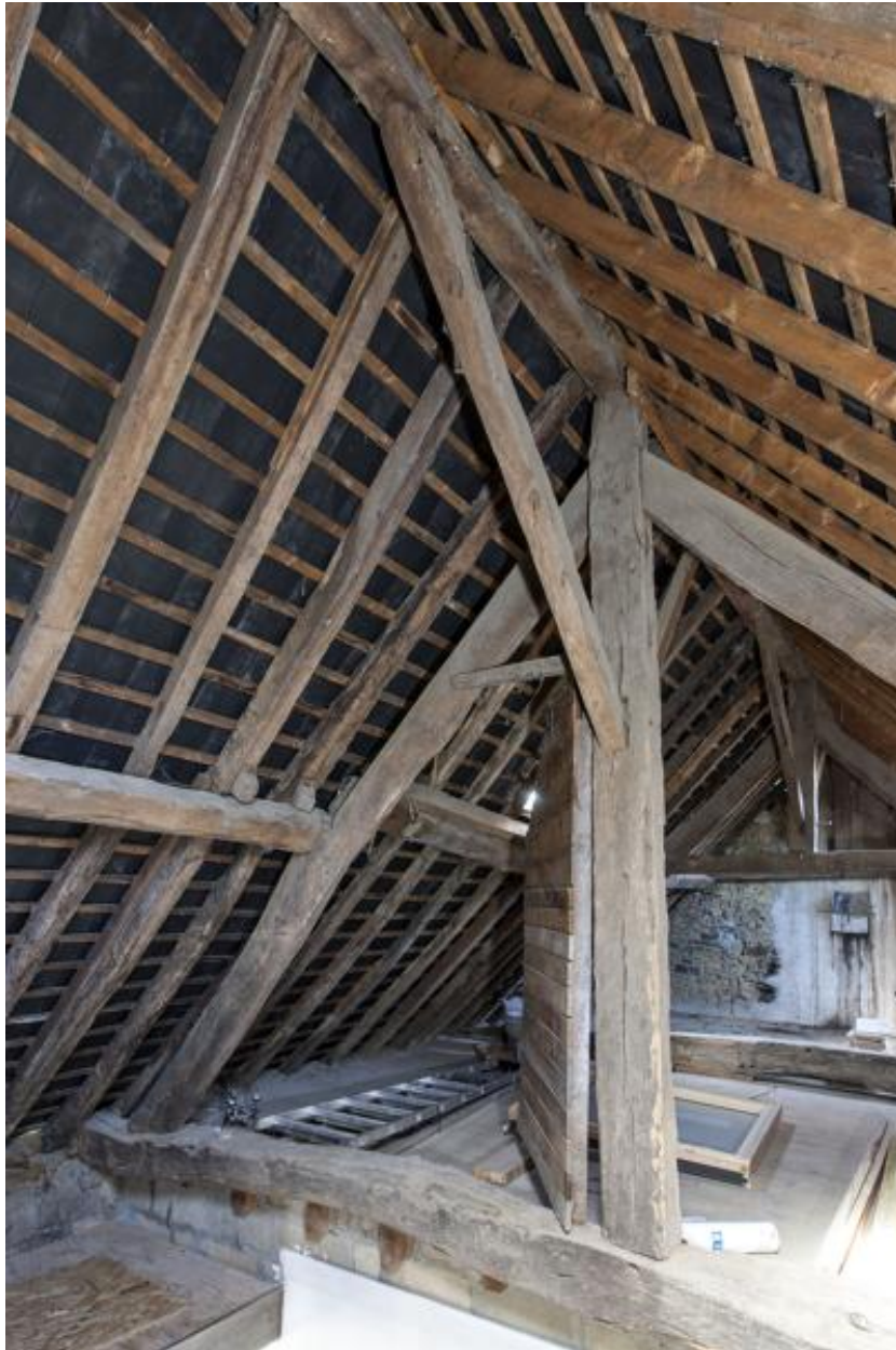
Ensemble 2, logis sud, charpente, ferme centrale.
