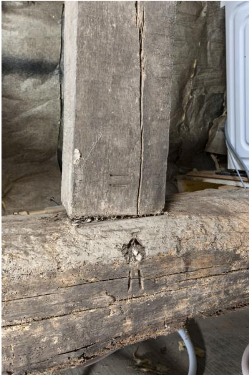
Ensemble 2, logis sud, charpente, ferme nord détail.
