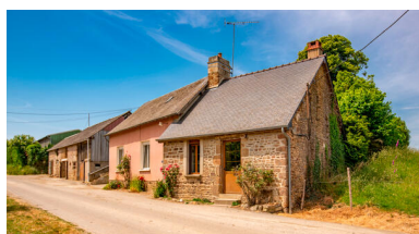
Rangée de maisons, ensemble 4. Phot. Pierre-Bernard Fourny IVR52_20235300839NUCA
