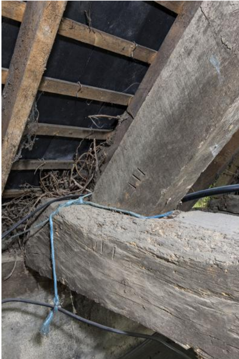
Ensemble 2, logis sud, charpente, ferme sud détail.
