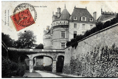
Le mur taluté de l'éperon bouche les anciens fossés est de la basse-cour. Phot. Jean-Baptiste (reproduction) Darrasse IVR52_20067207151NUCA
