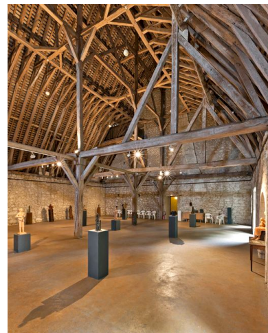
Les greniers à blé : les sous- faîtages sont consolidés par des croix-de-saint-André. Phot. Yves Guillotin IVR52_20127201315NUCA
