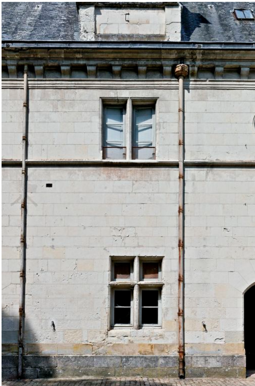
Les écuries et greniers à blé, face côté parc, travée de baies : détail.
