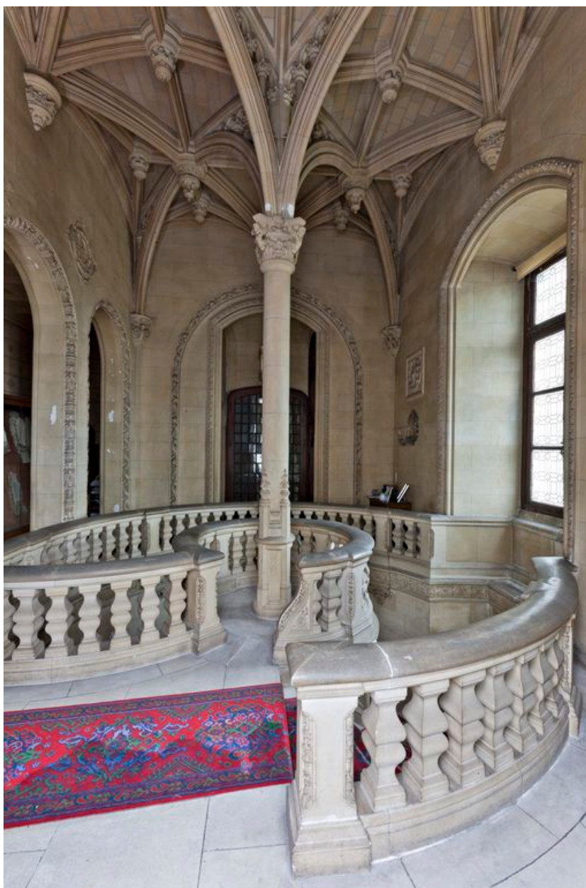
Aile sud, 1er étage, escalier monumental : circulation piétonne hélicoïdale.
