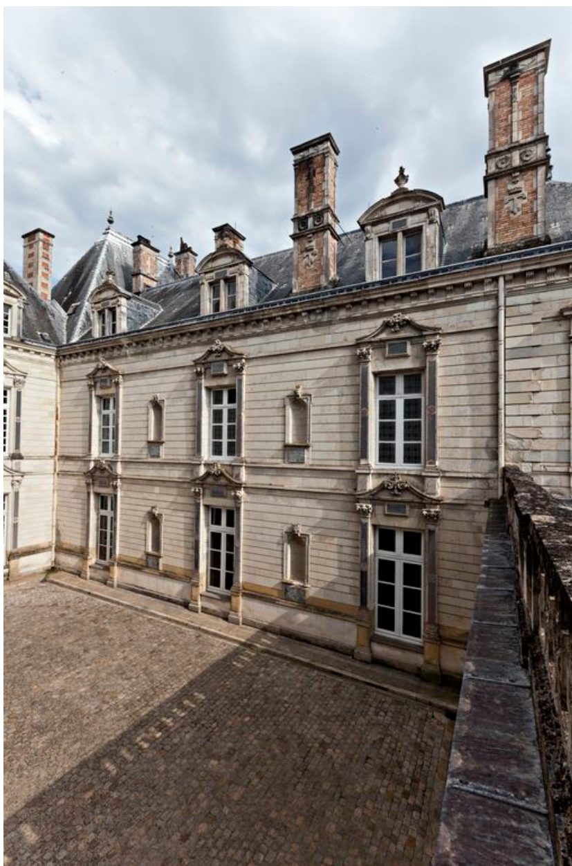
Façade de l'aile sud sur la cour.
