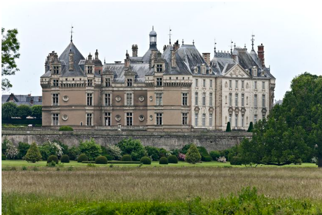
Le château : façades méridionale et orientale.
