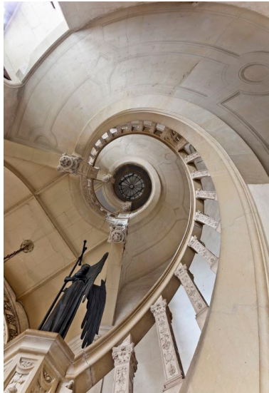
Tour nord-ouest : escalier en vis avec clés pendantes. Phot. Yves Guillotin IVR52_20137201005NUCA
