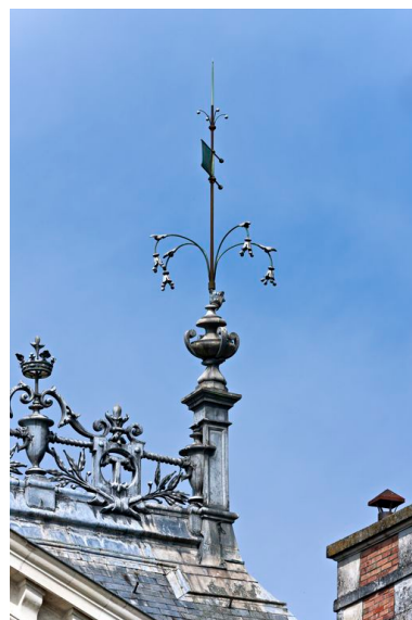
Aile est, corps de logis central : épis de faîtage de droite. Phot. Yves Guillotin IVR52_20137200907NUCA
