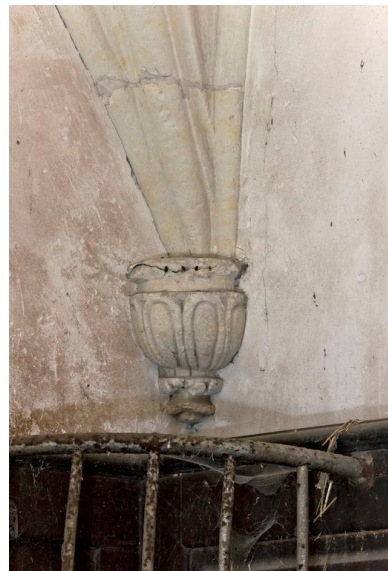
Les écuries voûtées d'ogives supportées par des culots semblables à ceux de l'escalier de la Maison de la Miséricorde. Phot. Yves Guillotin IVR52_20127201326NUCA
