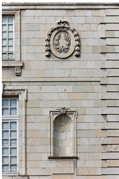
Aile est, l'avant-corps central est flanqué d'une travée de niches et médaillon superposés. Phot. Yves Guillotin IVR52_20137200904NUCA
