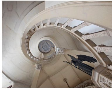
Tour nord-ouest : escalier en vis suspendu avec éclairage zénital. Phot. Yves Guillotin IVR52_20137201004NUCA
