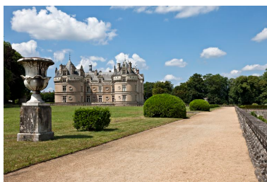
La face méridionale de la plateforme du château : tous les bâtiments de la basse cour ont disparu. Phot. Yves Guillotin IVR52_20137200970NUCA
