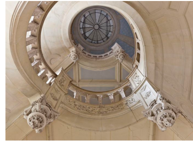
Tour nord-ouest, escalier en vis suspendu : détail du palier du 1er étage. Phot. Yves Guillotin IVR52_20137201006NUCA
