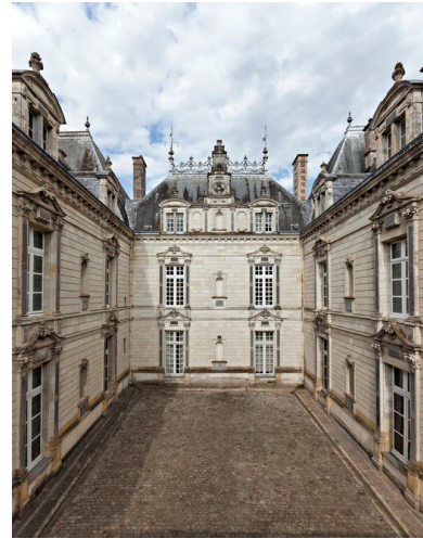
Aile du XVIII e siècle : façade sur cour. Phot. Yves Guillotin IVR52_20137200996NUCA
