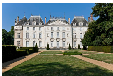
Façade de Vincent Barré (1787) : la division de la façade en trois parties couvertes de toit en pavillon (pour les ailes) et d'un toit à longs pans et croupes au centre, conserve en partie la disposition antérieure. Phot. Yves Guillotin IVR52_20137200877NUCA
