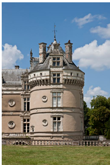
Aile sud, tour sud-est : travée de baies restaurées Phot. Yves Guillotin IVR52_20137200966NUCA
