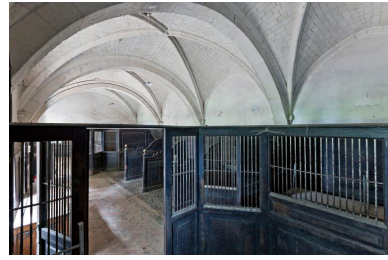
Les écuries sont couvertes d'un vaisseau longitudinal de quatre travées de voûtes d'ogives. Phot. Yves Guillotin IVR52_20127201324NUCA
