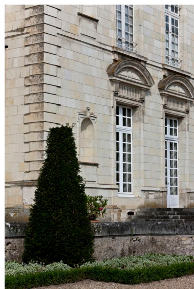
Aile est, détail : noter la mise en oeuvre des pierres de tailles. Phot. Yves Guillotin IVR52_20137200914NUCA
