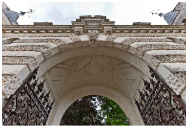
Le portail des Tourelles : voûte en berceau ornée de faux caissons. Phot. Yves Guillotin IVR52_20127201421NUCA
