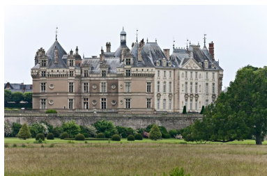
Façades du château sur le Loir. Phot. Yves Guillotin IVR52_20127201422NUCA
