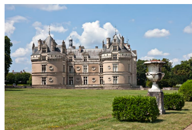
L'aile sud vue depuis la grande terrasse. Phot. Yves Guillotin IVR52_20137200969NUCA
