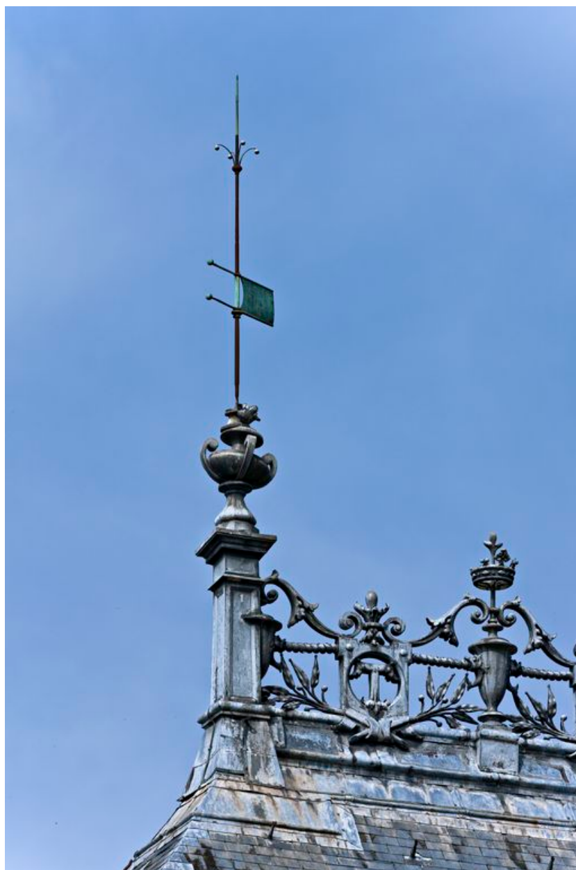
Aile est, détail : épi de faîtage en zing (S).
