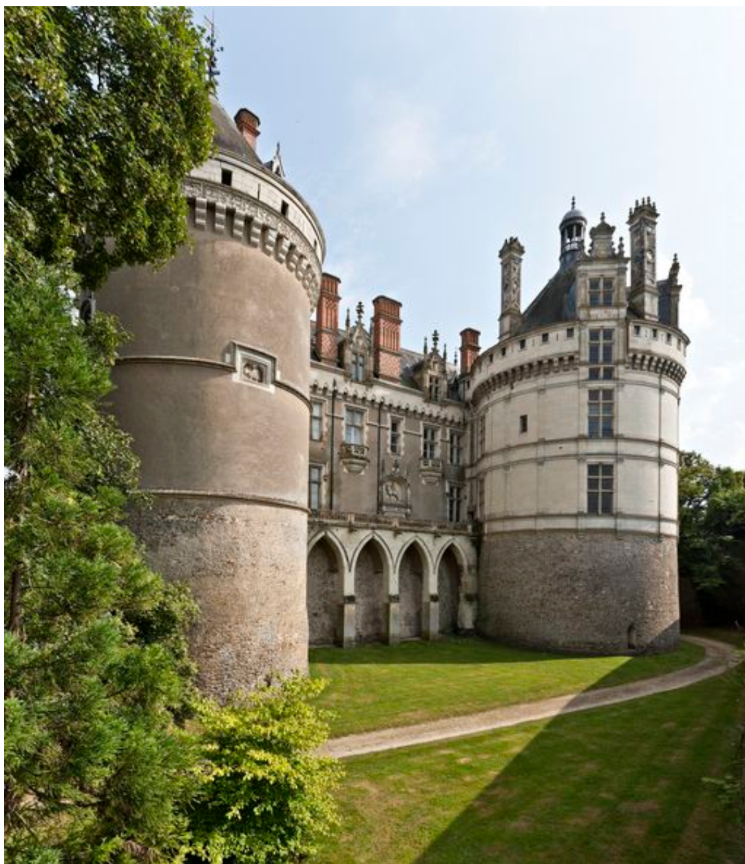
Aile nord : vue d'ensemble. A l'imitation de l'aile sud, un balcon est ajouté par Delarue vers 1860.
