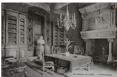
Aile sud, rez-de-chaussée, l'ancienne anti-chambre, actuelle bibliothèque. Remarquer le sol recouvert de moquette.
