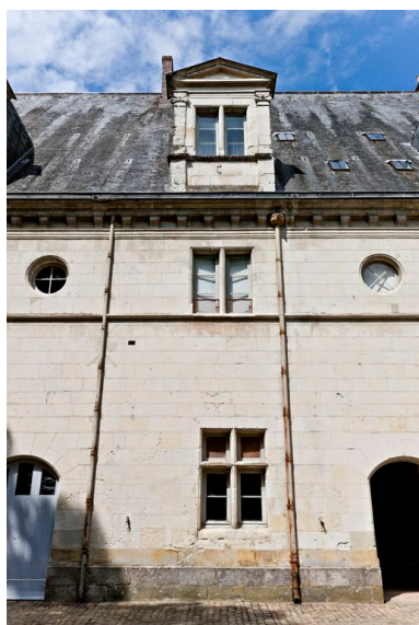
Les écuries et greniers à blé : travée de baies. Phot. Yves Guillotin IVR52_20127201332NUCA
