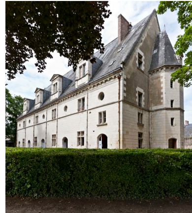
Les écuries et greniers à blé abritent au rez-de-chaussée, une sellerie et des écuries, côté nord, et plusieurs remises, côté sud. Phot. Yves Guillotin IVR52_20127201323NUCA
