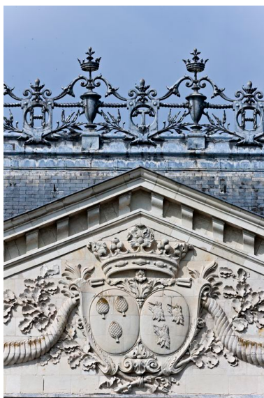
Aile est, fronton : armes des Talhouët (à gauche) et peut- être, des Baude de la Vieuville (à droite) surmontées d'une couronne de marquis. Les couronnes de l'épis de faîtage alternent avec les T[alhouët] et les H[onorez]. Phot. Yves Guillotin IVR52_20137200910NUCA
