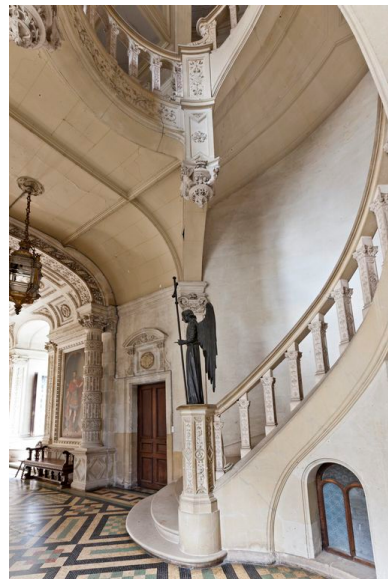
Tour nord-ouest, escalier en vis suspendu : rampe à balustres. Phot. Yves Guillotin IVR52_20137201007NUCA
