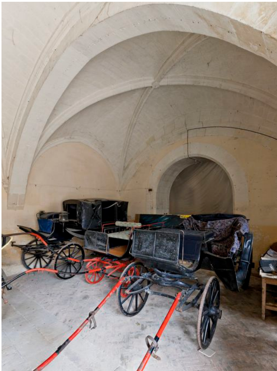
Les remises : croisées d'ogives séparées par des arcs doubleaux.
