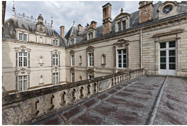
Façades sur la cour prises au-dessus du portique. Phot. Yves Guillotin IVR52_20137201002NUCA
