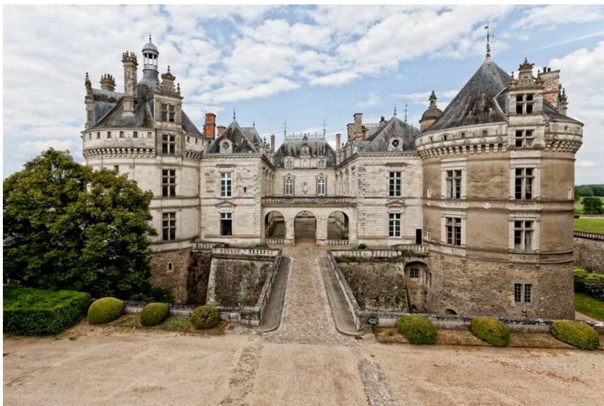
Vue d'ensemble de la façade occidentale.
