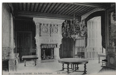
Aile sud, rez-de-chaussée, la salle à manger : remarquer le sol recouvert de moquette.
