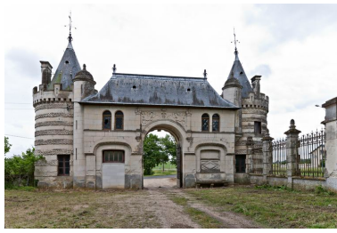
Le portail des Tourelles : face interne. La façade ordonnancée présente une fausse galerie à l'étage. Phot. Yves Guillotin IVR52_20127201419NUCA
