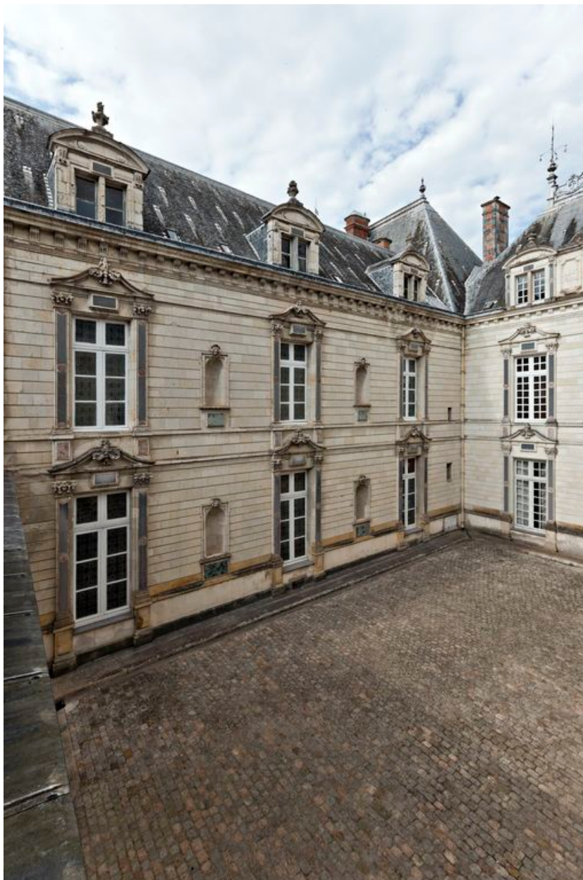
Façade de l'aile nord sur la cour.
