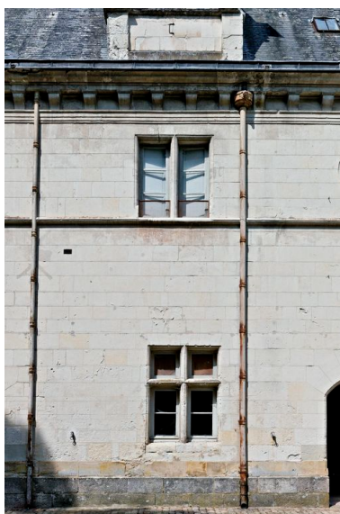
Les écuries et greniers à blé, face côté parc, travée de baies : détail. Phot. Yves Guillotin IVR52_20127201333NUCA
