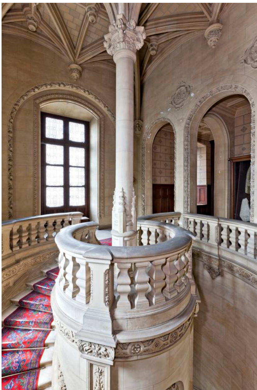
Aile est, escalier monumental, 1er étage : voûte d'ogives nervurées tournant sur le noyau.
