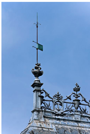
Aile est, détail : épi de faîtage en zing (S). Phot. Yves Guillotin IVR52_20137200908NUCA
