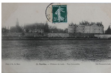
Vue d'ensemble prise de la rive droite. Autr. J.B., Phot. Jean-Baptiste (reproduction) Darrasse IVR52_20067207184NUCA
