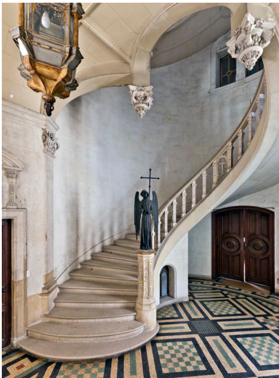
Tour nord-ouest : escalier en vis suspendu.
