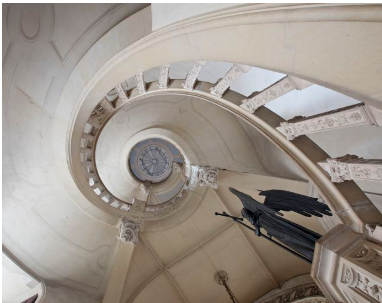
Tour nord-ouest : escalier en vis suspendu avec éclairage zénithal.
