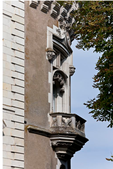
1er étage de la tour nord-est : baie remise en valeur lors de la restauration des années 1900. Phot. Yves Guillotin IVR52_20137200901NUCA
