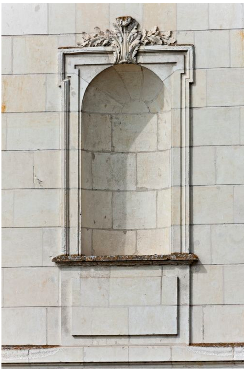
Aile est, avant-corps central, détail : niche.
