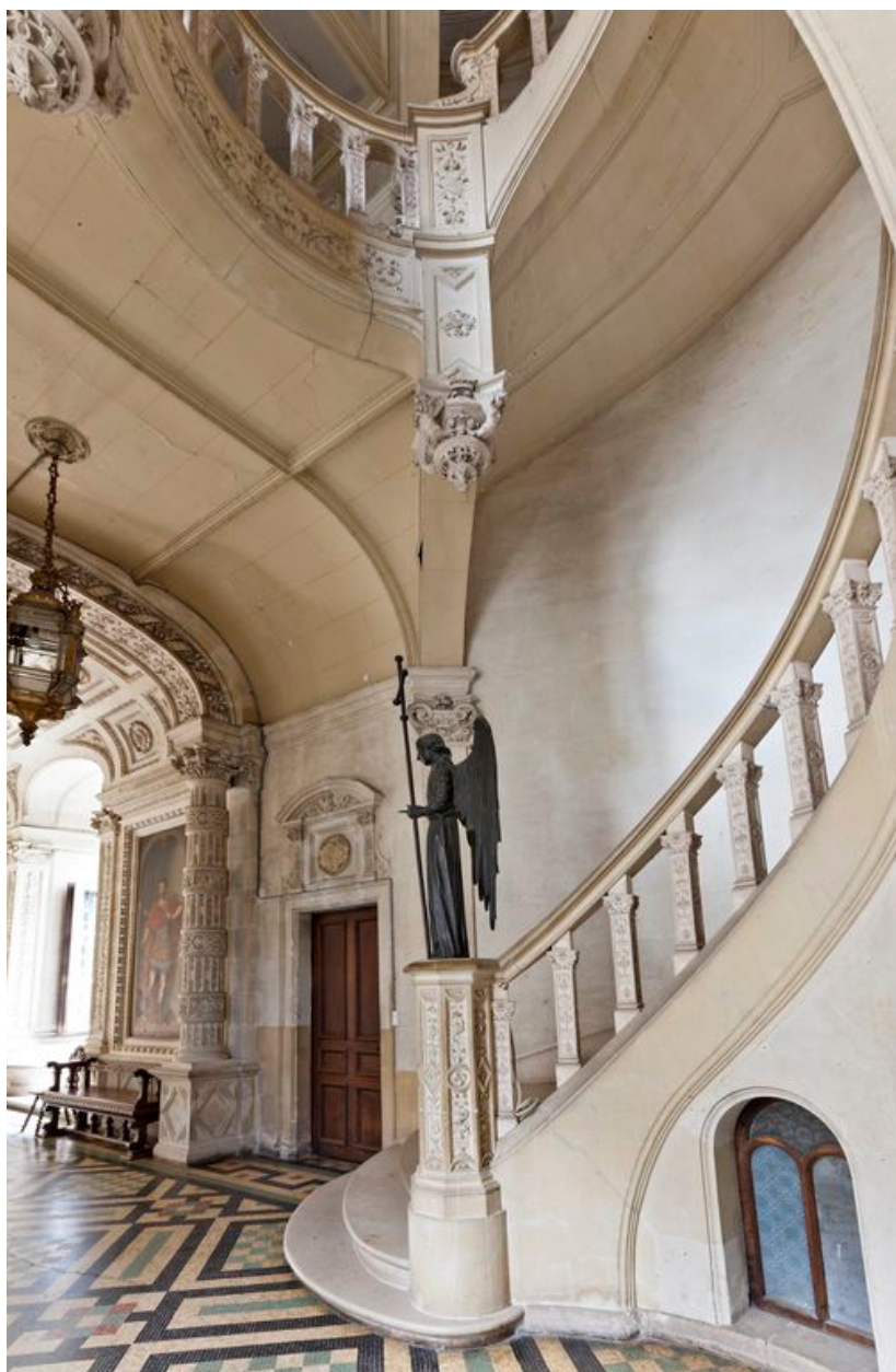
Tour nord-ouest, escalier en vis suspendu : rampe à balustres.
