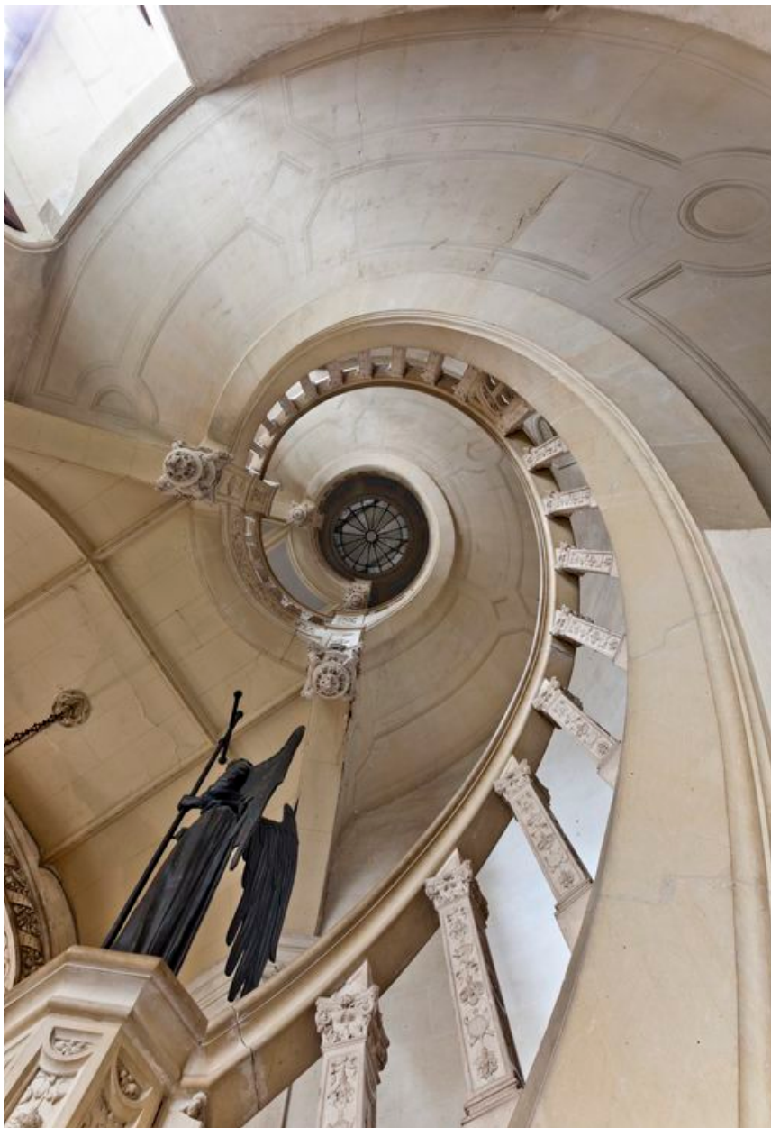
Tour nord-ouest : escalier en vis avec clés pendantes.
