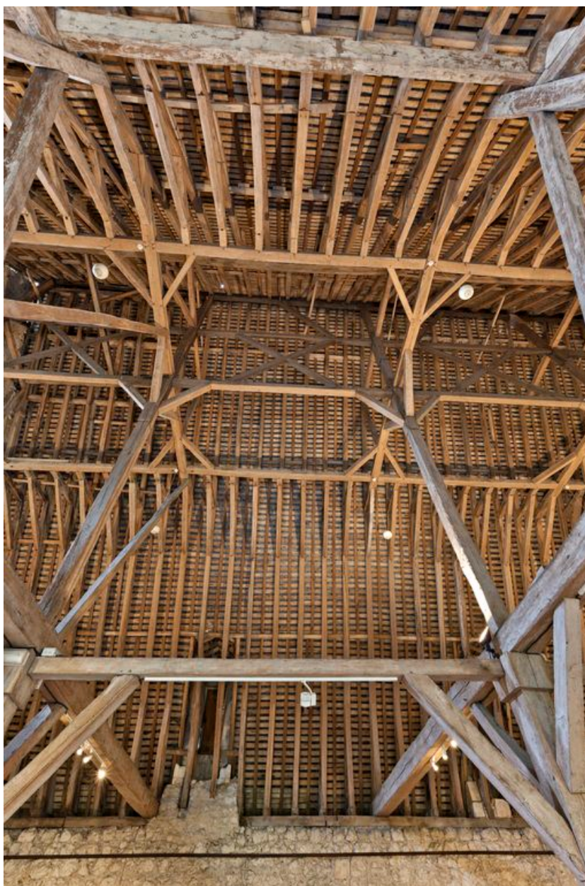
Les greniers à blé : une travée de charpente.
