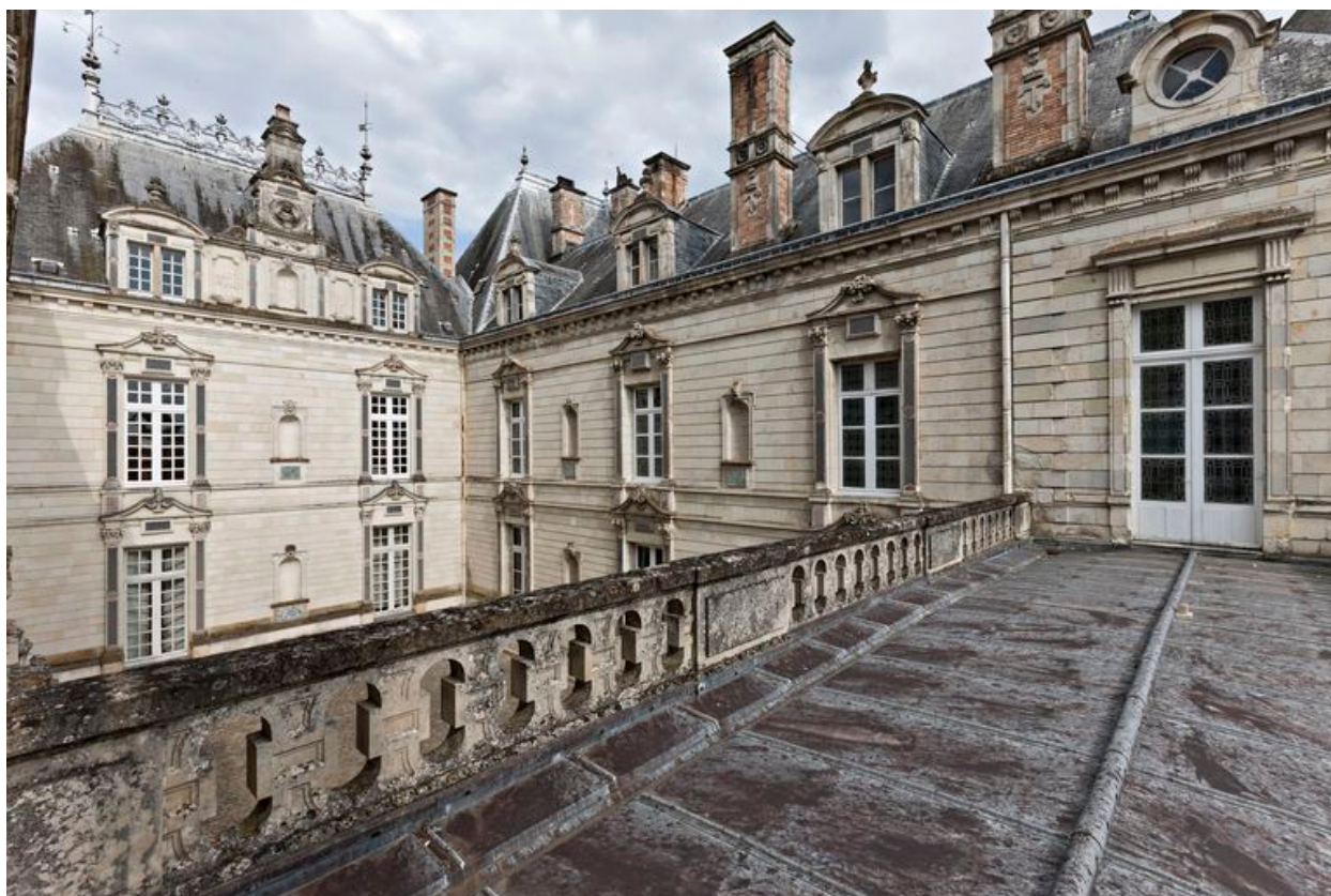
Façades sur la cour prises au-dessus du portique.
