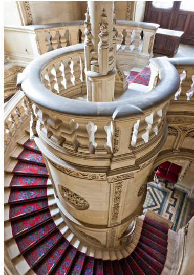
Aile sud, escalier monumental à une seule volée : le noyau forme une niche au rez-de-chaussée et une sorte de balcon à l'étage.
