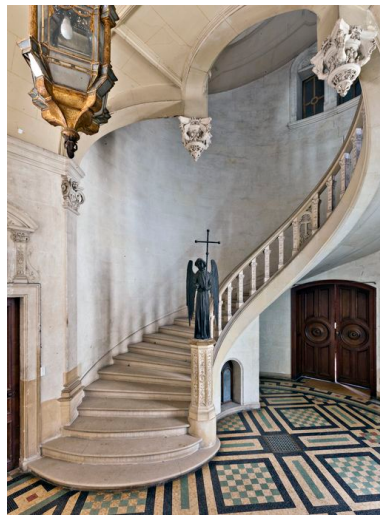
Tour nord-ouest : escalier en vis suspendu. Phot. Yves Guillotin IVR52_20137200973NUCA
