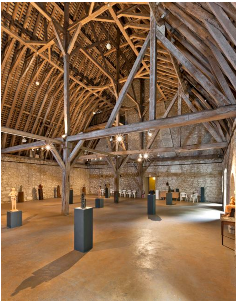
Les greniers à blé : les sous-faîtages sont consolidés par des croix-de-saint-André.
