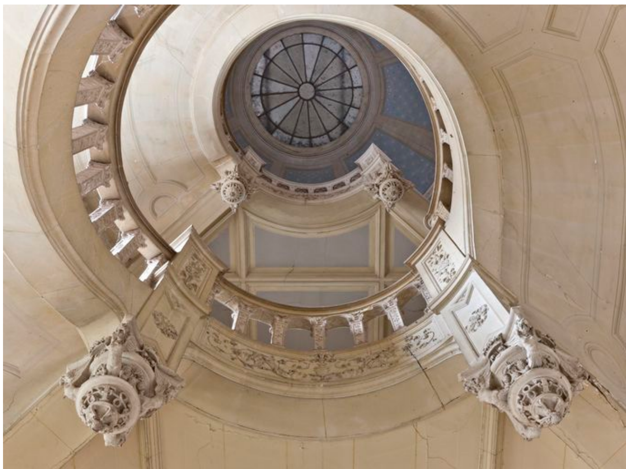
Tour nord-ouest, escalier en vis suspendu : détail du palier du 1er étage.
