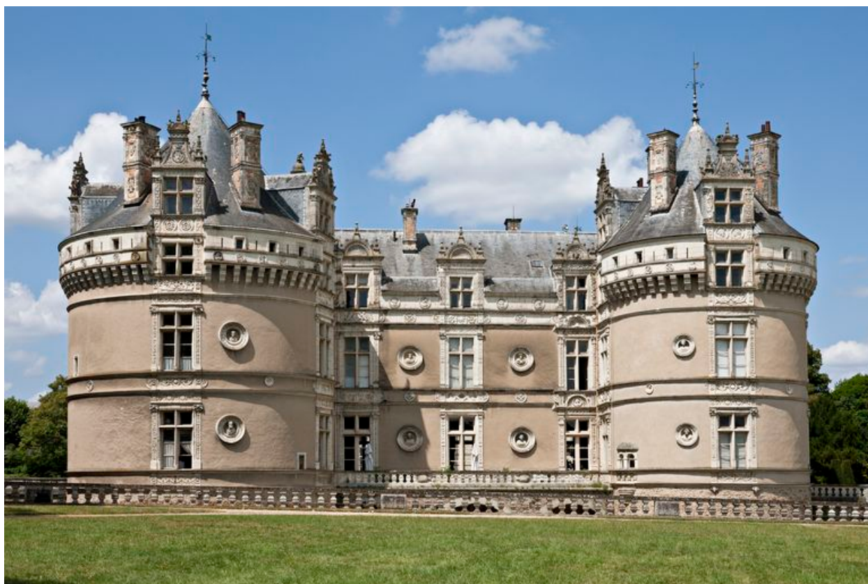
Aile sud prise de la grande terrasse.
