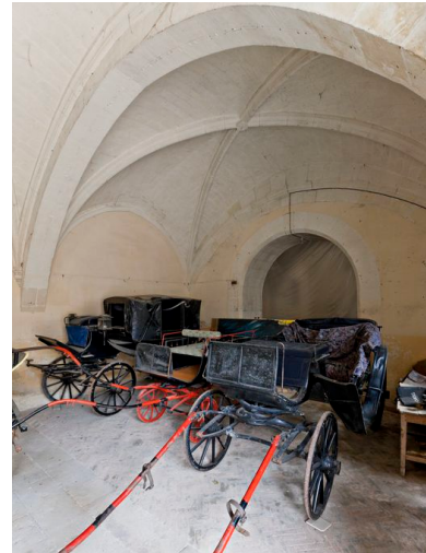
Les remises : croisées d'ogives séparées par des arcs doubleaux. Phot. Yves Guillotin IVR52_20127201335NUCA
