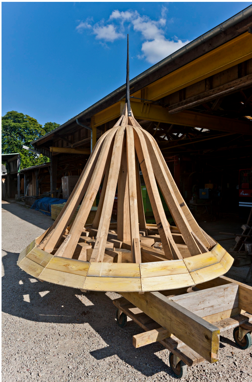
Vue de la charpente du colombier après restauration en 2014.
