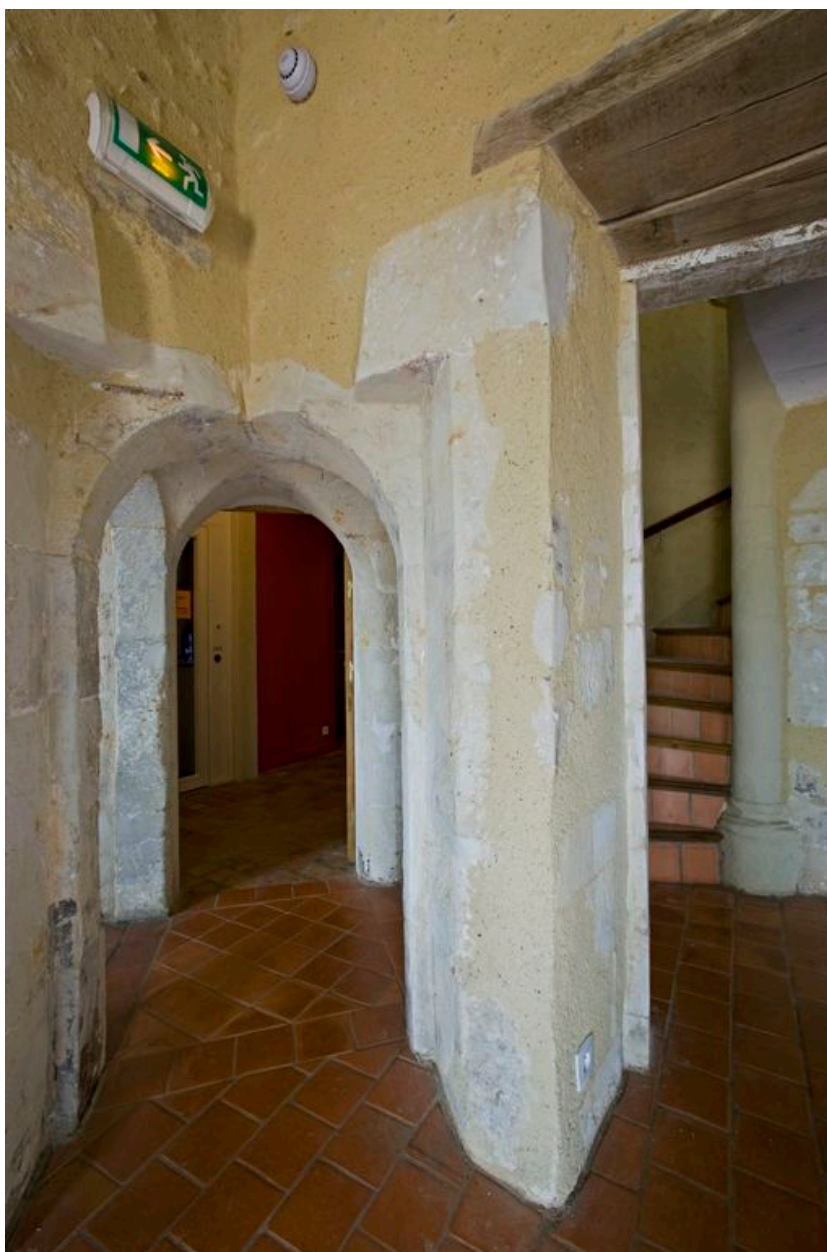
Couloir distribuant depuis l'escalier les deux corps du logis (le percement à droite est récent)
