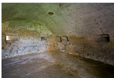
Vue intérieure du rez-de-chaussée du colombier Phot. Yves Guillotin IVR52_20107202384NUCA
