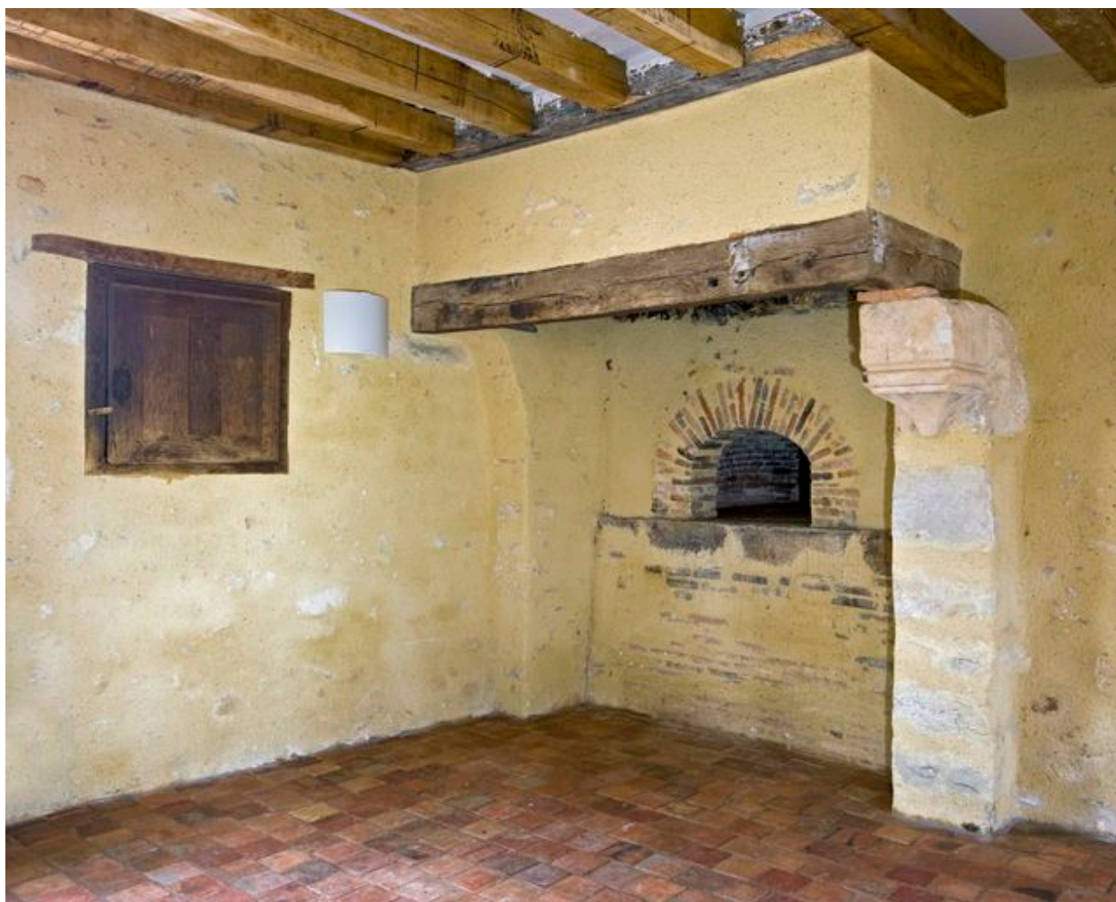
Cheminée du fournil
