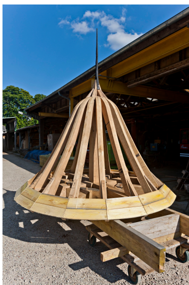
Vue de la charpente du colombier après restauration en 2014. Phot. Yves Guillotin IVR52_20147201901NUCA
