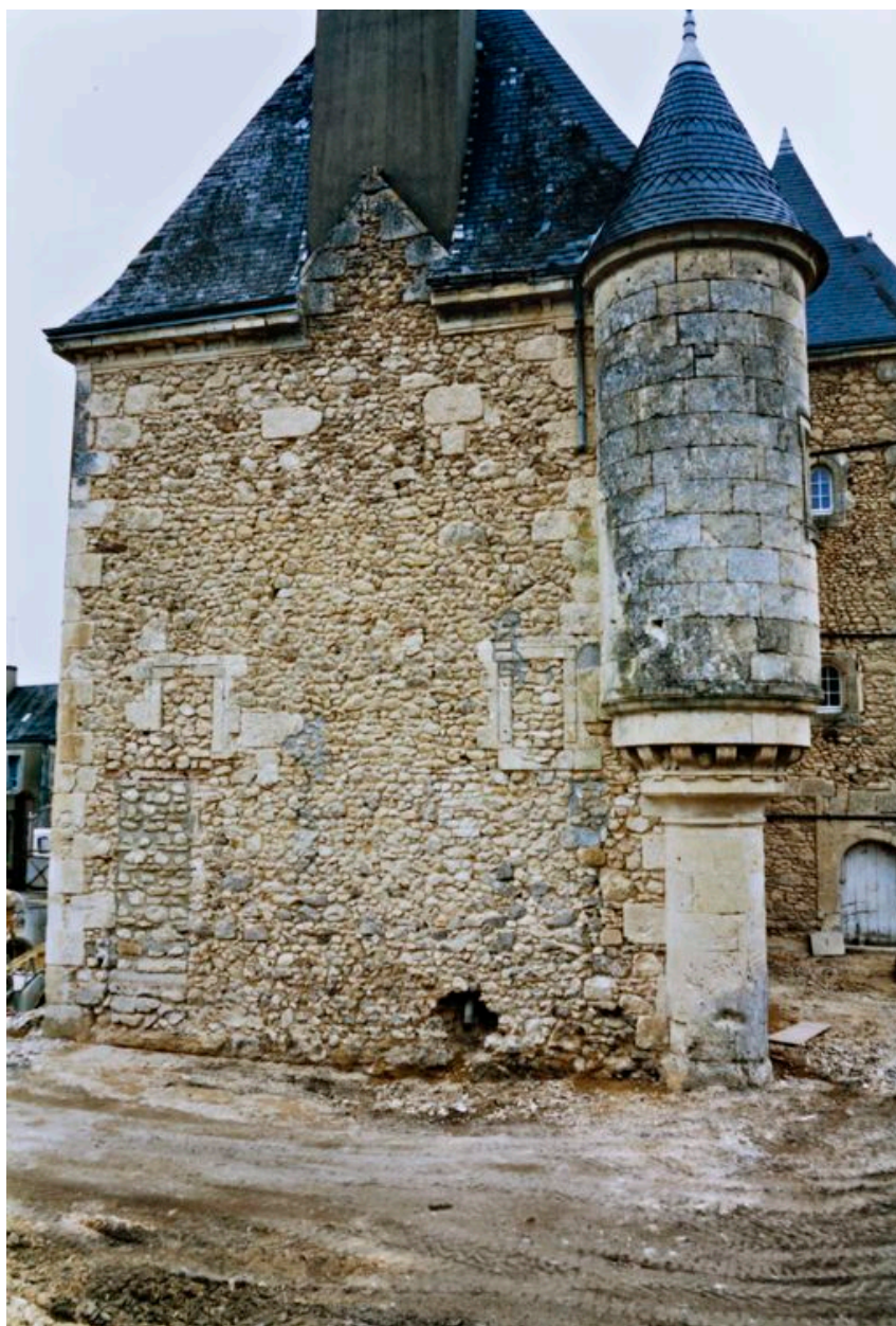
Logis, mur-pignon ouest : état pendant la restauration de 2008. A noter les deux fenêtres bouchées au rez-de-chaussée.
