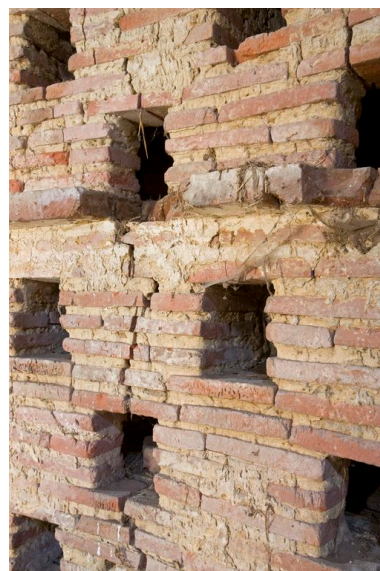
Détail de l'intérieur du colombier : boudins appareillés en briques Phot. Yves Guillotin IVR52_20107202382NUCA
