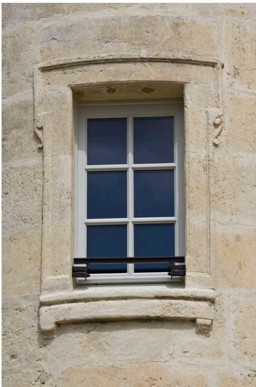
Fenêtre de la tourelle sud du logis
