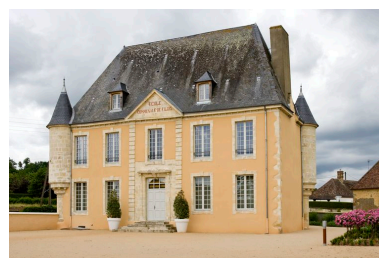
Elevation nord du logis Phot. Yves Guillotin IVR52_20107202385NUCA
