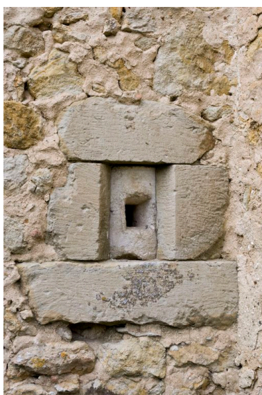
Canonnière à rotule du colombier Phot. Yves Guillotin IVR52_20107202389NUCA
