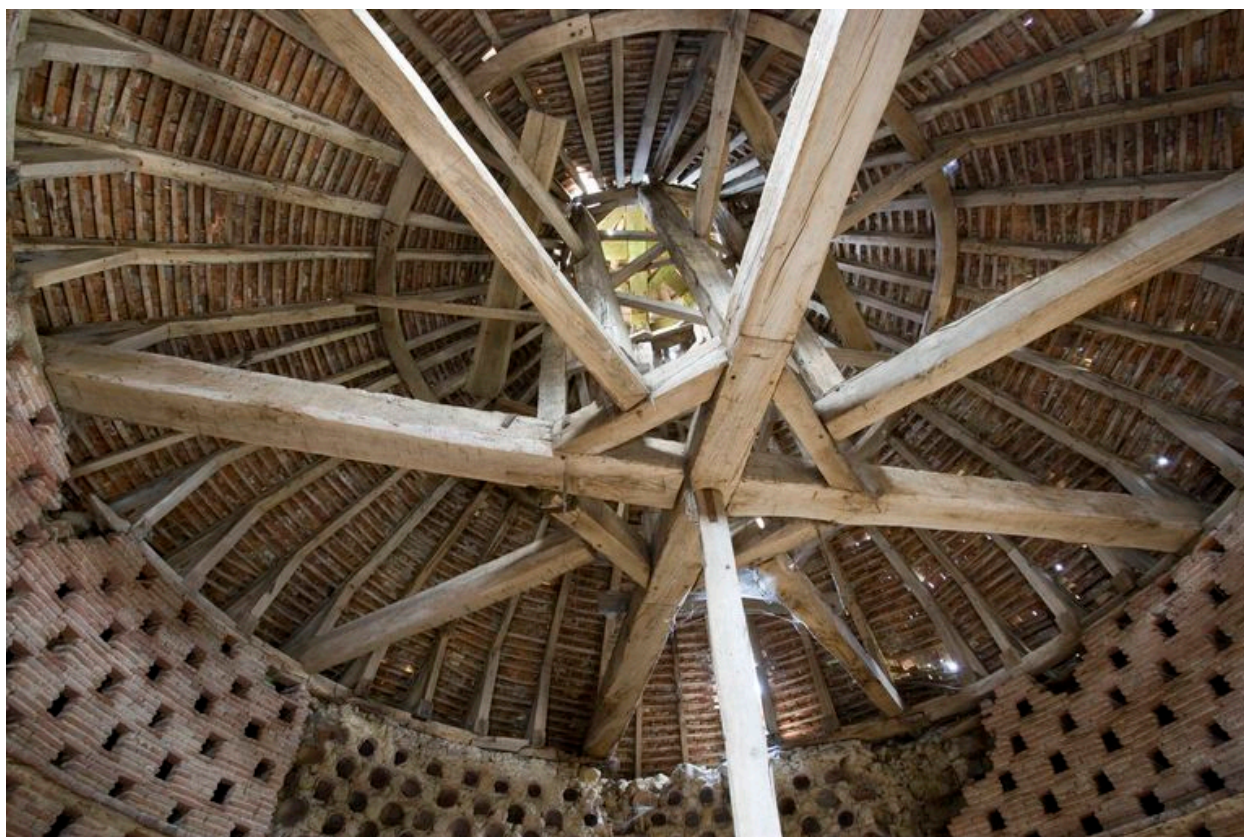
Charpente du colombier
