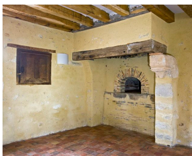
Cheminée du fournil Phot. Yves Guillotin IVR52_20107202371NUCA
