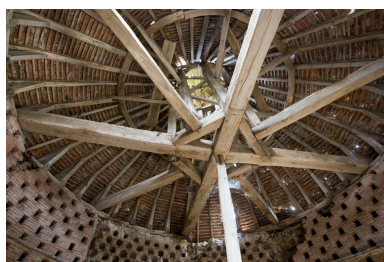
Charpente du colombier Phot. Yves Guillotin IVR52_20107202381NUCA
