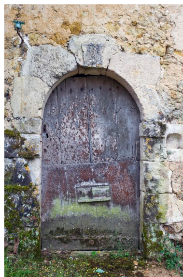
Porte du rez-de- chaussée du colombier Phot. Yves Guillotin IVR52_20107202316NUCA
