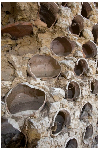
Détail de l'intérieur du colombier : pots en céramique servant de boudins Phot. Yves Guillotin IVR52_20107202383NUCA
