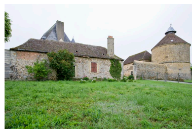
Vue d'ensemble depuis l'ouest Phot. Yves Guillotin IVR52_20107202318NUCA
