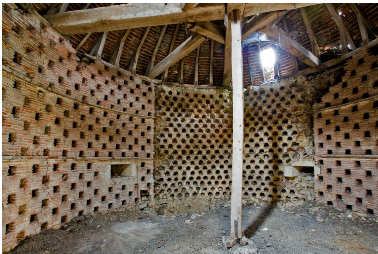
Vue intérieure de l'étage du colombier
