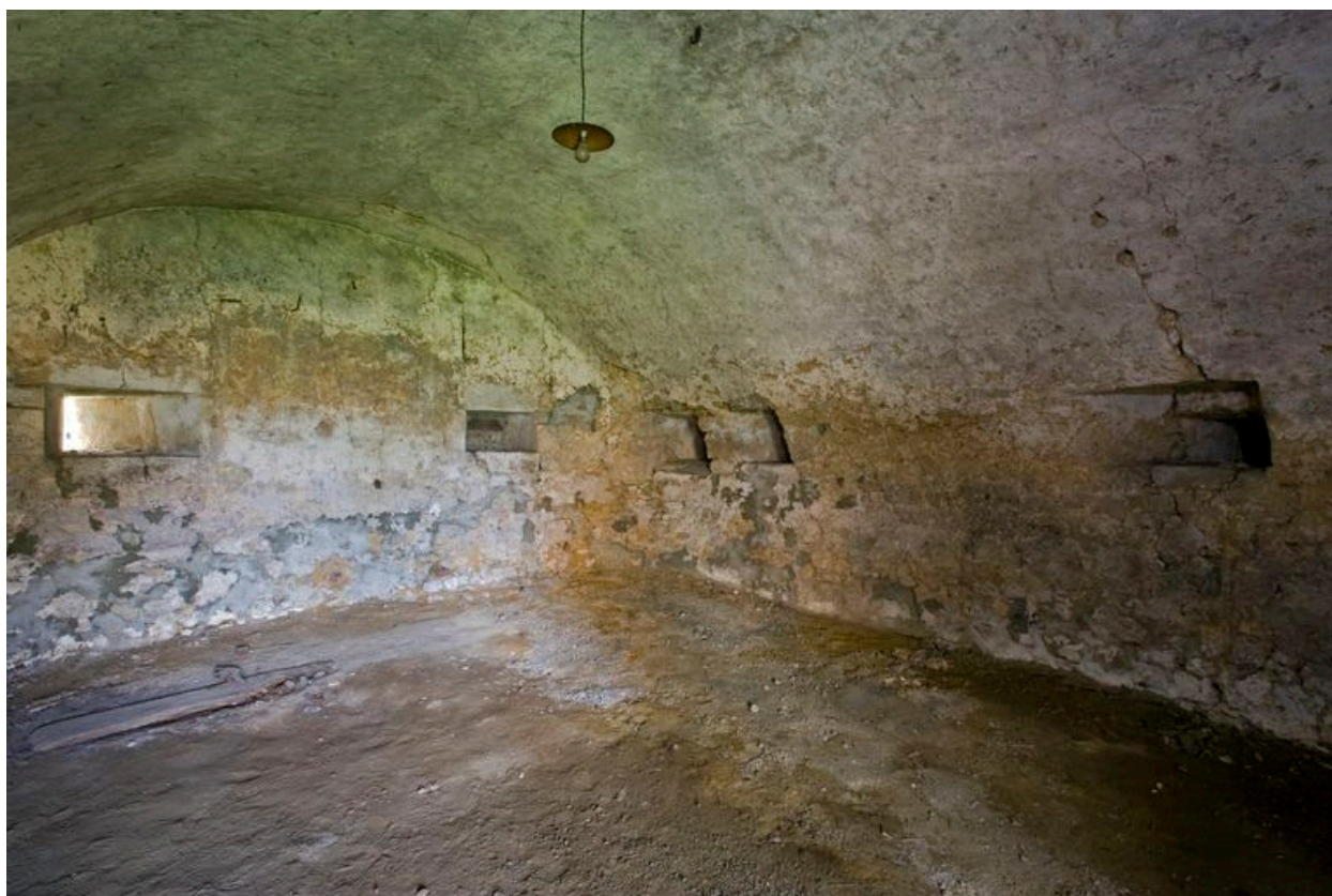
Vue intérieure du rez-de-chaussée du colombier
