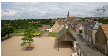
Vue de l'ancien jardin haut et du préau de l'école Phot. Yves Guillotin IVR52_20107202373NUCA
