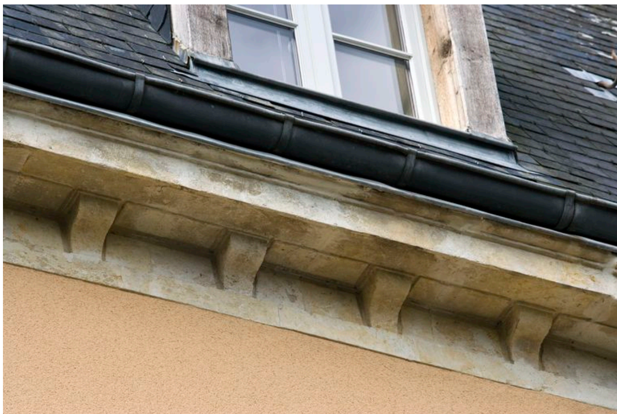
Détail de la corniche du logis
