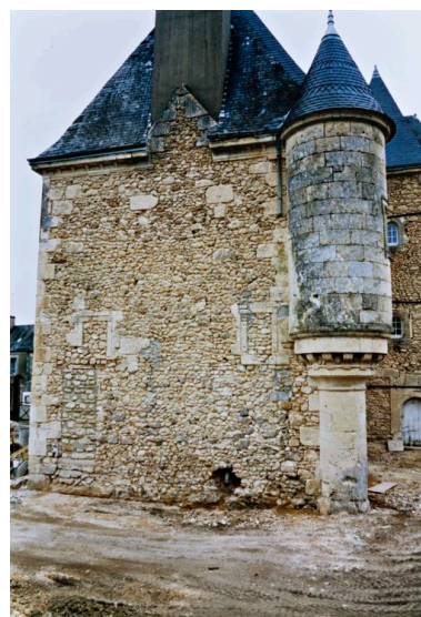
Logis, mur-pignon ouest : état pendant la restauration de 2008. A noter les deux fenêtres bouchées au rez-de-chaussée. Phot. Patrick Roclain, Phot. Yves Guillotin IVR52_20137200631NUCA
