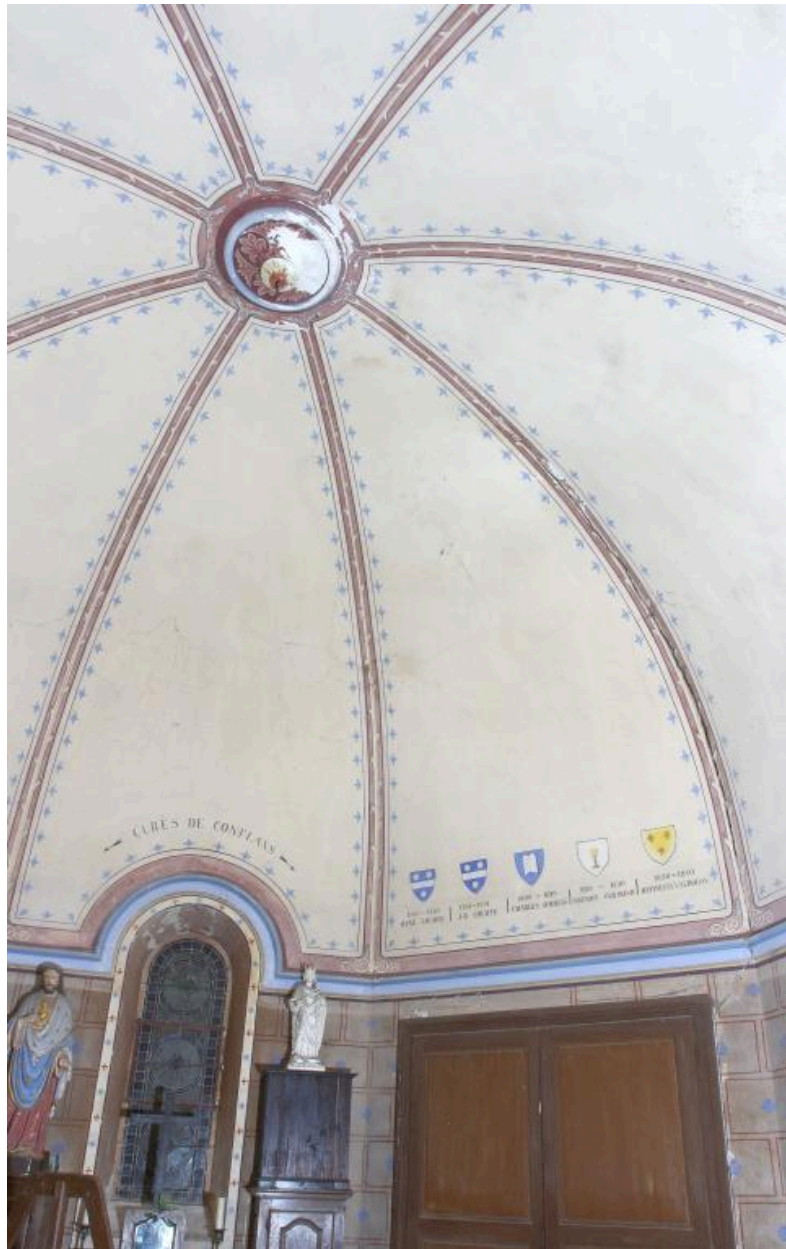
Sacristie, partie sud-est. Suite de l'armorial.
