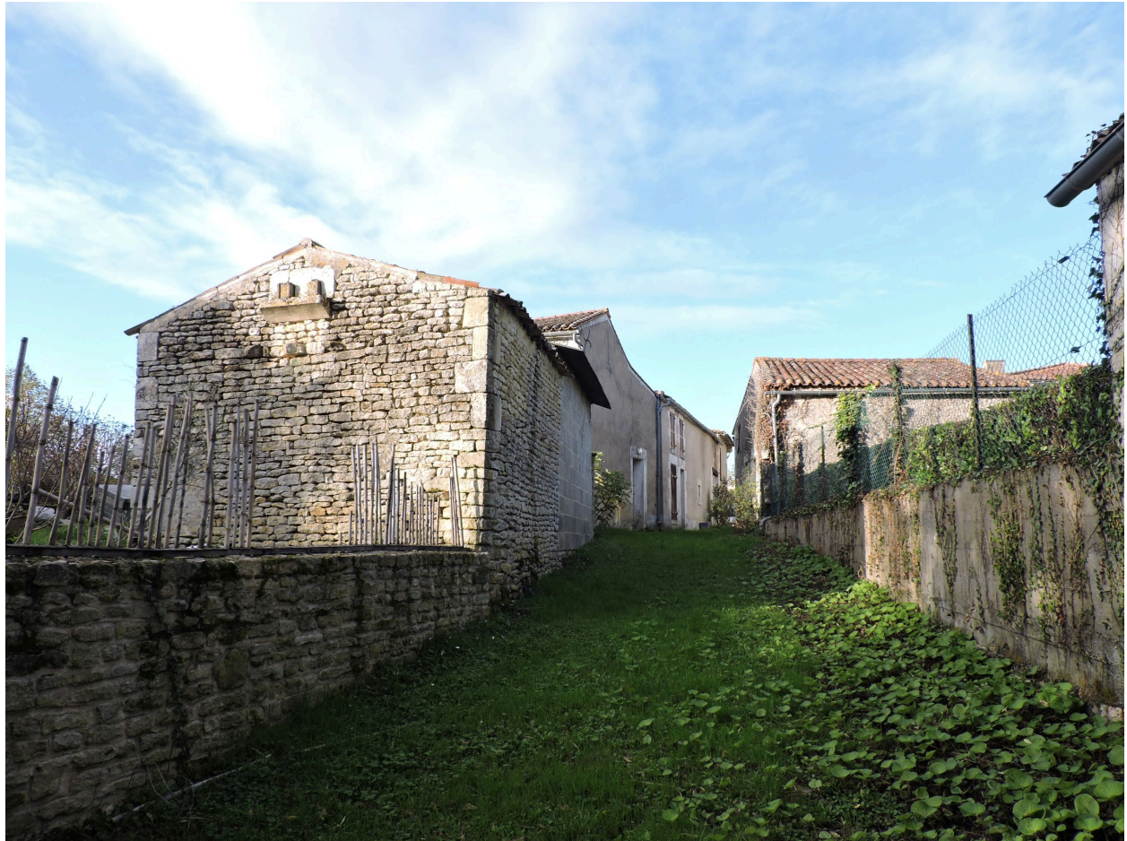
La ruelle ou venelle descendant au port depuis la Grand rue, vue depuis le sud.
