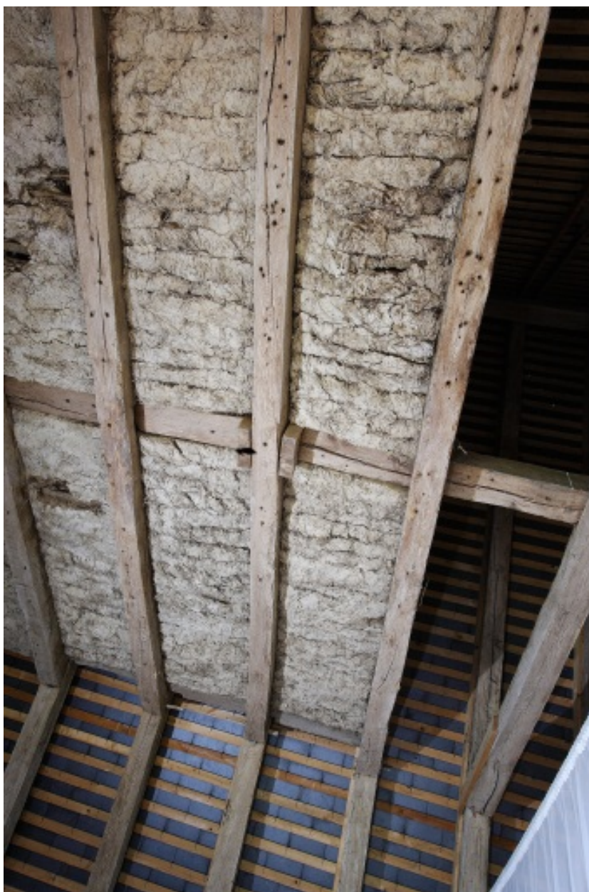
Le logis, corps central : plancher de torchis aménagé au niveau des faux-entrants de la partie ouest de la charpente.
