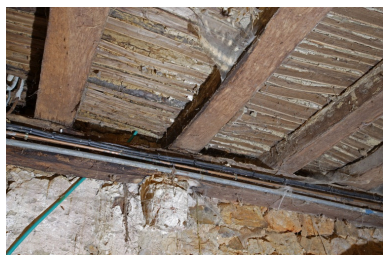
Le logis, corps est, étage de soubassement : poutre de rive sur corbeaux. Phot. François Lasa IVR52_20065302800NUCA
