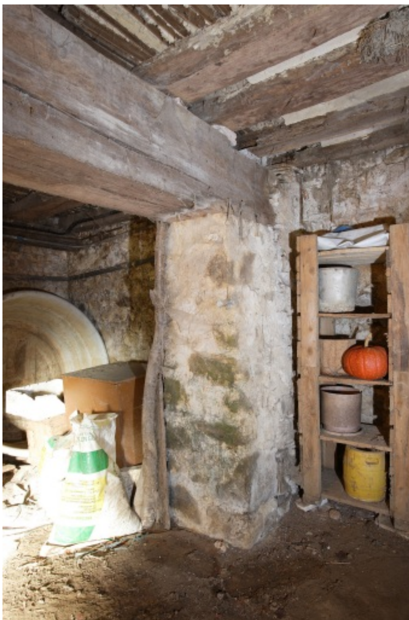
Le logis, corps est, étage de soubassement : poutre transversale sur pilier.
