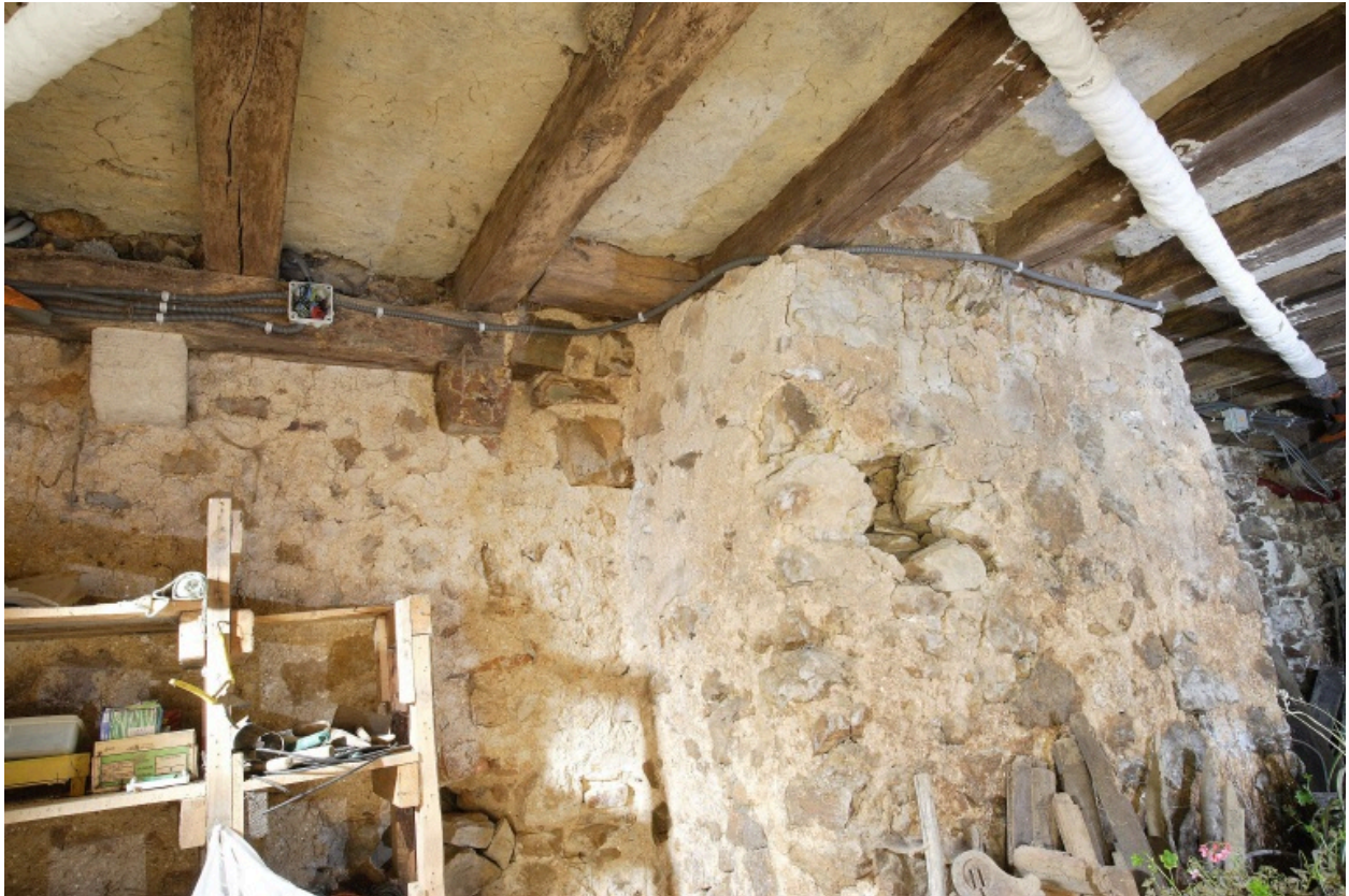
Le logis, corps central, étage de soubassement, pièce ouest, mur ouest : poutre de rive sur corbeaux et massif de soubassement de la cheminée (supprimée)
