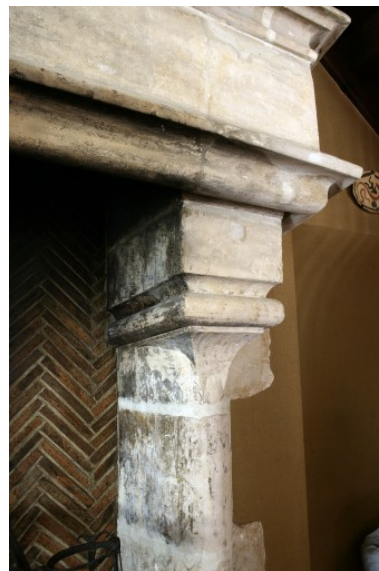
La cheminée remontée à Ballée : le corbeau droit. Phot. François Lasa IVR52_20075301526NUCA
