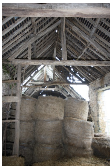
L'étable est : la charpente vue depuis le nord.
