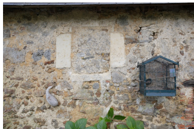
Le logis, corps est, façade nord : fenêtre bouchée. Phot. François Lasa IVR52_20065302799NUCA
