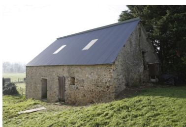
L'étable ouest vue depuis le nord-est.
