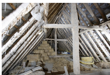
Le fournil-étable : la charpente vue depuis le nord.
