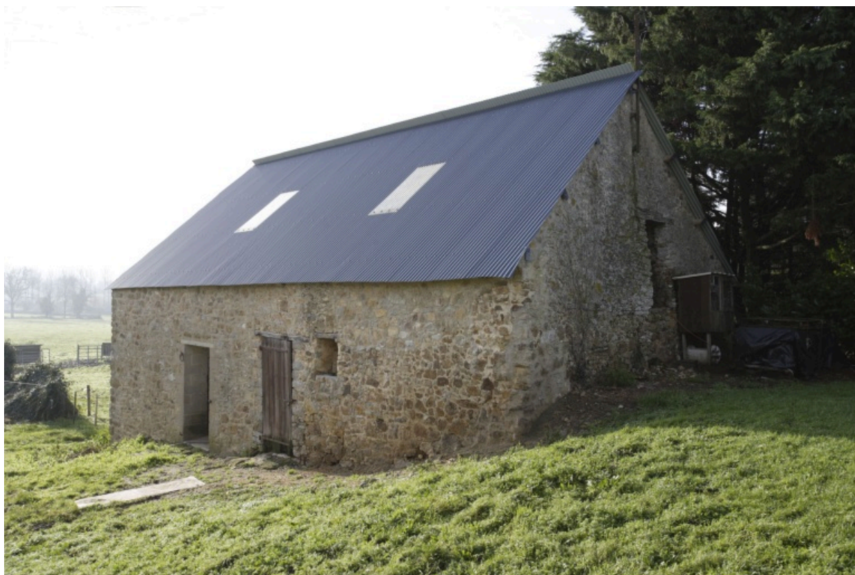
L'étable ouest vue depuis le nord-est.
