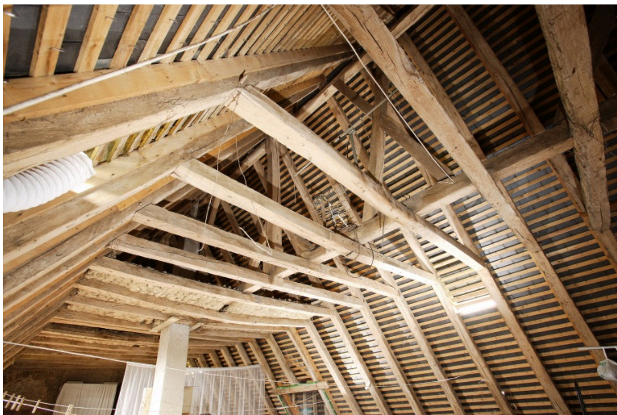
Le logis, corps central : la charpente.
