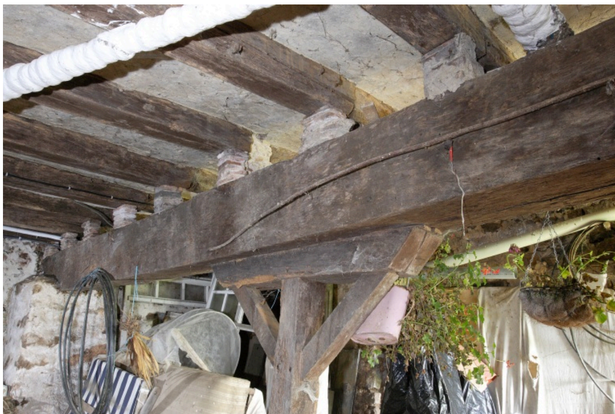
Le logis, corps central, étage de soubassement, pièce ouest : poutre centrale sur piliers.
