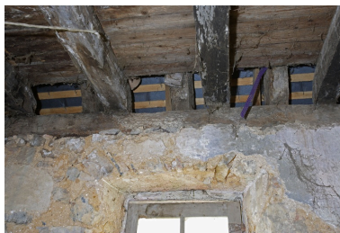
Le logis, corps est : détail du plancher et de la base de la charpente.
