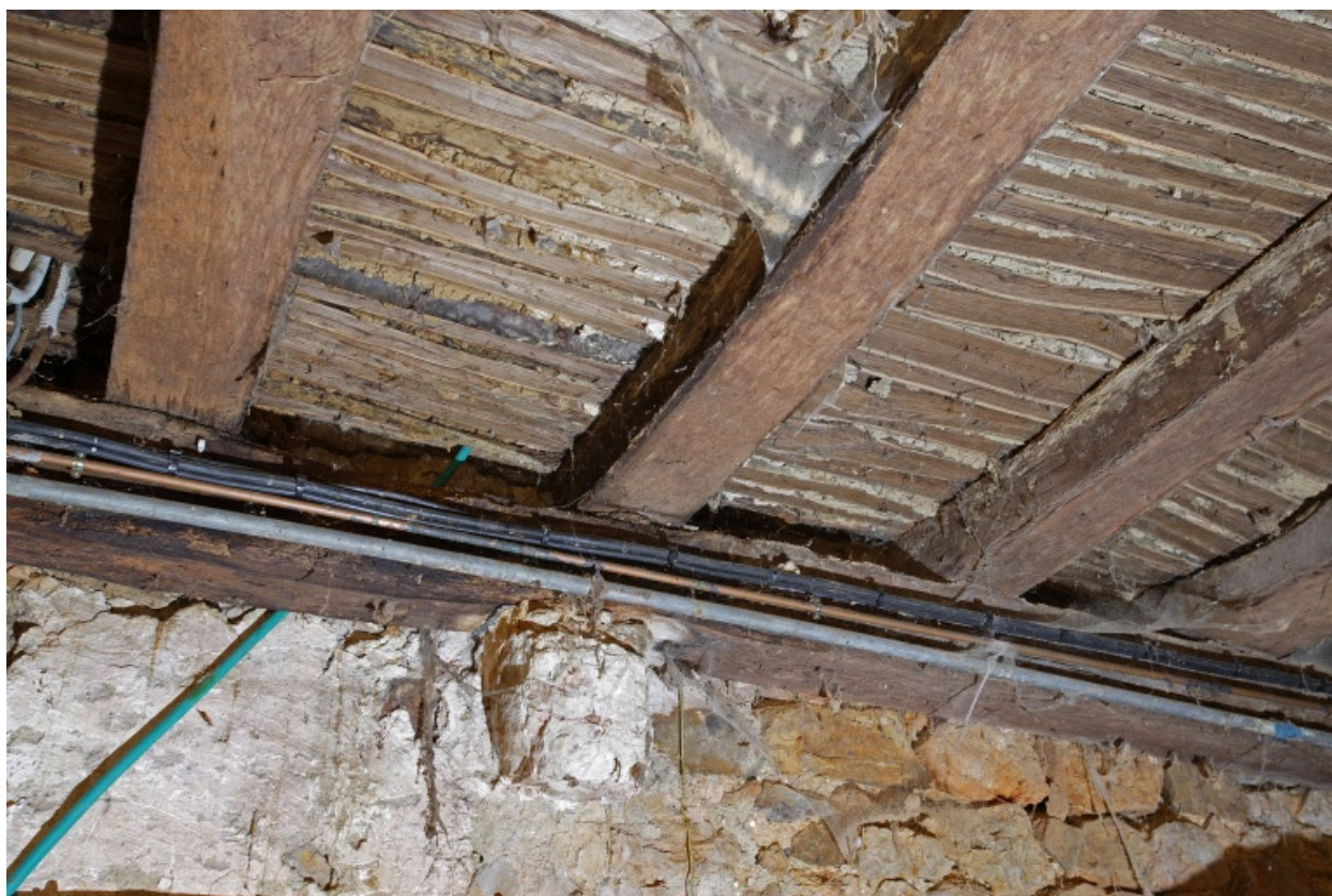
Le logis, corps est, étage de soubassement : poutre de rive sur corbeaux.
