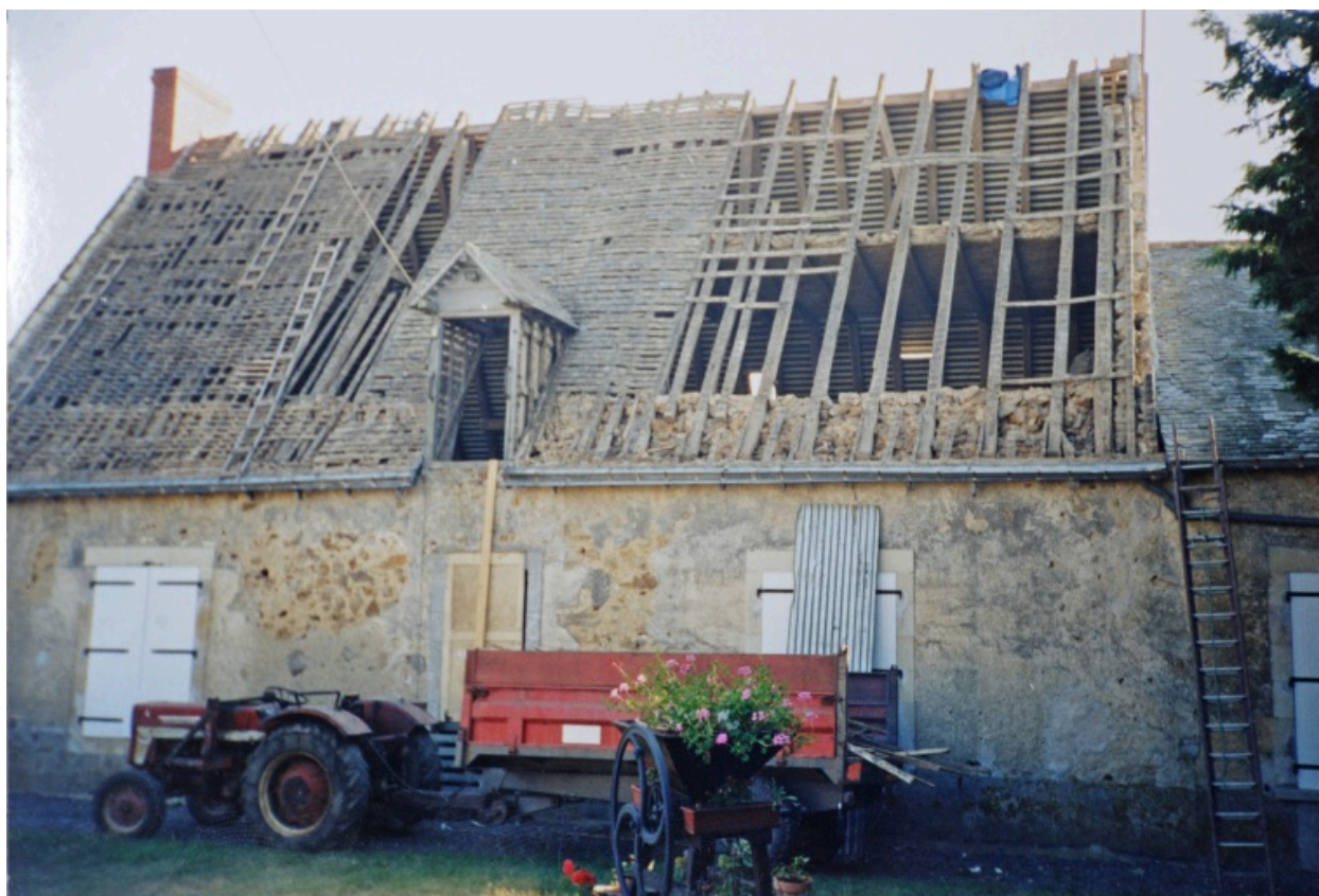
Photographie, années 1990 : le logis pendant la réfection de la couverture.
