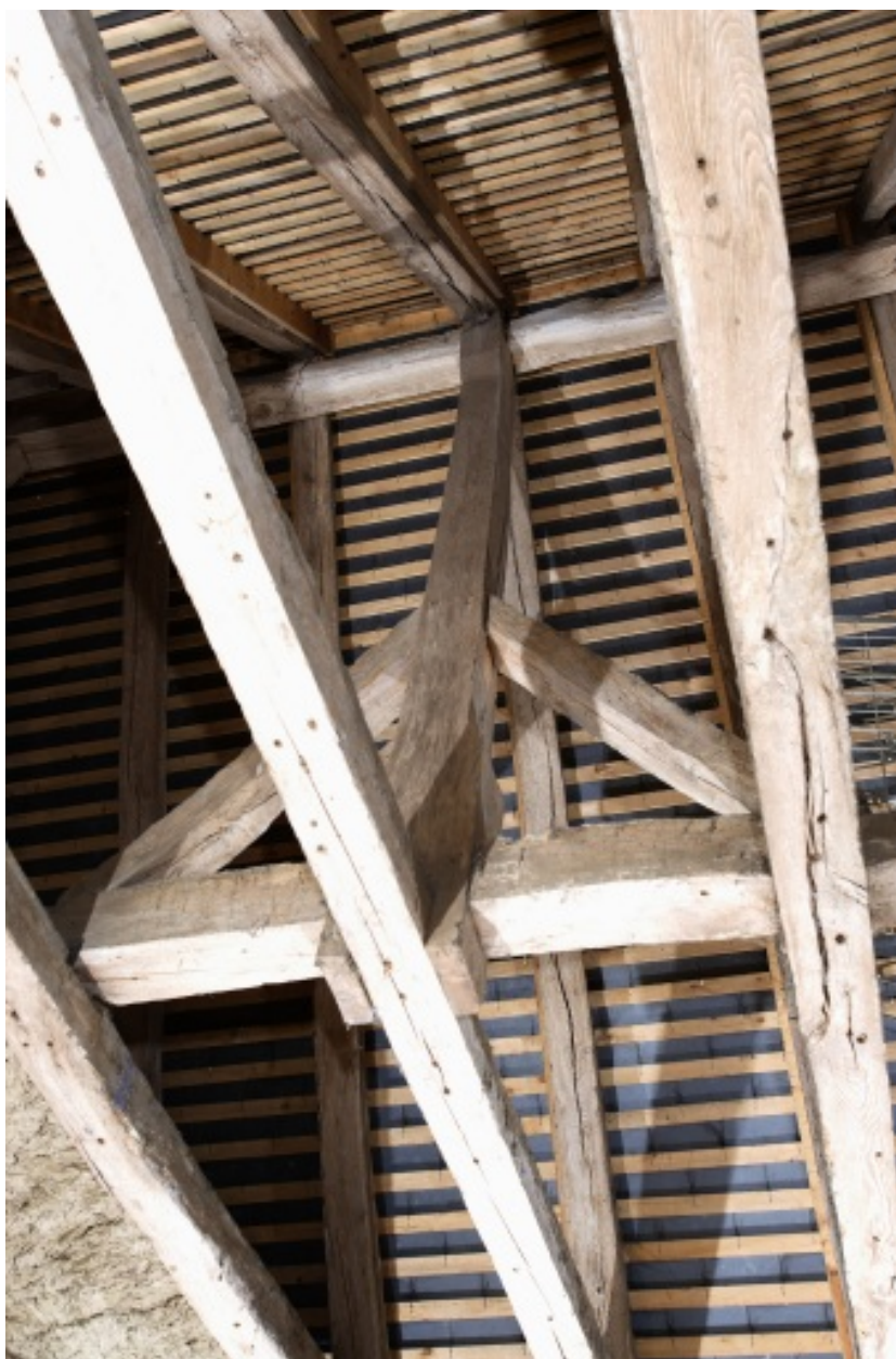
Le logis, corps central, détail de la charpente : ferme principale.
