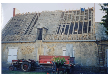
Photographie, années 1990 : le logis pendant la réfection de la couverture. Autr. Sergent, Phot. François Lasa IVR52_20065302814NUCAB
