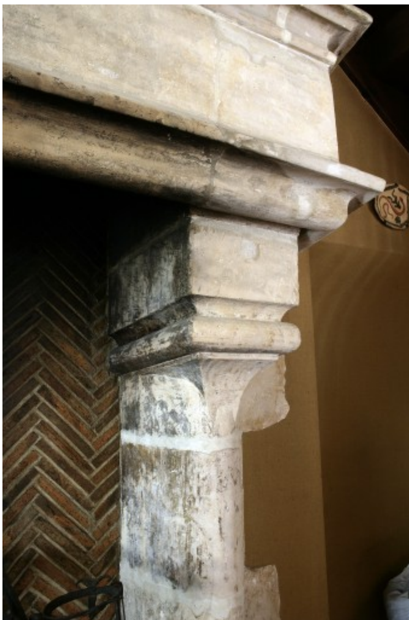
La cheminée remontée à Ballée : le corbeau droit.
