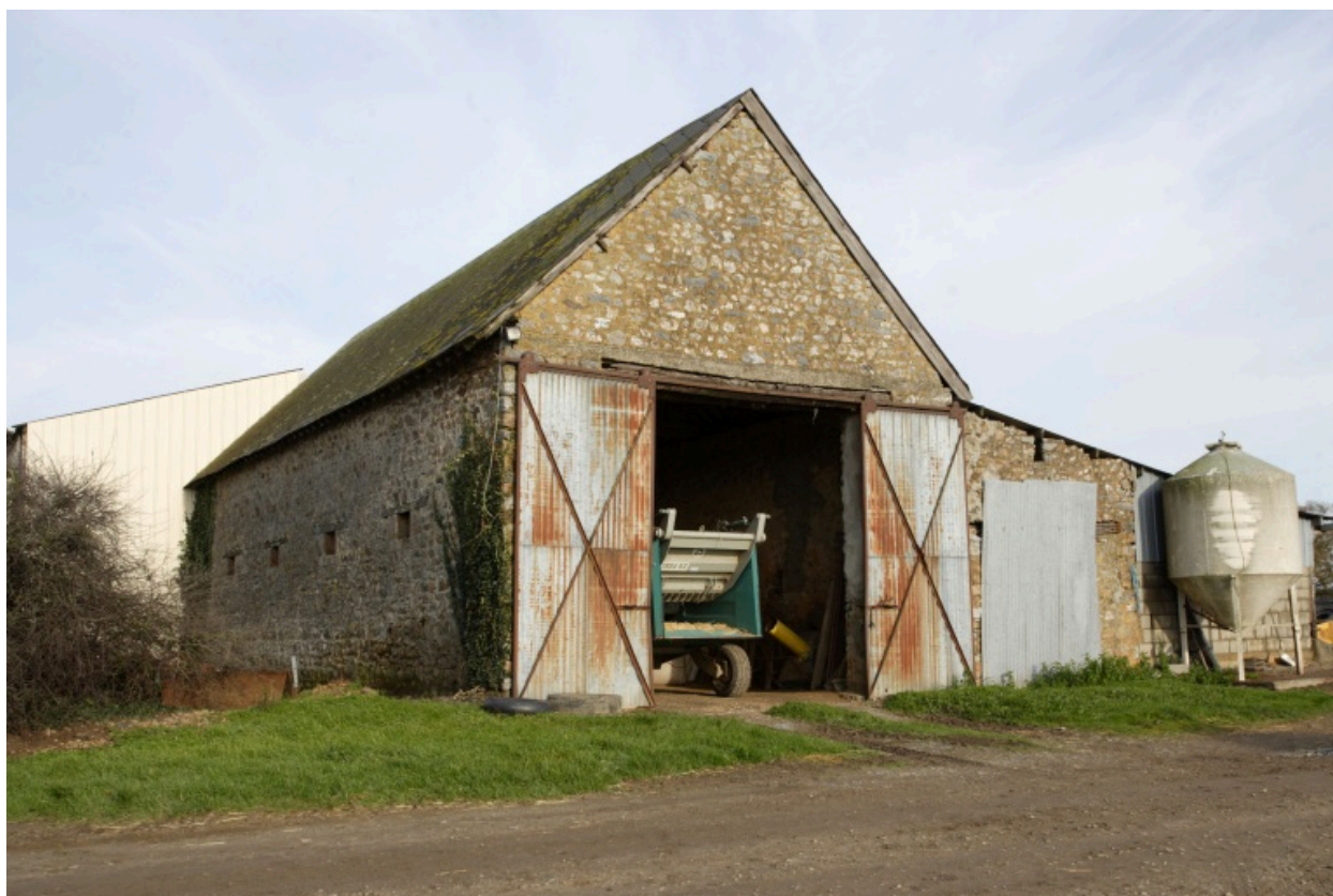
La remise vue depuis le chemin au sud-ouest.
