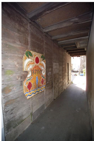
Vue du passage depuis la rue du Faisan. Phot. François Lasa IVR52_20034401199NUCA
