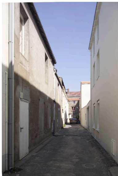
La cour depuis le sud. Phot. François Lasa IVR52_20034401192NUCA
