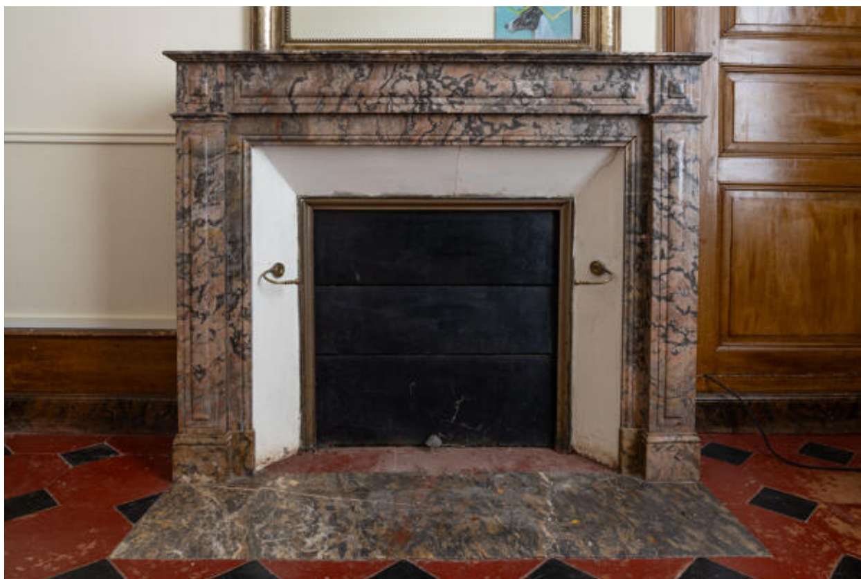
Cheminée du rez-de-chaussée (sud).
