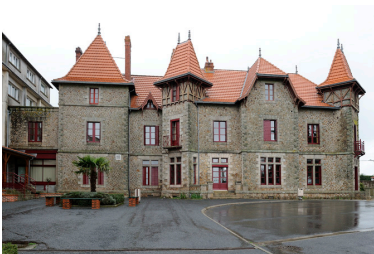
Façade ouest. Phot. Bruno Rousseau IVR52_20114900254NUCA
