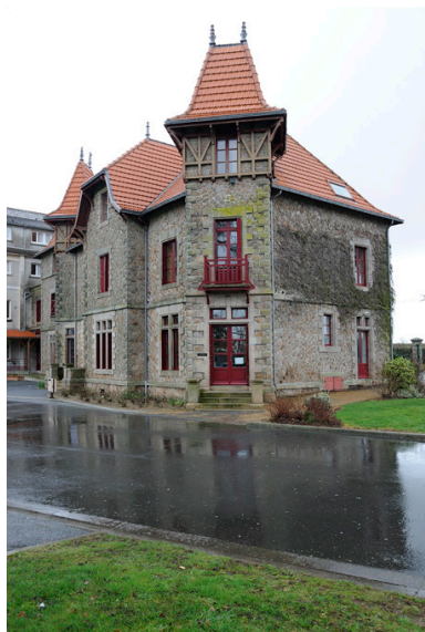
Façade sud. Phot. Bruno Rousseau IVR52_20114900253NUCA
