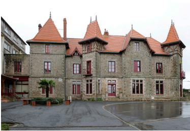
Façade ouest. Phot. Bruno Rousseau IVR52_20114900254NUCA
