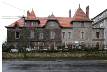
Vue générale de la façade est. Phot. Bruno Rousseau IVR52_20114900255NUCA
