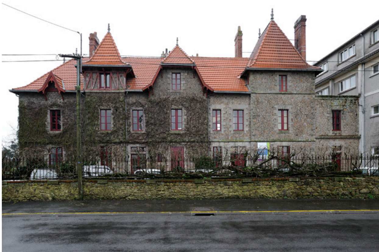
Vue générale de la façade est.
