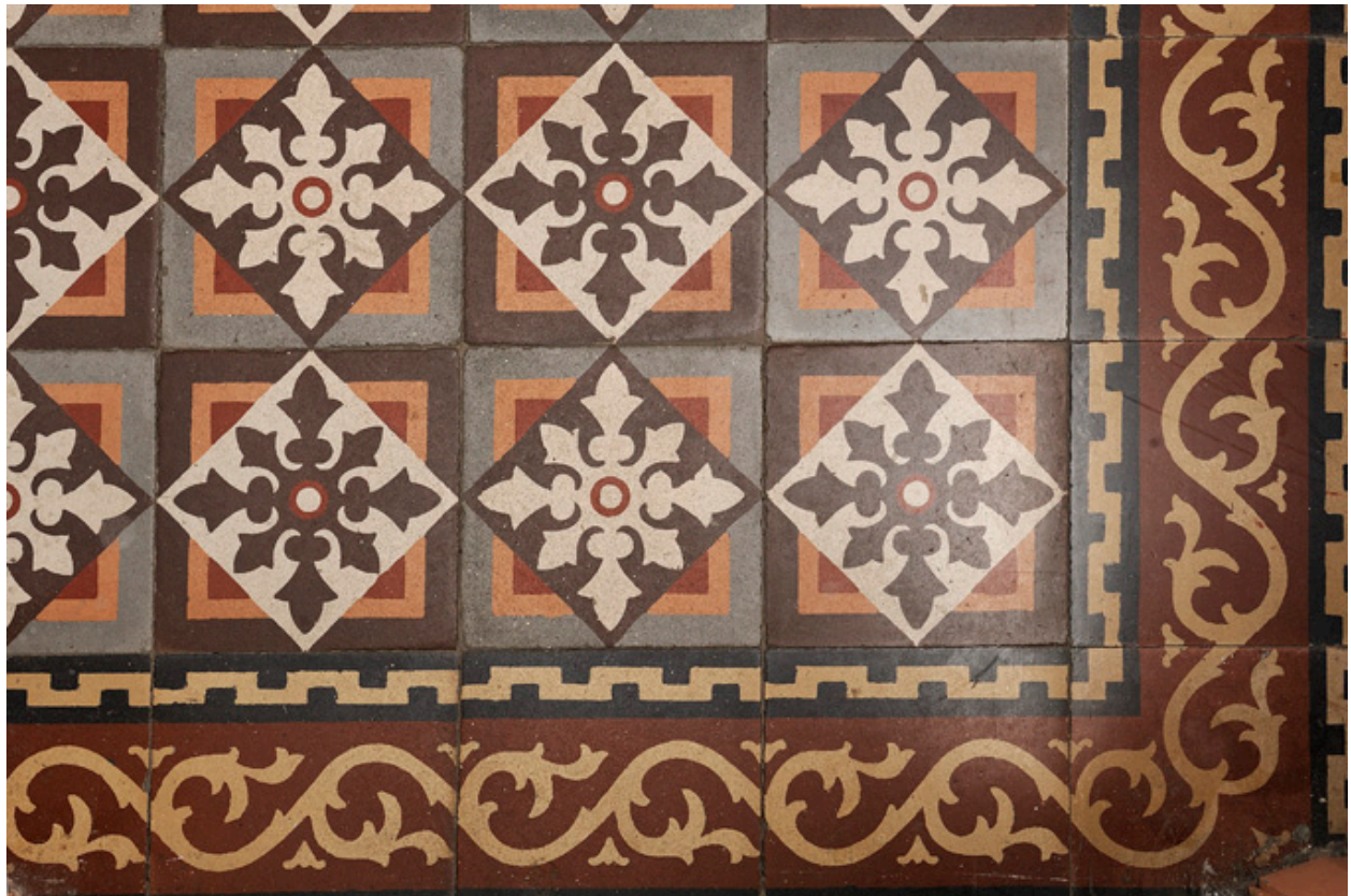
Détail d'un dallage, situé dans un couloir de distribution.
