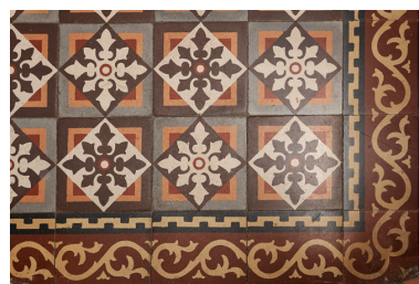
Détail d'un dallage, situé dans un couloir de distribution. Phot. Bruno Rousseau IVR52_20114900249NUCA
