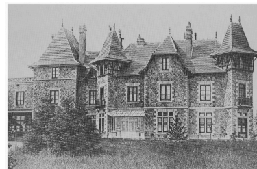
Photographie de la façade ouest, 1er quart du XXe siècle. Phot. Youenn Communeau IVR52_20104902282NUCAB
