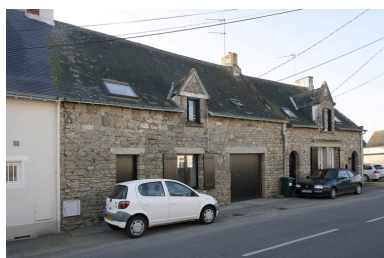
Vue des n° 24 et 26 de la rue du Ber. Phot. Denis Pillet IVR52_20084400220NUCA
