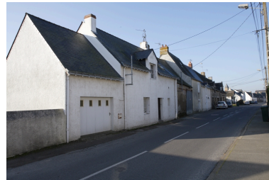
Vue d'ensemble depuis le nord-ouest. Phot. Denis Pillet IVR52_20084400219NUCA
