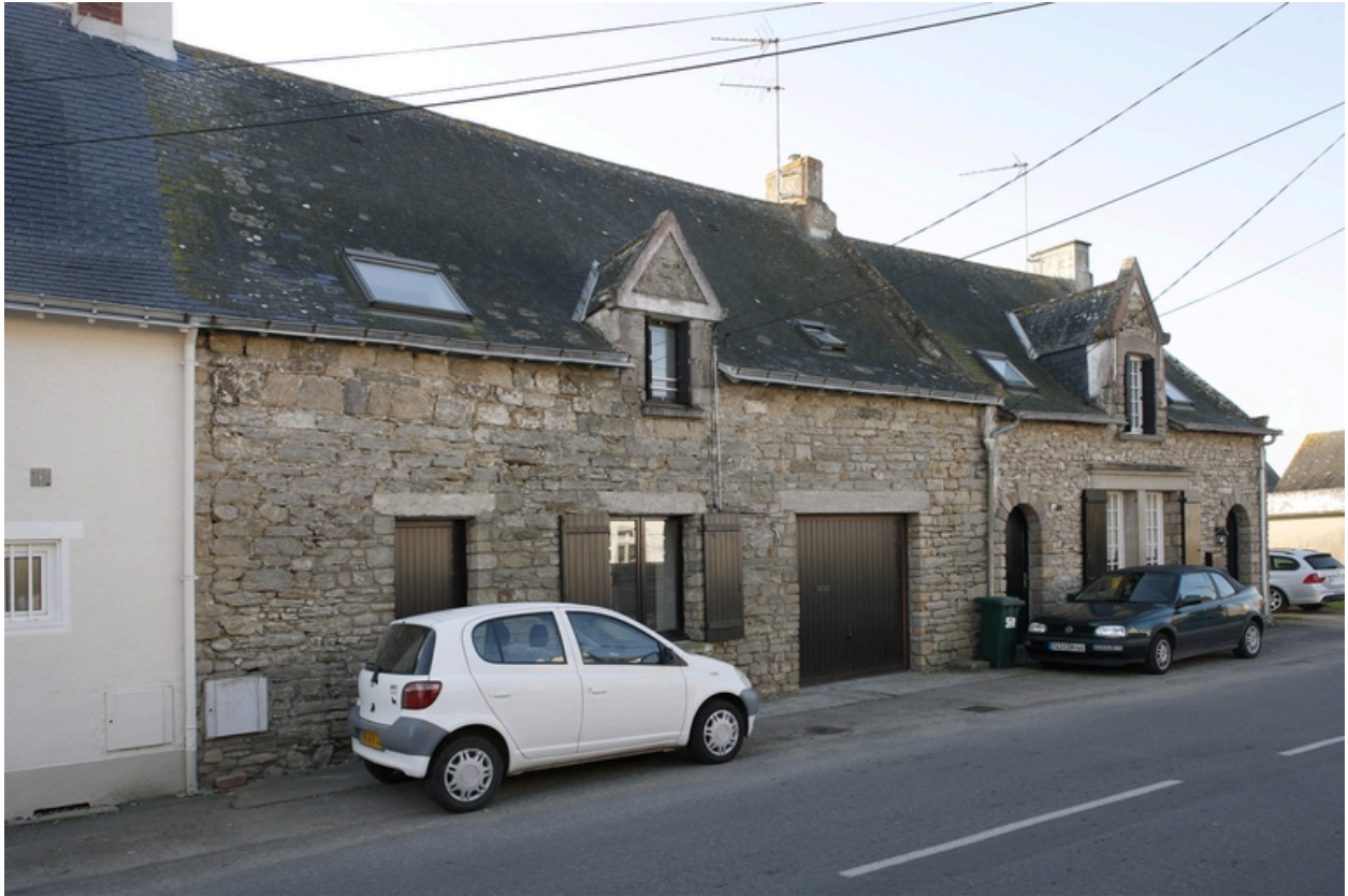
Vue des n° 24 et 26 de la rue du Ber.
