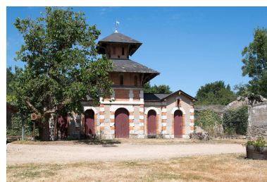
Vue de la volière depuis le sud-est. Phot. Armelle Maugin IVR52_20194900522NUCA
