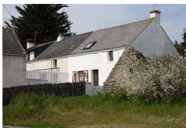
Vue d'ensemble depuis l'est. Phot. Denis Pillet IVR52_20084401508NUCA
