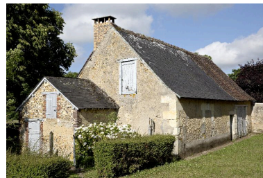
Vue de volume avec façade postérieure. Phot. Pierre-Bernard Fourny IVR52_20147200445NUCA
