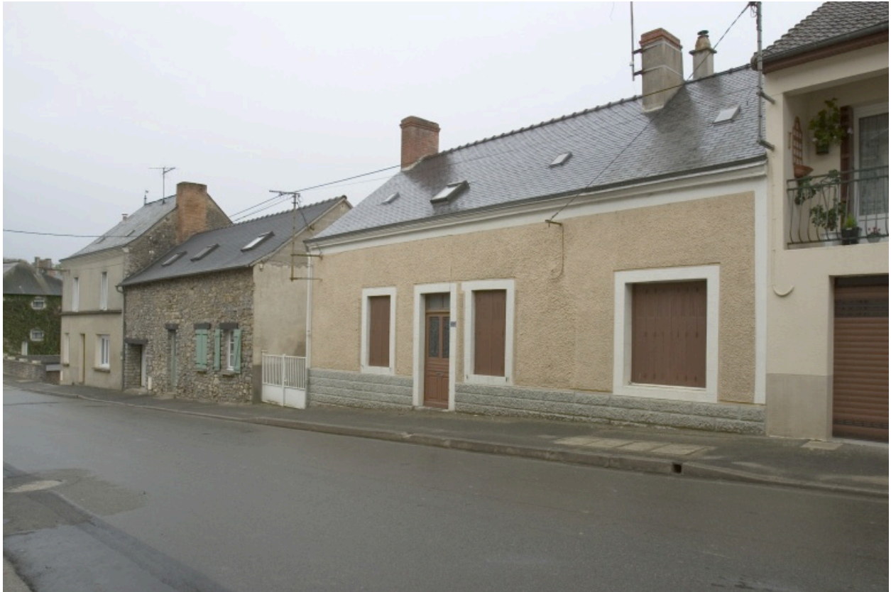
Vue depuis la rue. La maison est la deuxième à gauche.
