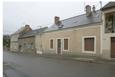
Vue depuis la rue. La maison est la deuxième à gauche. Phot. François Lasa IVR52_20045303346NUCA
