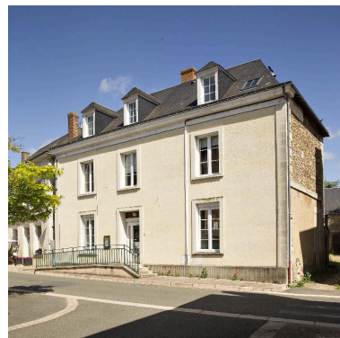
Chahaignes, ancien hôtel de voyageurs dit du Faisan : 17, place de l'Église. Façade sur rue. Phot. Pierre-Bernard Fourny IVR52_20177200385NUCA
