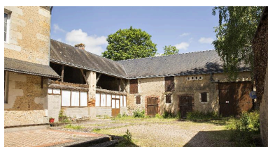
Chahaignes, ancien hôtel de voyageurs dit du Faisan : cour avec dépendances. Phot. Pierre-Bernard Fourny IVR52_20177200387NUCA
