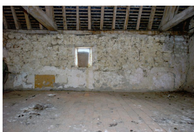
Le logis, premier étage actuel. Phot. David Huard
