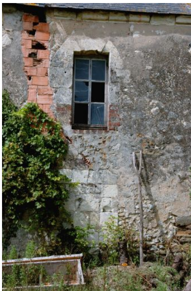
Élévation face à l'entrée, détail. Phot. David Huard IVR52_20047205575NUCA
