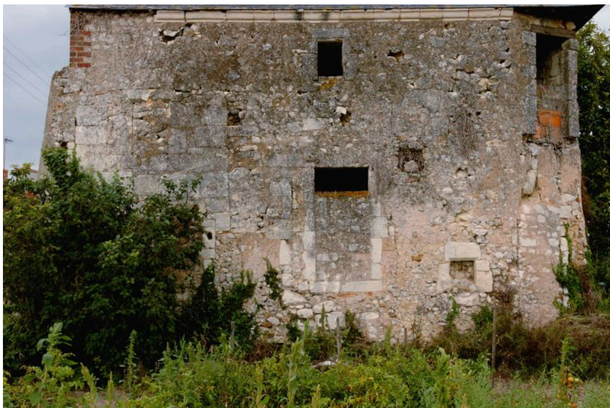
Façade sur le jardin : détail.
