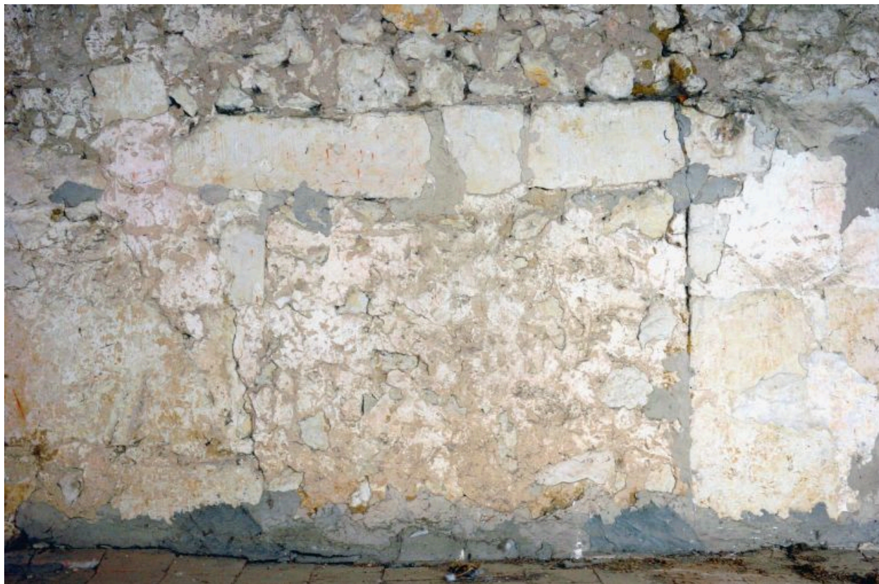
Le logis, premier étage : porte coupée.
