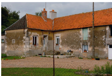
Les communs, détail. Phot. David Huard IVR52_20047205565NUCA
