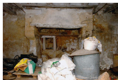
Rez-de-chaussée, aile en retour : cheminée. Phot. David Huard IVR52_20047205566NUCA
