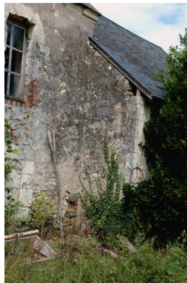
Aile de l'entrée : appentis. Phot. David Huard IVR52_20047205574NUCA
