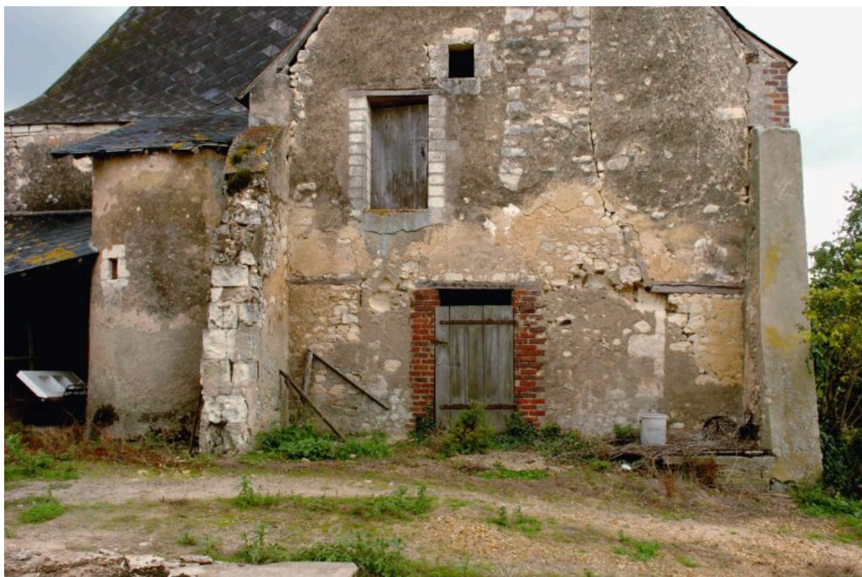
Le logis, mur de refend très remanié.
