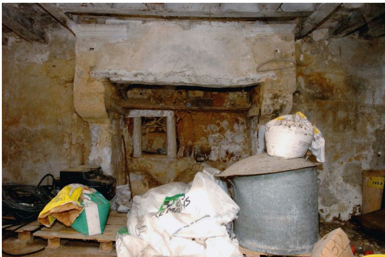
Rez-de-chaussée, aile en retour : cheminée.
