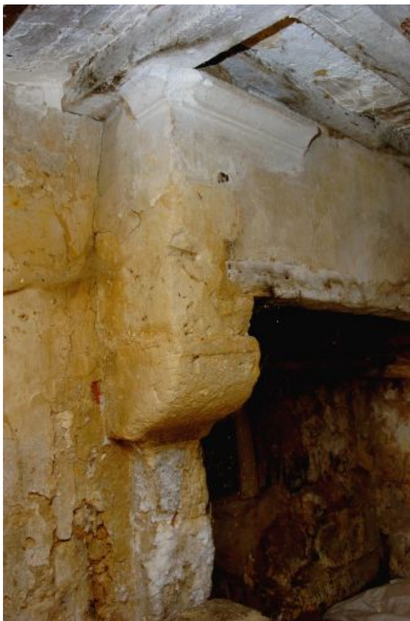
Rez-de-chaussée, cheminée : le piédroit.
