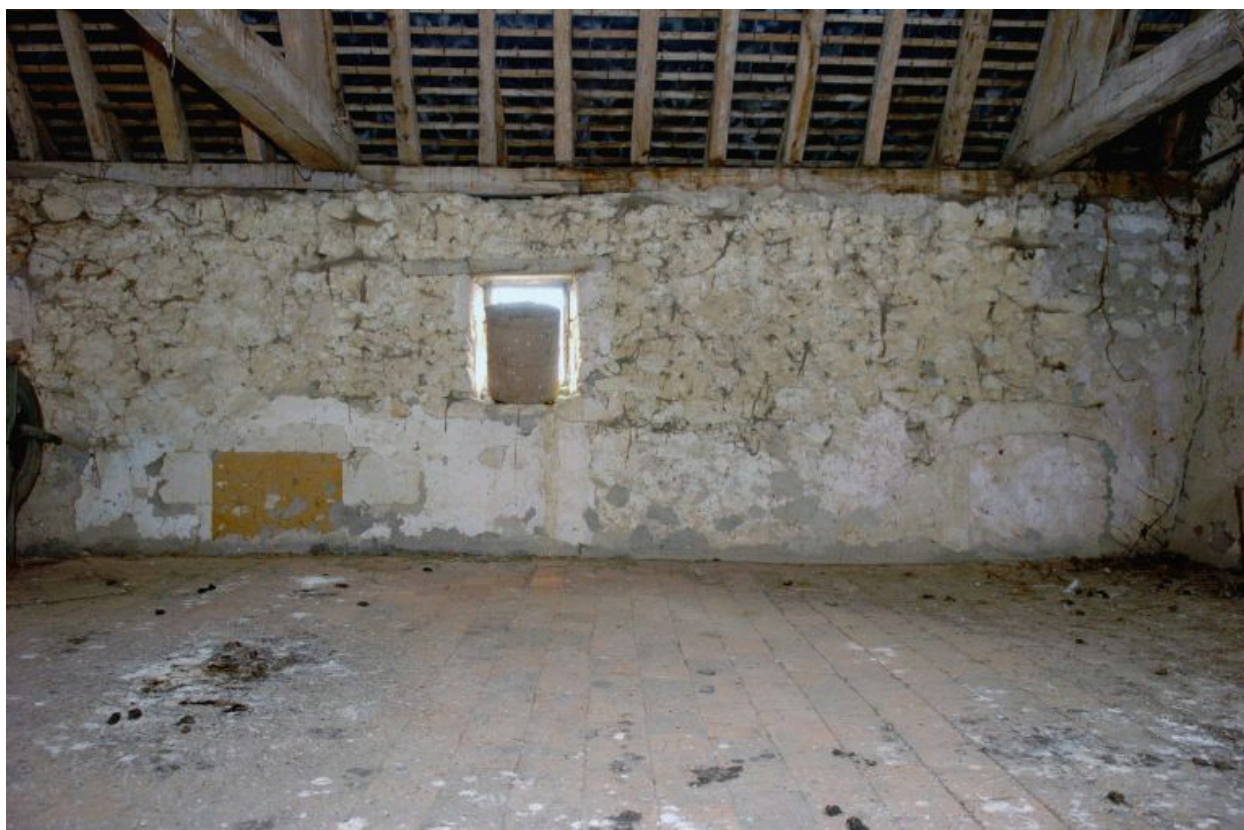
Le logis, premier étage actuel.
