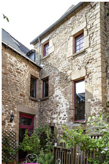
Angle formé par le corps de logis principal et la tour de logis, côté cour. Phot. Yves Guillotin IVR52_20215300745NUCA
