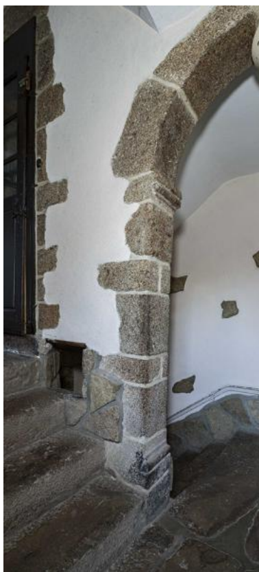
Départ de l'arcade prolongeant le mur-noyau de l'escalier rampe-sur-rampe. Phot. Yves Guillotin IVR52_20215301783NUCA
