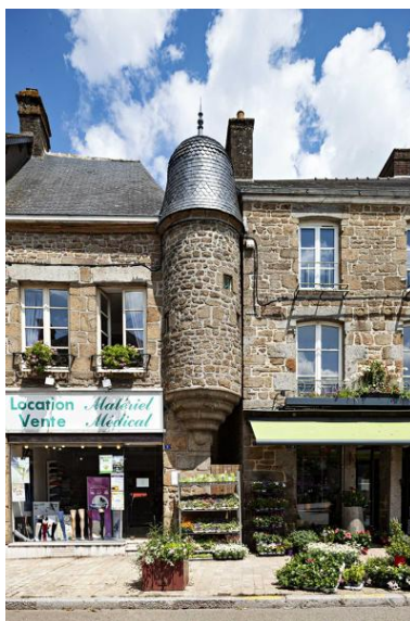
Façade côté Grande-Rue. Phot. Yves Guillotin IVR52_20215300781NUCA
