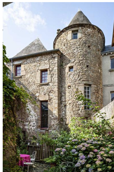
Tours d'escalier situées à l'arrière du 25 rue Dorée et du 7 Grande-Rue. Phot. Yves Guillotin IVR52_20215300744NUCA
