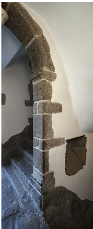
Départ de l'arcade prolongeant le mur-noyau de l'escalier rampe-sur-rampe. Phot. Yves Guillotin IVR52_20215301781NUCA
