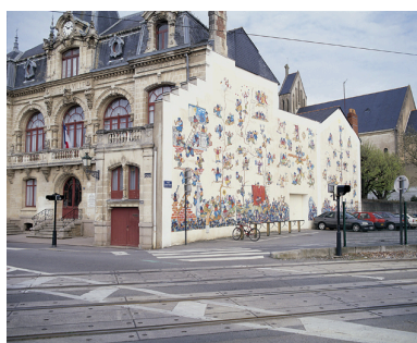
Vue d'ensemble. Phot. Denis Pillet IVR52_20004400811XA
