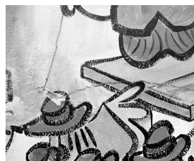
Partie gauche, détail : fissure permettant de visualiser la stratigraphie. Phot. Denis Pillet IVR52_20004400799X
