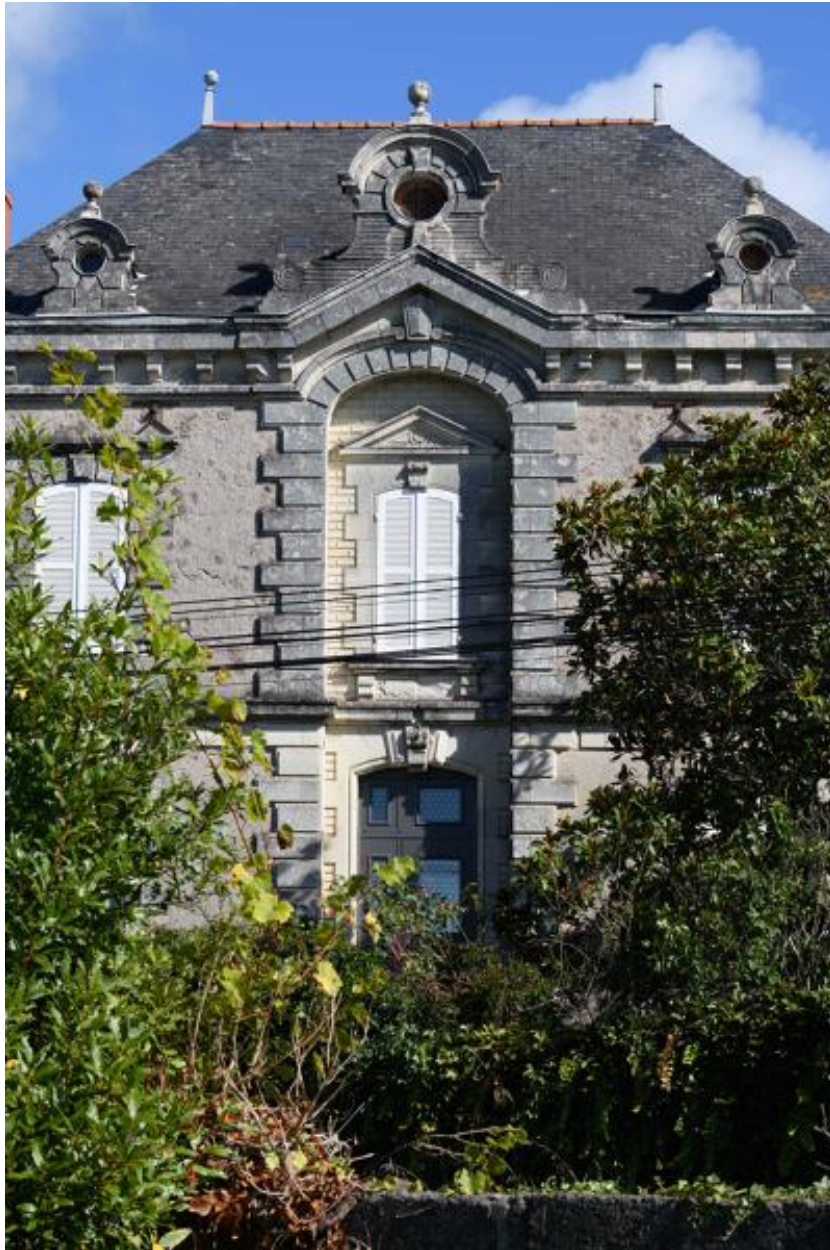
Détail de la façade principale, maison dite Villa Madeleine, le Grand Clos, Montjean-sur-Loire.
