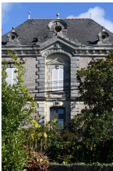
Détail de la façade principale, maison dite Villa Madeleine, le Grand Clos, Montjean-sur-Loire. Phot. Armelle Maugin IVR52_20244900856NUCA
